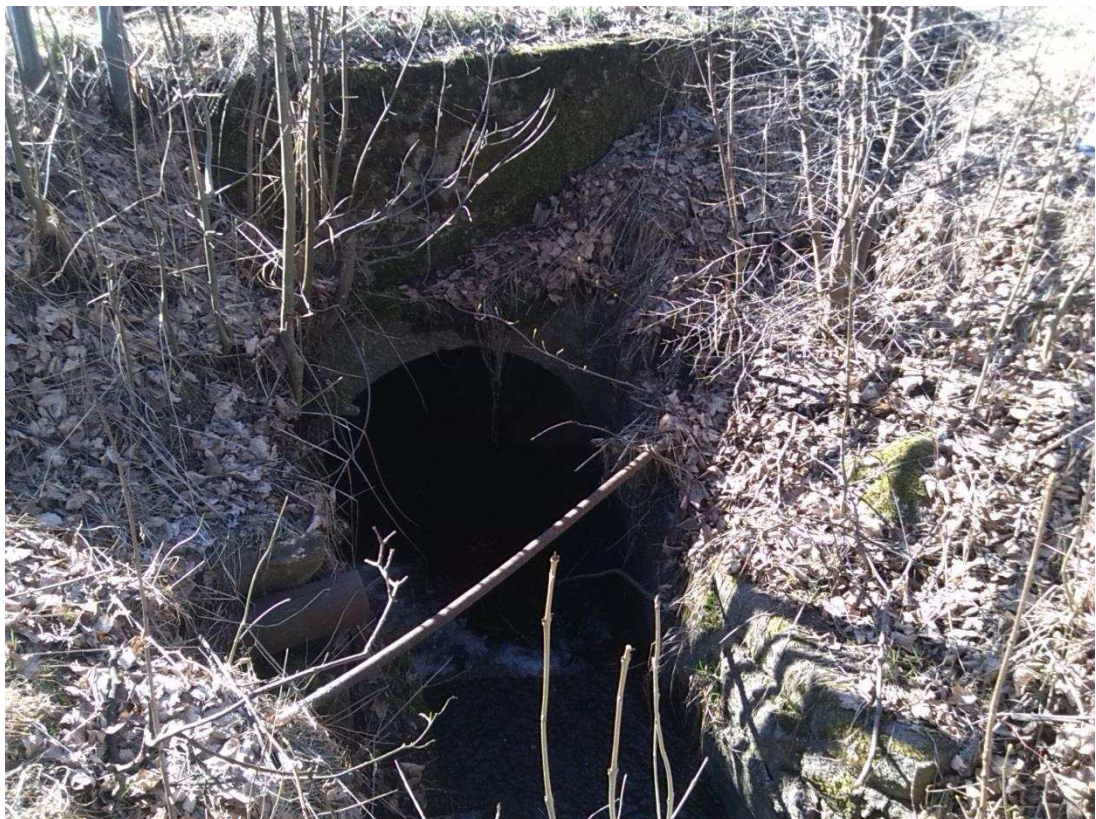
Obr. č.16 – Čelo trubního propustku
