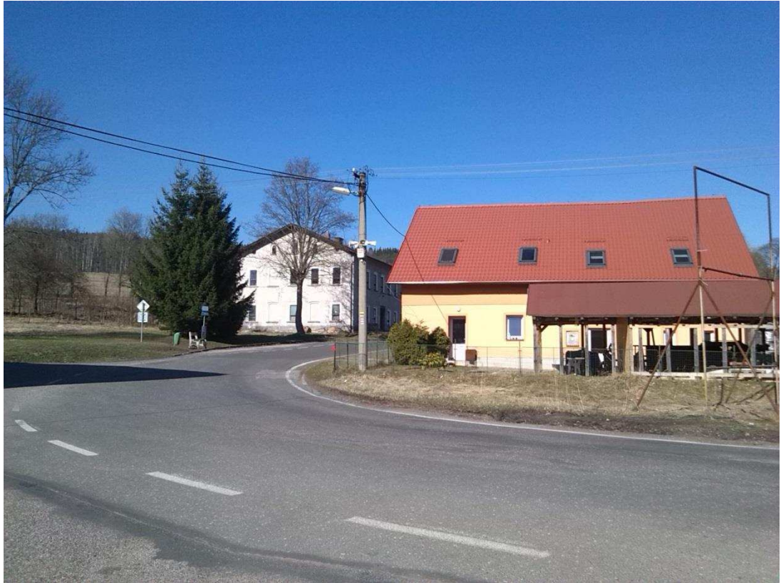
Obr. č.7 – Pohled na křižovatku ve směrovém oblouku
