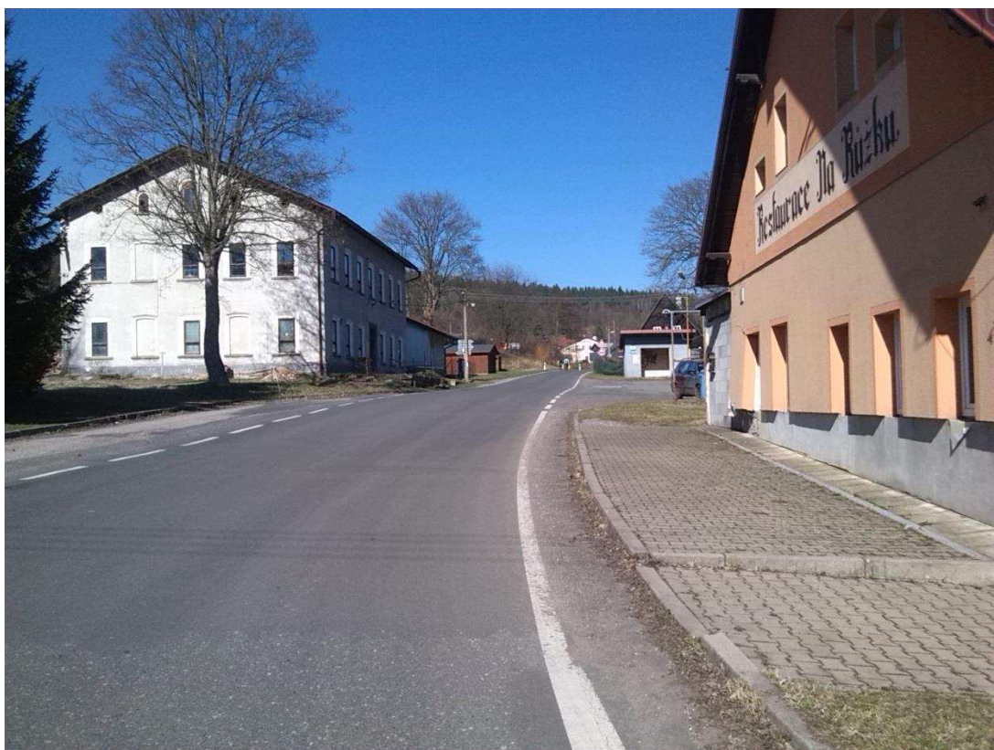
Obr. č.1 – Pohled na přímý úsek silnice II/301 od počátku trasy
