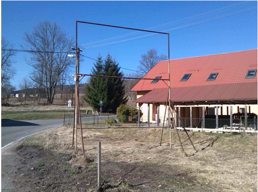
Obr. č.15 – Špatné odvodnění komunikace; konstrukce reklamního billboardu
