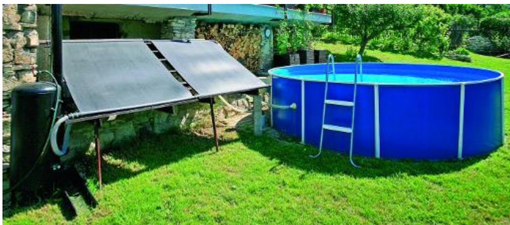
Obrázek 1.10 – Ohřev bazénové vody pomocí plastového absorbéru
