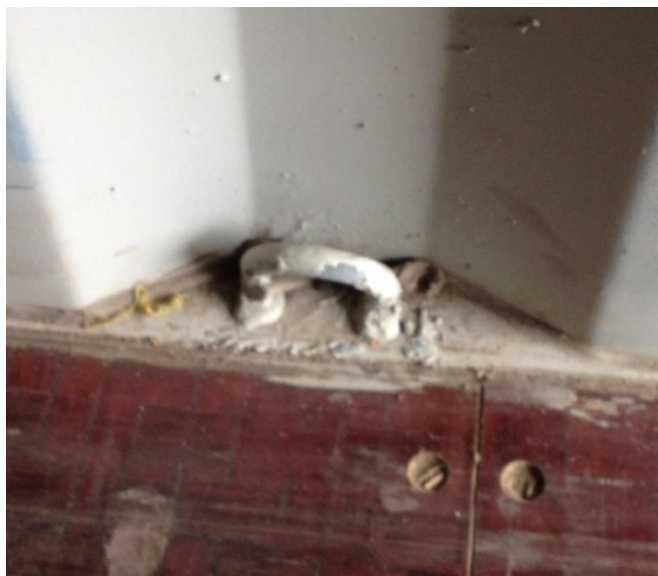
Obrázek 21: Kotevní prvek v podlaze kontejneru
