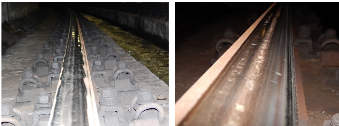
Obr. 4 Detail vnitřní kolejnice (vlevo) a vnější kolejnice (vpravo)
