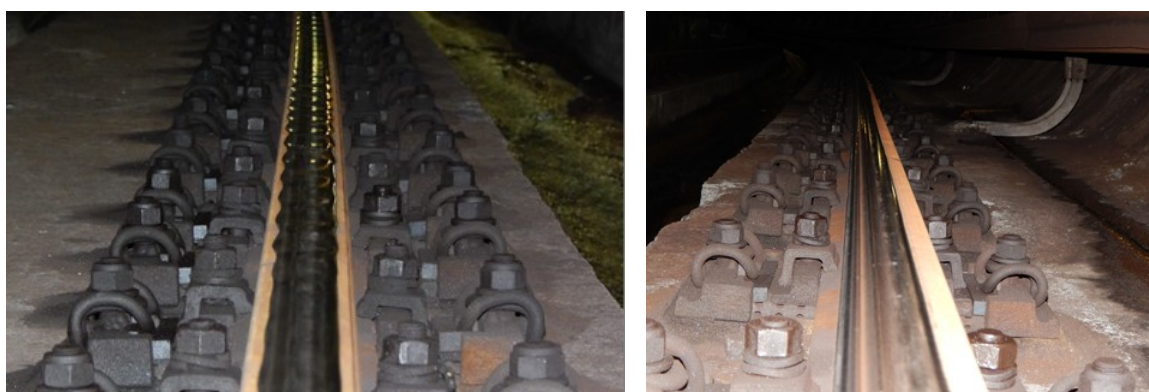
Obr. 3 Detail vnitřní kolejnice (vlevo) a vnější kolejnice (vpravo)
