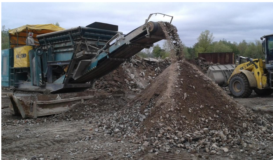
Obrázek 4 – Čelistový drtič v činnosti – betonový recyklát frakce 0/80
