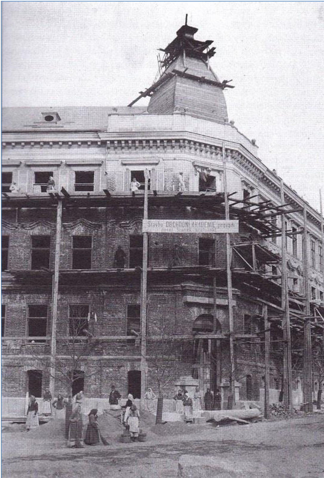
Fotka z průběhu stavby budovy obchodní akademie Chrudim, r. 1893.
