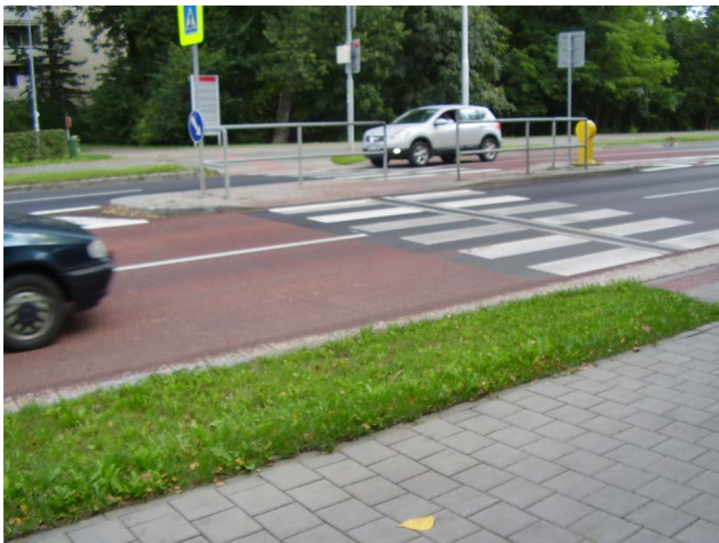
Obr. 6 - Barevný povrch vozovky s vysokým smykovým třením u přechodu pro chodce na ulici Hradecká v Pardubicích
