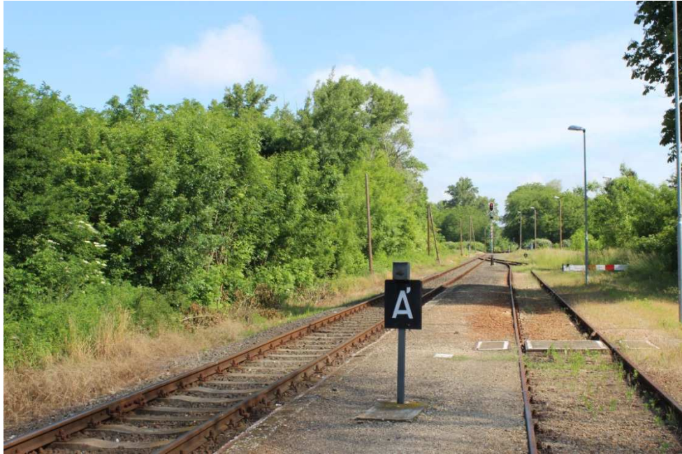
Obrázek L.1 V dopravě Egyed-Rábacsanak pohled na návěstidlo s návěstí „A“ (místo zastavení), ovládací skříňku PZS a v pozadí kontrolní návěstidlo pro vedlejší tratě označené VE
