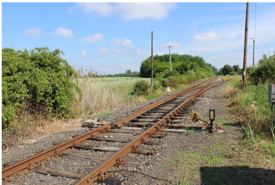
Obrázek L.2 Výhybka se samovratným (pérovým) přestavníkem v dopravě Egyed-Rábacsanak
