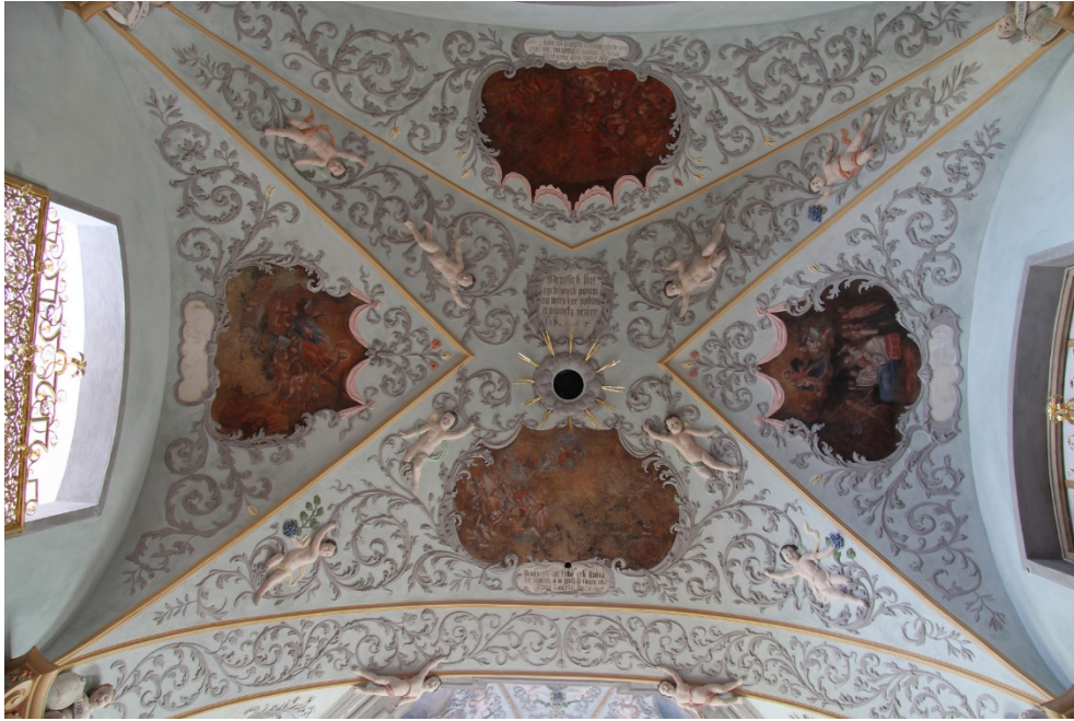
Obrázek 114- celkový pohled do klenby západní části presbyteria. Stav po restaurování v roce 2013. Zdroj: BARTŮŇKOVÁ, Lucie, VOJTĚCHOVSKÝ, Jan. Restaurátorský průzkum a dokumentace: Restaurování nástěnných maleb v kupoli presbytáře, Restaurátorská dokumentace, Litomyšl 2013
