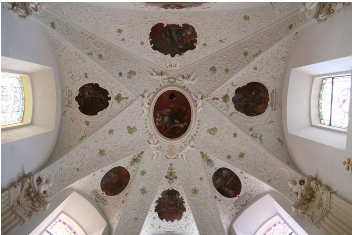
Obrázek 118 – Celkový pohled do kaple sv. Josefa. Stav po restaurování.
