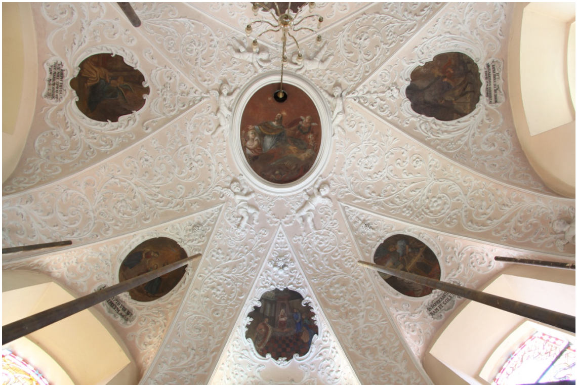
Obrázek 119 – Celkový pohled do kaple sv. Josefa. Stav před restaurováním.
