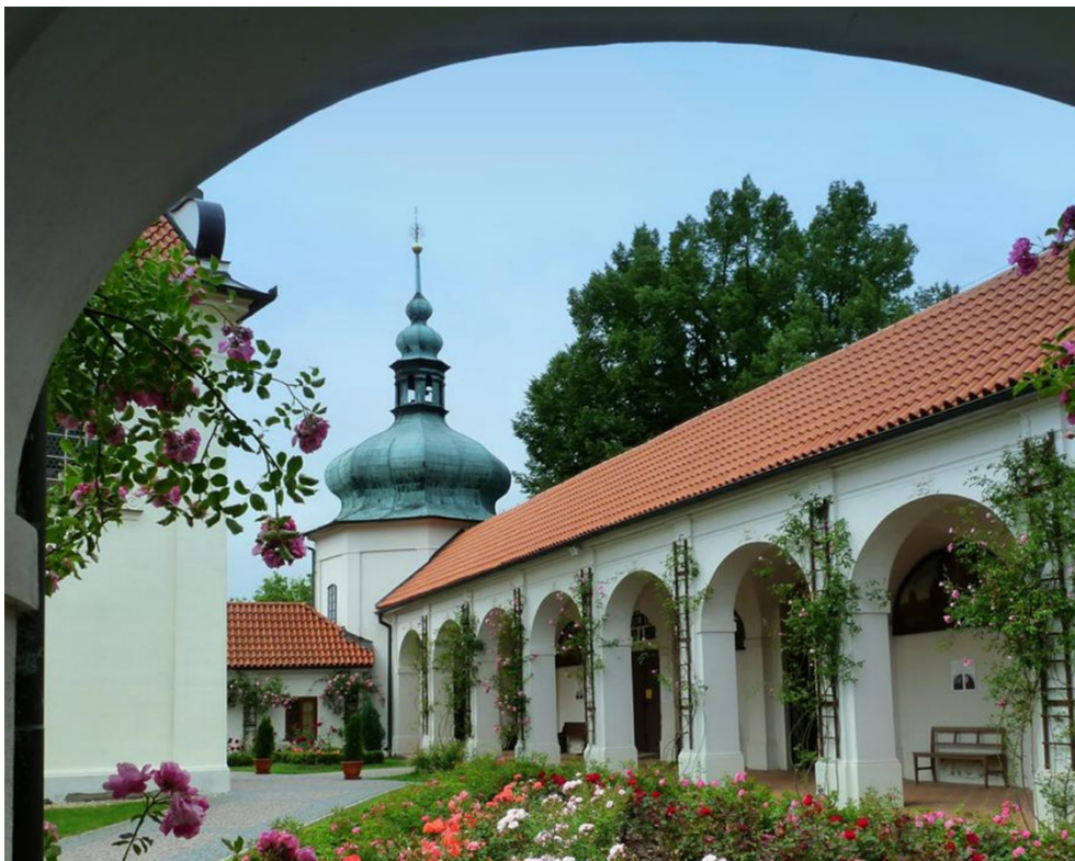
Obrázek 117 – pohled směrem od severního vchodu do areálu na ambitovou chodbu s lunetovými nástěnnými obrazy.
