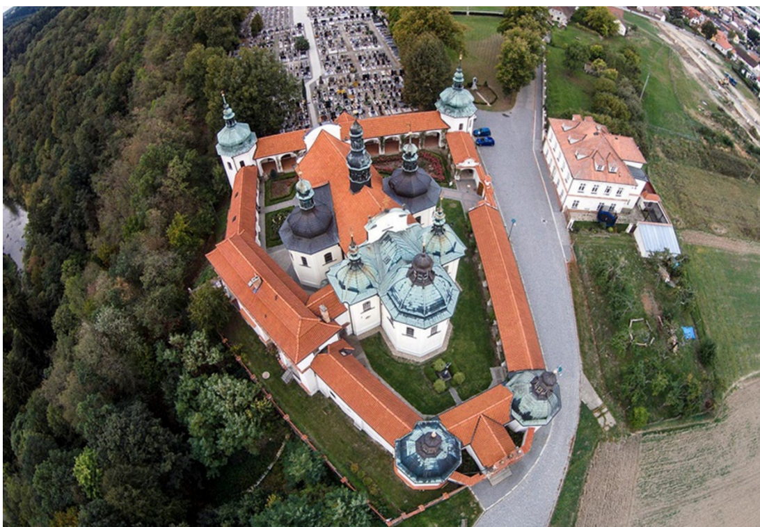
Obrázek 108 – Pohled z výšky na areál klokotského kostela v současnosti.
