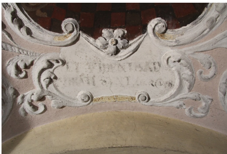
Obrázek 26 – nápisové pole pod výjevem Dvanáctiletý Ježíš v chrámu. Stav po sejmutí druhotných vrstev. Z dochovaných fragmentů textu bylo následně možné dohledat původní znění latinského textu.
