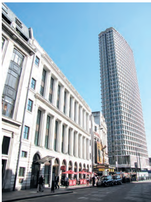
Obr. 7 (vlevo) Klasicistní budova v popředí: Quinlan Terry, 264–267 Tottenham Court Road, Londýn, 2004–2009. V řadu: Richard Seifert, Centre Point Tower, Londýn, 1963–1966, od roku 1995 kulturní památka druhého stupně. (Foto M. Horáček, 2012)
