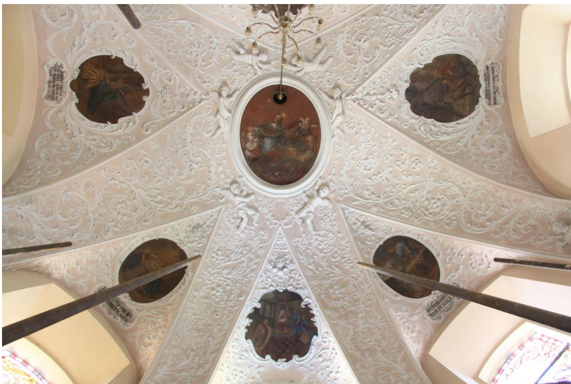
Obr. 55: Celkový pohled do klenby kaple sv. Václava – stav před restaurováním.
