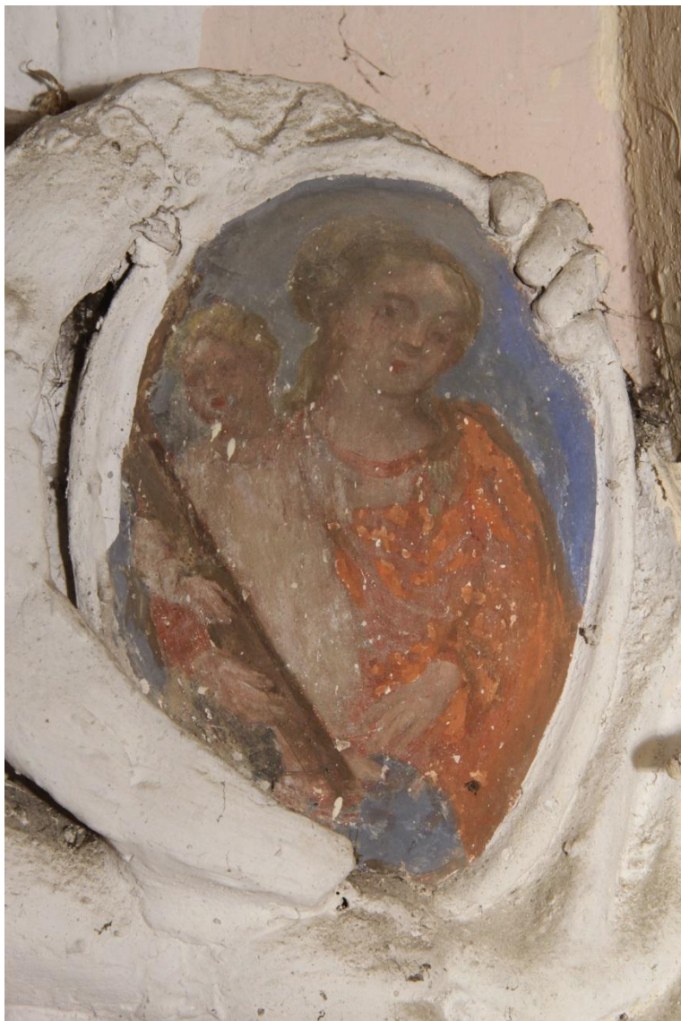
Obr. 64: Detail štítu putto na jihovýchodním pilastru – stav před restaurováním.
