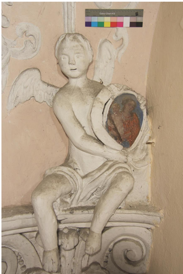
Obr. 63: Pohled na postavu putto na jihovýchodním pilastru – stav před restaurováním.
