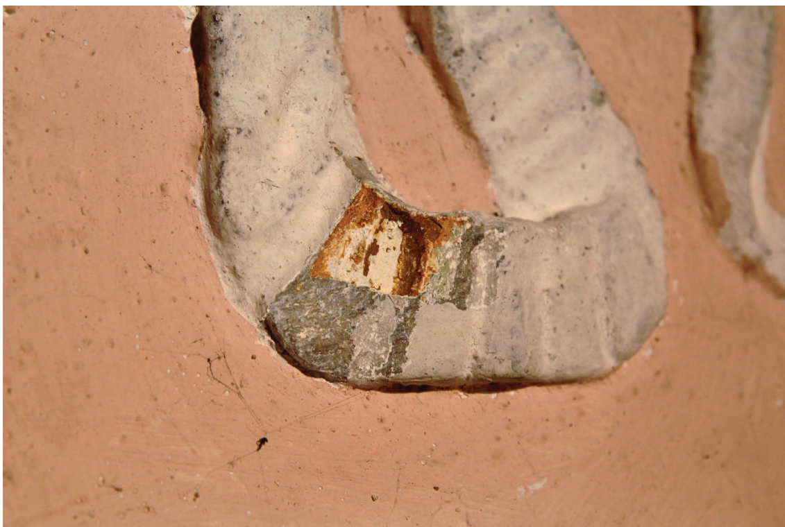
Obr. 25: Sonda S3 na štuku pod výjavom na klenbe. Stratigrafická sonda farebných úprav na štuku. Popis vrstvy: 0.svetlý vápenný štuk, 1. vrstva okrovo žltej so zlátením, 2.svetlo zelený náter, 3.tmavo šedý náter, 4. svetlo šedý náter, 5. tmavo šedý náter, 6. niekoľko vrstiev bieleho vápenného náteru.
