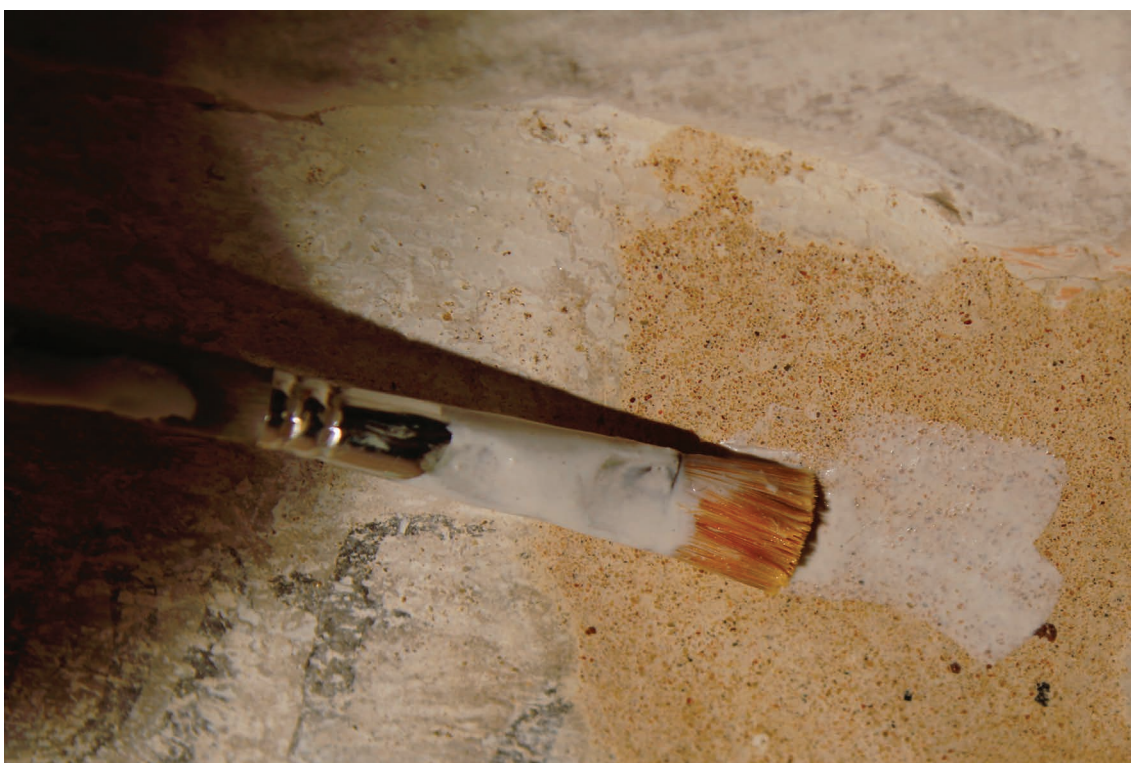
Obr. 43: Detail na oblasť v písme pod výjavom. Postup prác - natieranie vrstvy vápenného náteru..
