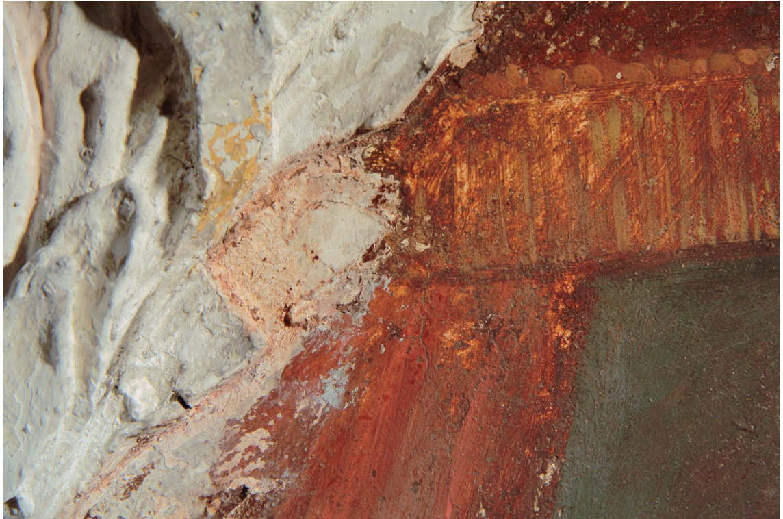
Obr. 69: Detail na chýbajúci list z časti štukového rámu v okolí maľby. Stav pred reštaurovaním.
