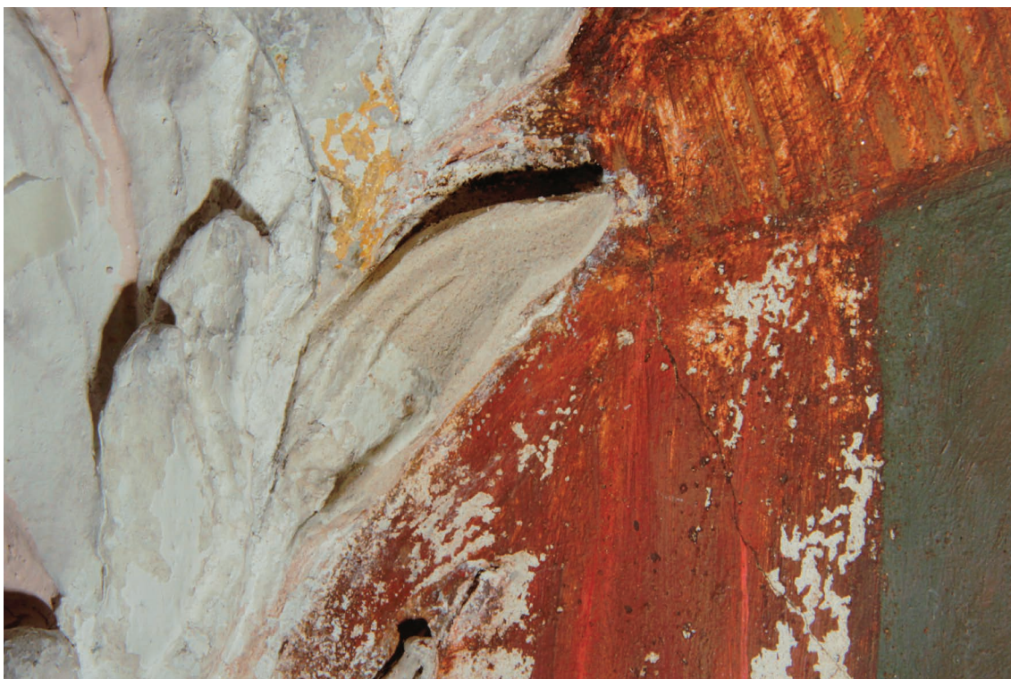
Obr. 71: Detail na doplnený list z časti štukového rámu v okolí maľby. Stav v priebehu prác, po vymodelovaní chýbajúcej časti štuku.
