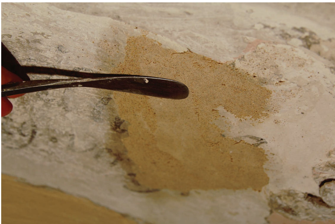
Obr. 42: Detail na oblasť v písme pod výjavom. Postup prác - tmelenie.
