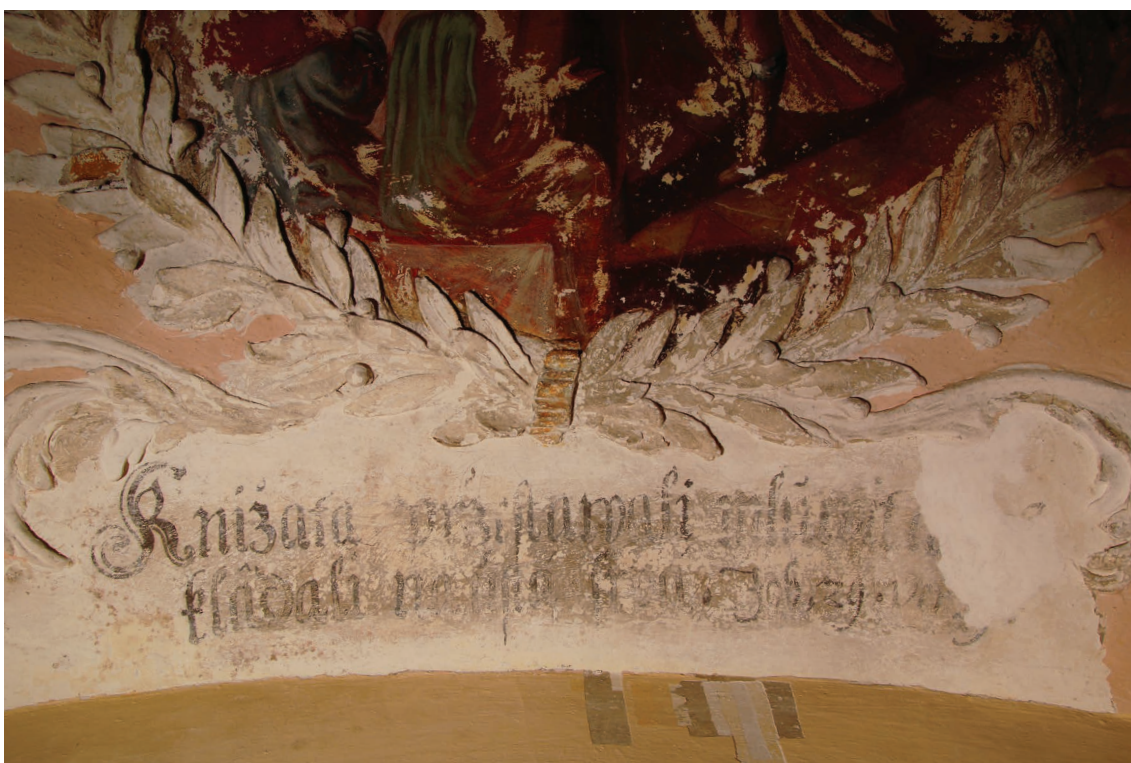
Obr. 73: Detail na nápis pod výjavom v klenbe. Stav po očistení povrchu maľby a po vytmelení len naväčšieho tmelu.
