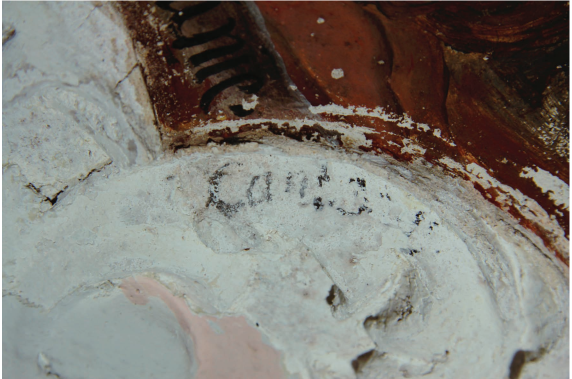
Obr. 48: Detail na štukový rám vo víťaznom oblúku. Stav po očistení - zostatky originálneho nápisu na štuku odkazujúceho sa na Bibliu.
