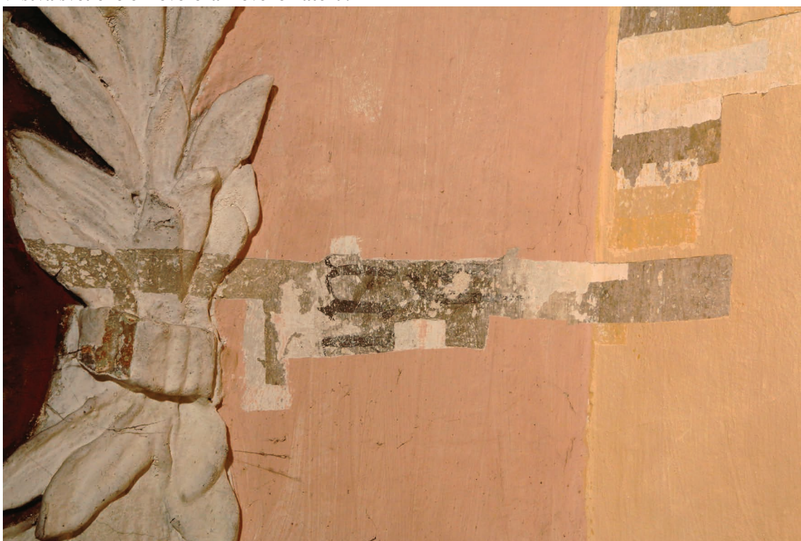
Obr. 24: Sonda S1 na stene pod výjavom na klenbe „ Sv. Václav sprevádzaný anjelmi prichádza do snemu ríšskych kniežat “. Stratigrafická sonda farebných vrstiev. Popis vrstiev: 0.svetlý podklad, vápenný náter, 1. tmavo šedý náter, 2.svetlo šedý náter, 3. 1-2 vrstvy bieleho vápenného náteru, 4. vrstva svetlého okrovo-oranžového náteru, 5. vrstva svetlá došeda náteru, (možné nečistoty), 6. vrstva svetlého okrovo-oranžového náteru.
