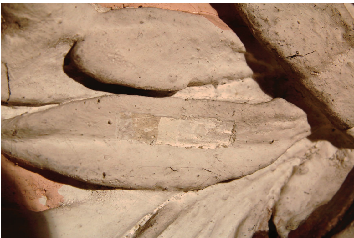
Obr. 26: Sonda S4 na štuku v okolí výjavu na klenbe. Stratigrafická sonda má rovnaké vrstvy ako sonda S3 na obr. 25, akurát chýba vrstva zlátenia.
