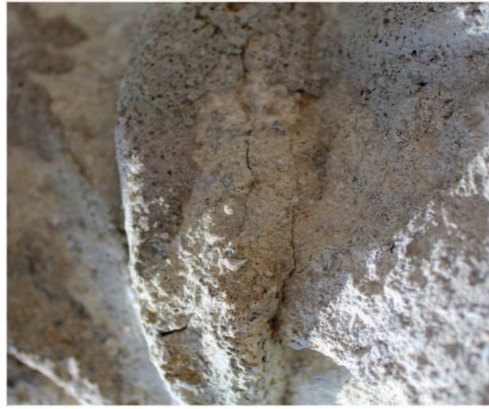
postupná degradace vápence pod tmelem s řádově vyšší pevností a nižší propustností, sousoší sv. rodina, Telč 2016
