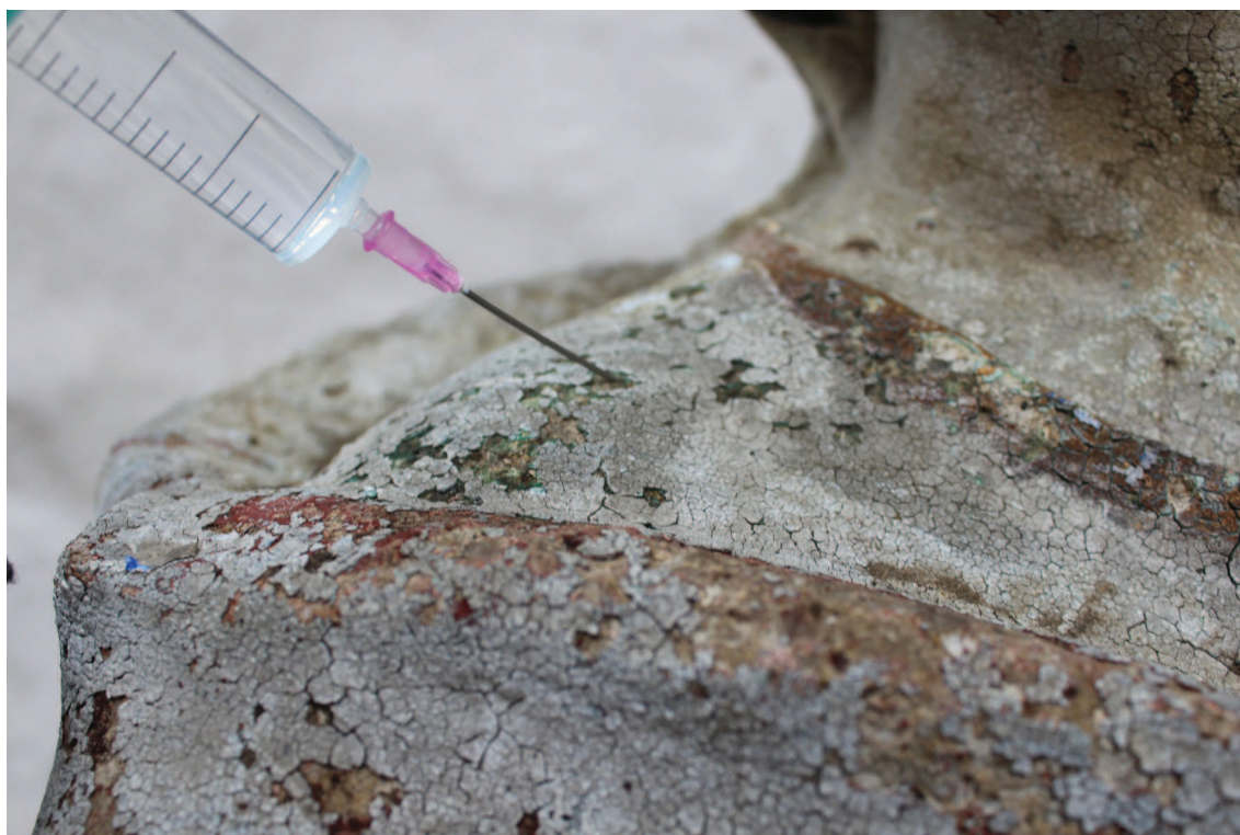
obr 19: průběh konsolidace kamene
