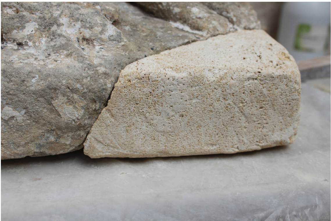
obr 38: průběh zhotovení doplňku soklu
