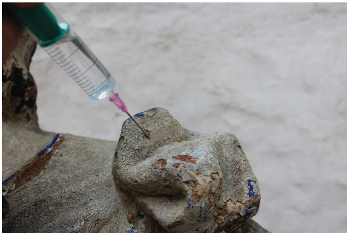
obr 20: průběh konsolidace kamene
