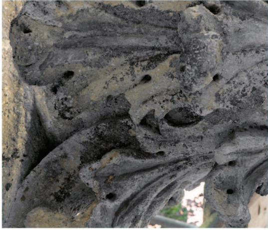
degradace povrchu pod krustami hlavičky mariánské sloupu, Krasovice 2006
