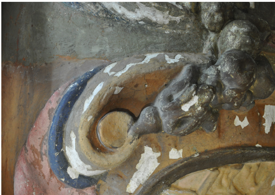
Obrázek 24 - Fotografie krakelů po zažehlení.
