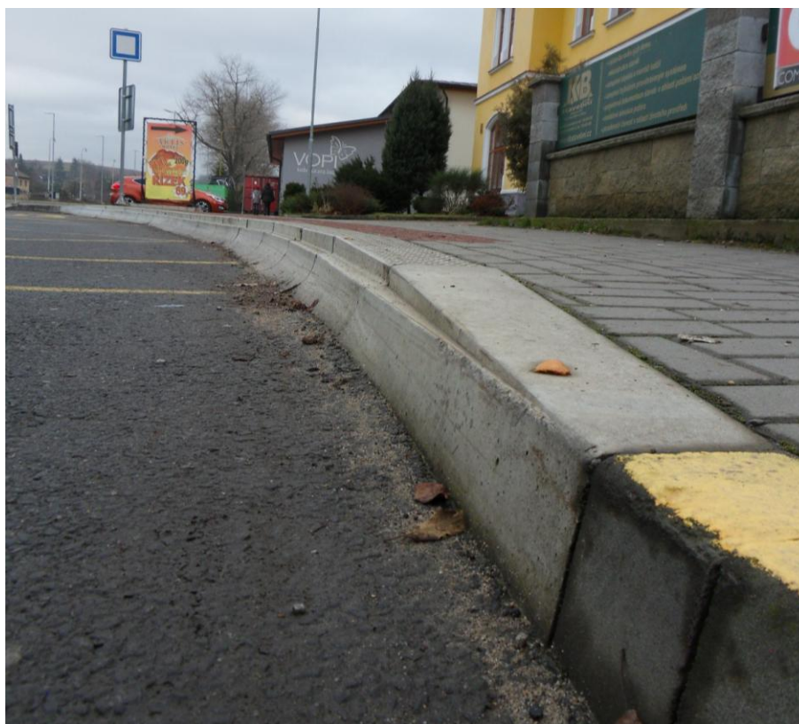
Obrázek 4: Detail zastávkového obrubníku (autor)
