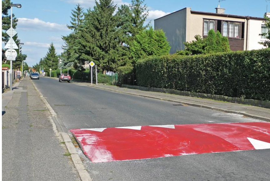
Obrázek 19 – Vlnový, kruhový tvar zpomalovacího tvaru [24]
