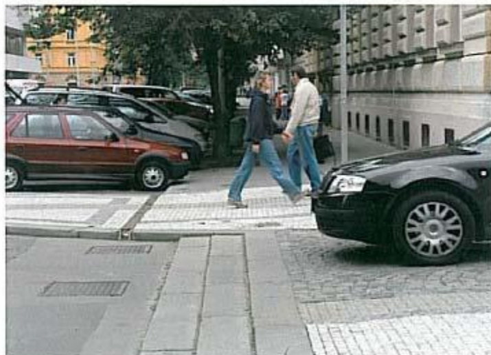
Obrázek 18 - Stupňovitý tvar zpomalovacího prahu [23]
