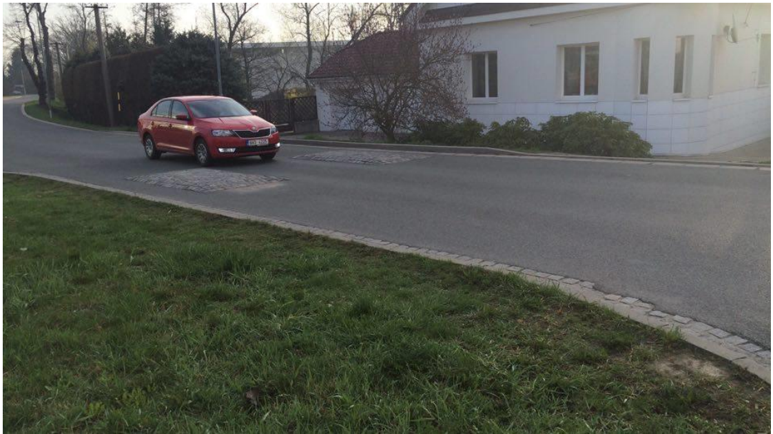
Obrázek 26 - Ukázka špatného umístění polštářů na stanovišti č. 1
