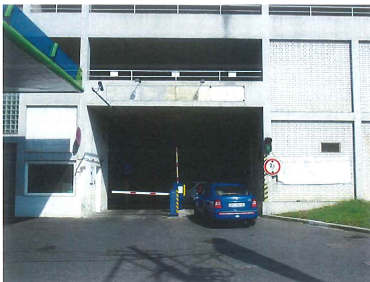
Obrázek 20 Vjezd do parkovacího domu pod Mariánskou skálou (Lukáš, 2014)
