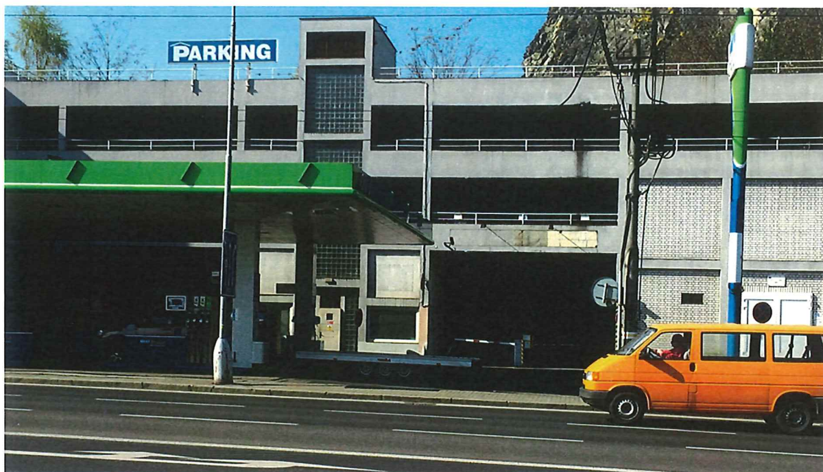
Vjezd do parkovacího domu pod Mariánskou skálou (autor)
