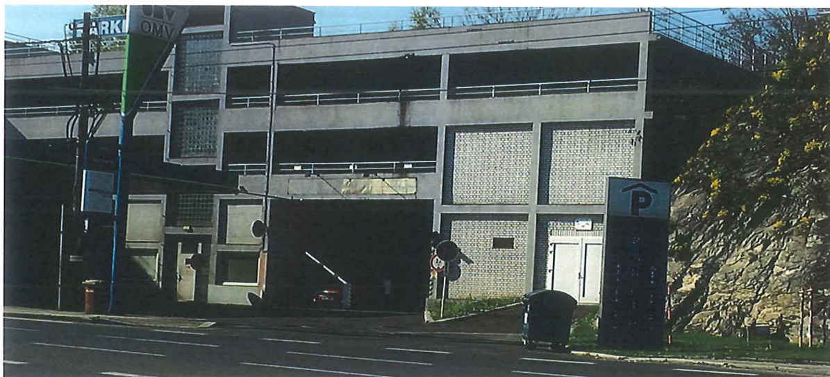
Označení parkoviště informativní dopravní značkou „Kryté parkoviště“ ze směru Děčín, (autor)
