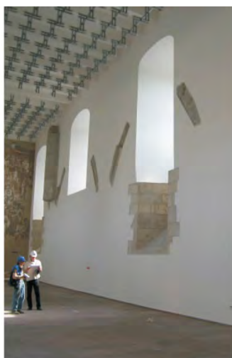
stav obnovy po 1. etape realizácie - 70-te roky 20. storočia
