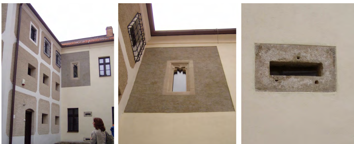
Obr. 13 Príklad zadného radničného krídla v Trnave. Vedľa objektu väznice domu vidíme prezentáciu jedného z trojice unikátnych gotických okien stredovekej radnice. Prezentované gotické okno je kópiou, vyhotovenou podľa dvoch zachovaných gotických okien, prezentovaných v interiéri radnice. Okno je prezentované aj s plochou rekonštruovanej gotickej omietky. Druhá prezentovaná sonda – pôvodný kamenný prvok, zakonzervovaný. Stret stredoveku s mladšou povrchovou úpravou ilustrujú obe sondy (ilustrácia plastického princípu č. 7) (foto: K. Palgutová)
