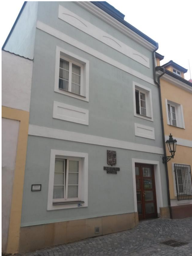
Obr. 5 Budova čp. 7/1, stav v roce 2015
