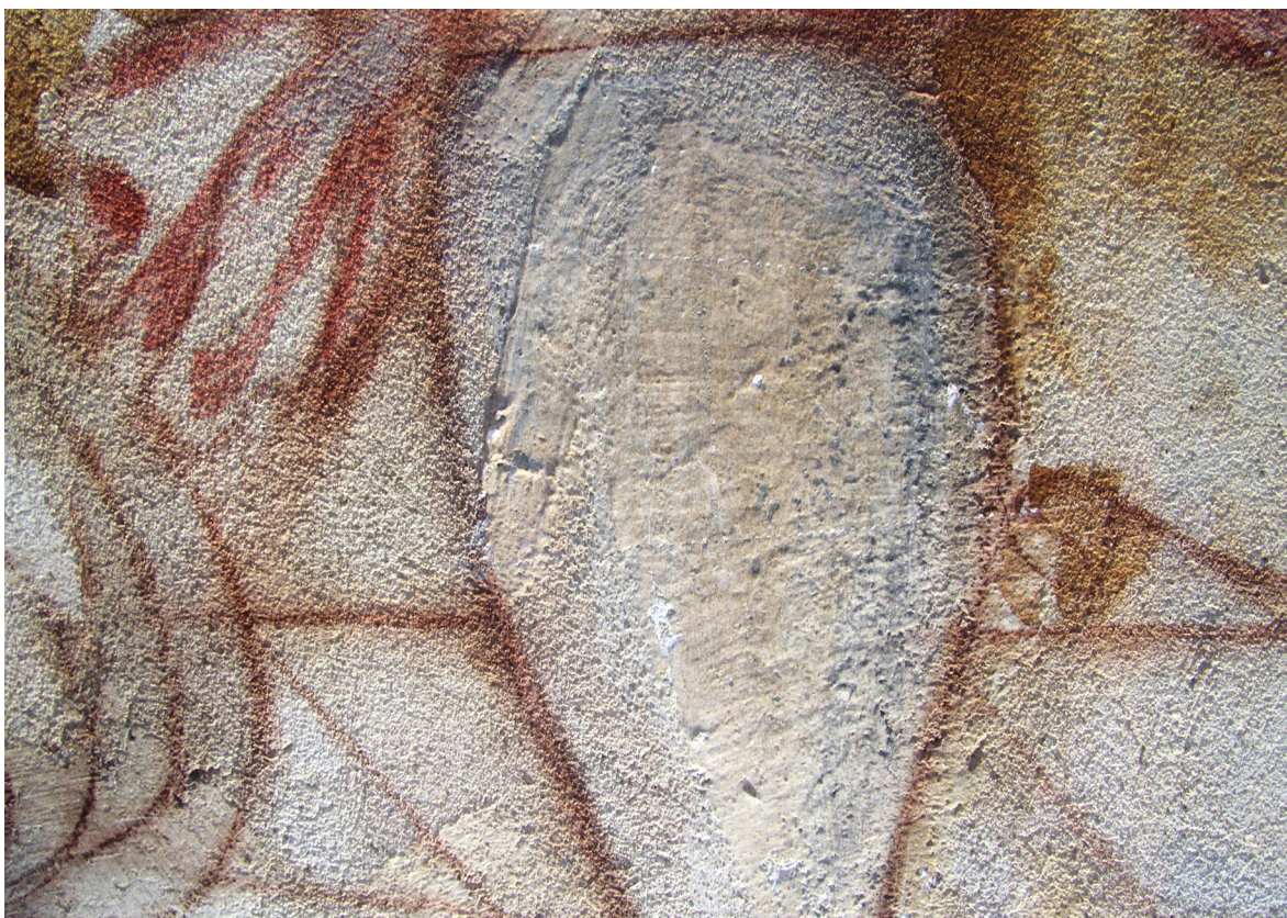
Obr. 57: Detail výjavu č. 1. Stav pred reštaurovaním v razantnom bočnom osvetlení. Je možné vidieť pastózny nános bielob v spodnej časti výjavu. V svetle sa zvýraznila hrubá štruktúra omietky.
