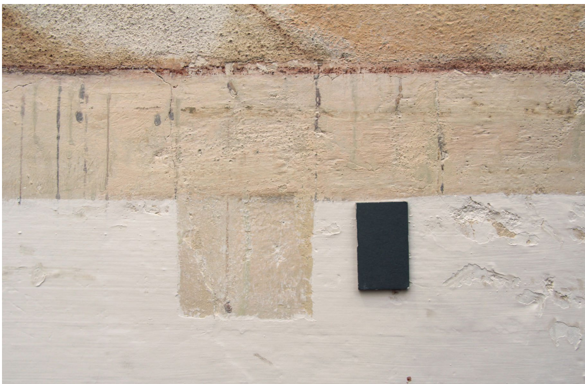
Obr. 71: Detail na stratigrafickú sondu, v mieste hranici soklu a výmalby výjavu č. 1. Stav pred reštaurovaním v dennom rozptýlenom svetle. Na fotografii je vidieť okrový náter a fragmenty linkovania. Z pod čiastočne stretého náteru je možné pozorovať stekance tmavo hnedej farby.
