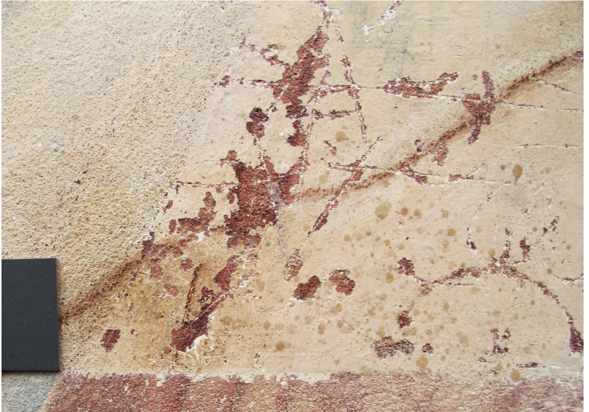
Obr. 55: Detail výjavu č. 1 ľavej dolnej časti. Stav pred reštaurovaním v dennom rozptýlenom svetle. Poškodenie farebnej vrstvy v pastách vrypni vulgarizmov. Defekty odkrývajú prvú maľbu.
