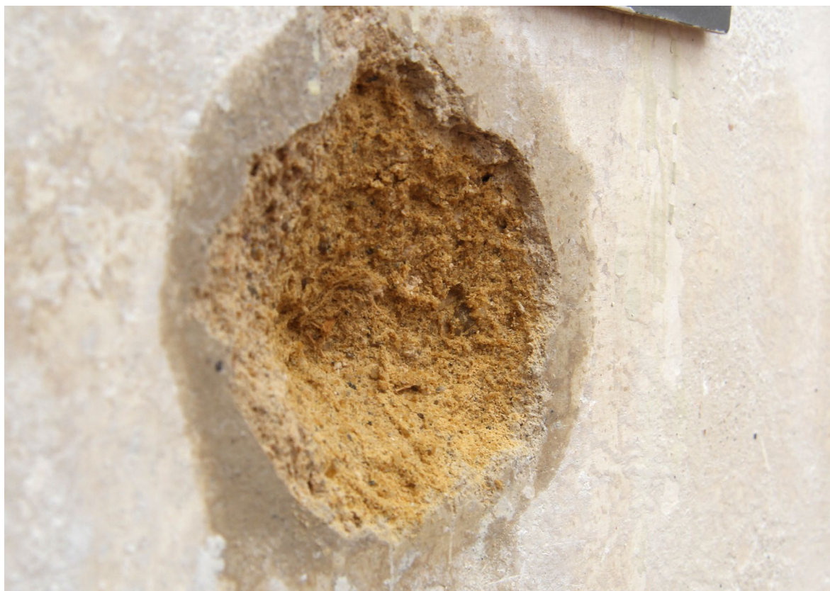
Obr. 81: Detail na jeden z hĺbkového defektu v soklovej časti. Stav tesne po aplikácie konsolidantu KSE v dennom rozptýlenom svetle. Je možné vidieť farbu a skladbu štuku.
