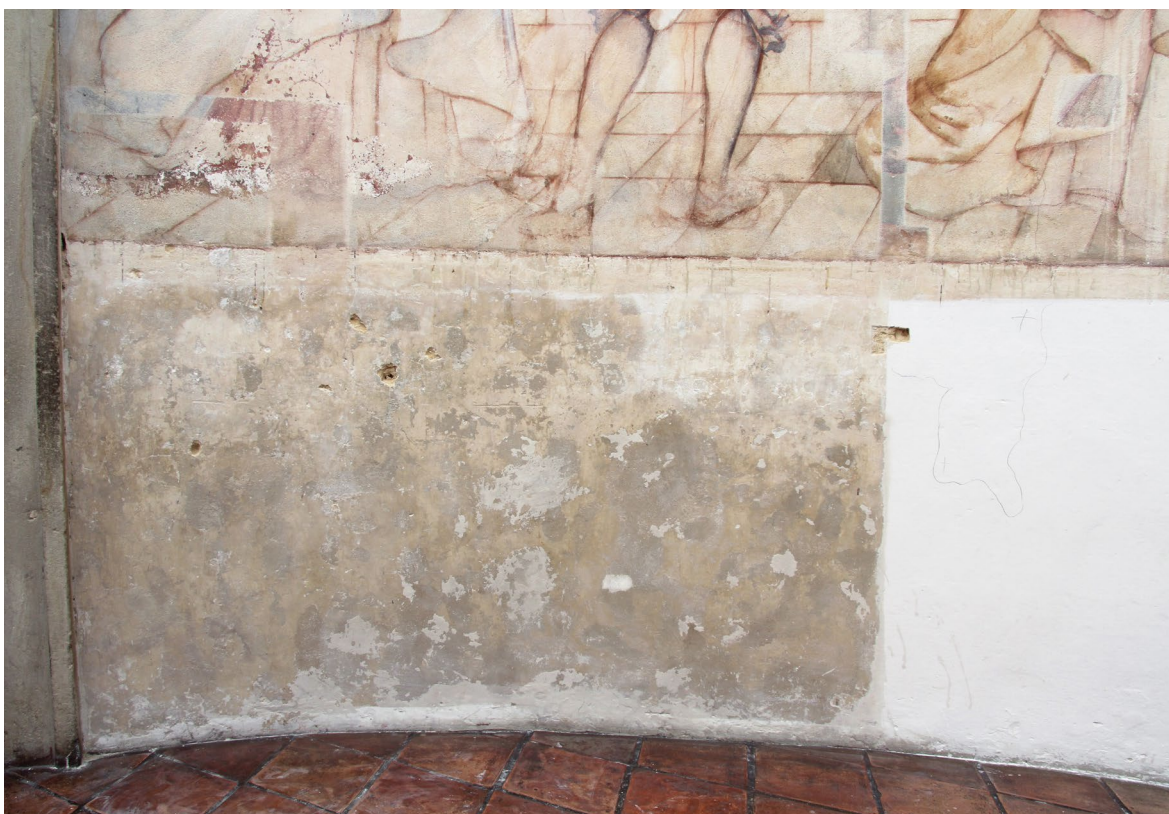
Obr. 76: Ľavá časť soklu po čiastočnom odstránení bieleho hlinkového náteru. Povrch štku bol opravovaný množstvom tmelov rôzneho materiálu. Tiež je možné vidieť nerovnomerné sfarbenie his. štku v tomto mieste.
