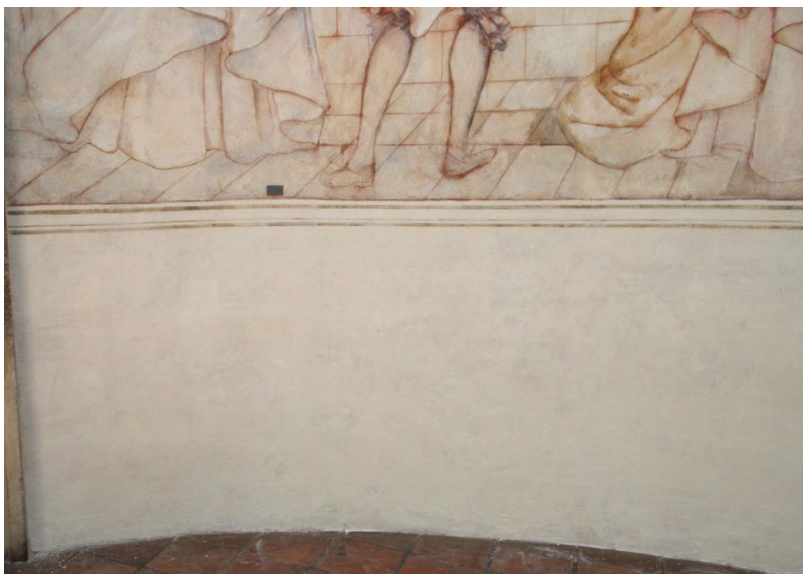
Obr. 98: Pravá časť soklu v dennom rozptýlenom svetle. Stav po reštaurovaním. Rekonštrukcia okrového náteru a linkovania.
