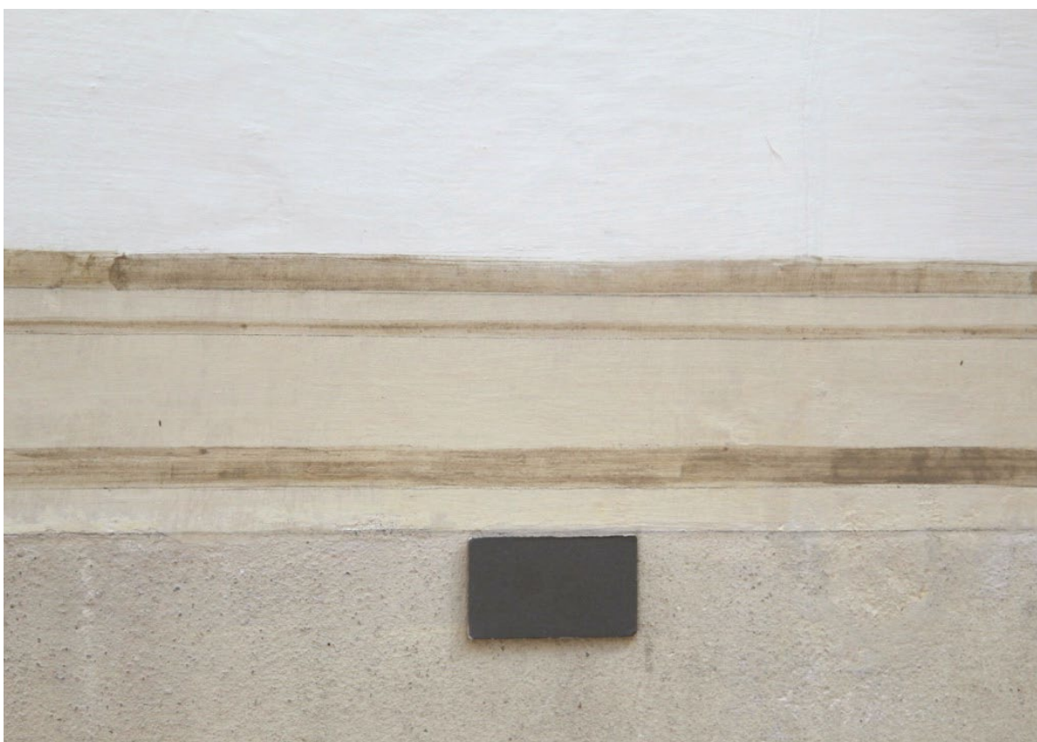
Obr. 100: Detail na rekonštrukciu okrového náteru a linkovania nad výjavom. Stav po reštaurovaní v dennom rozptýlenom svetle.
