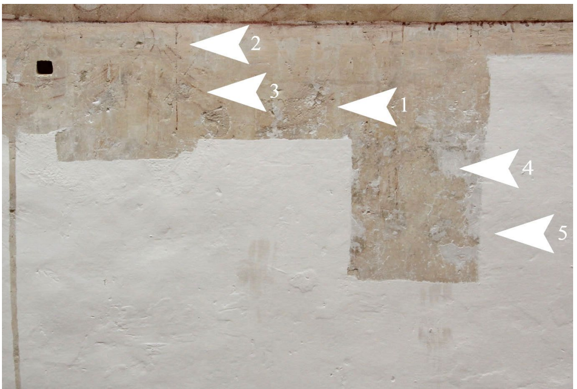
Obr. 7: Sonda 1SV 13 – výjav č. 4, pravá soklová časť: 1) Historická omietka (baroková); 2) Okrový náter; 3) Linky drapérie; 4) Druhotné vysprávky (prekletované) v sokly; 5) Hlinkový náter (z roku 1995)
