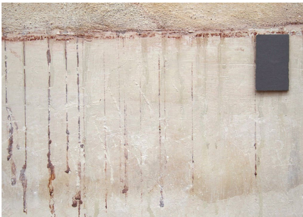
Obr. 80: Detail na časť soklu pod výjavom č. 1 v dennom rozptýlenom svetle. Stav po odstránení hliníkového náteru. Je vidieť tiež tekance pod maľbou a fragmentálna červená linka na hranici omietok.
