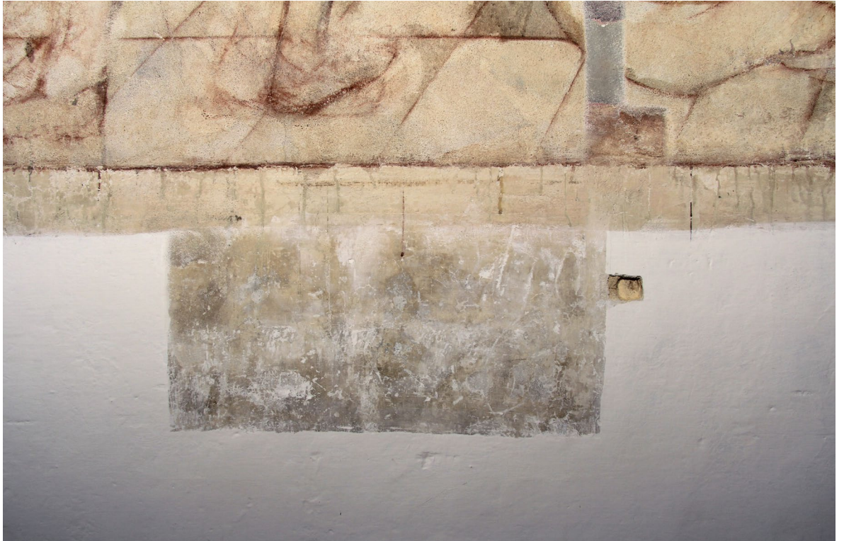
Obr. 65: Detail na soklový úsek pod výjavom č. 1. Stratigrafická sonda. Stav pred reštaurovaním v umelom osvetlení. Na snímku je vidieť, že v týchto partiách neboli v sonách nájdené žiadne podobné fragmenty kresby drapérie ako vo výjave č. 4.
