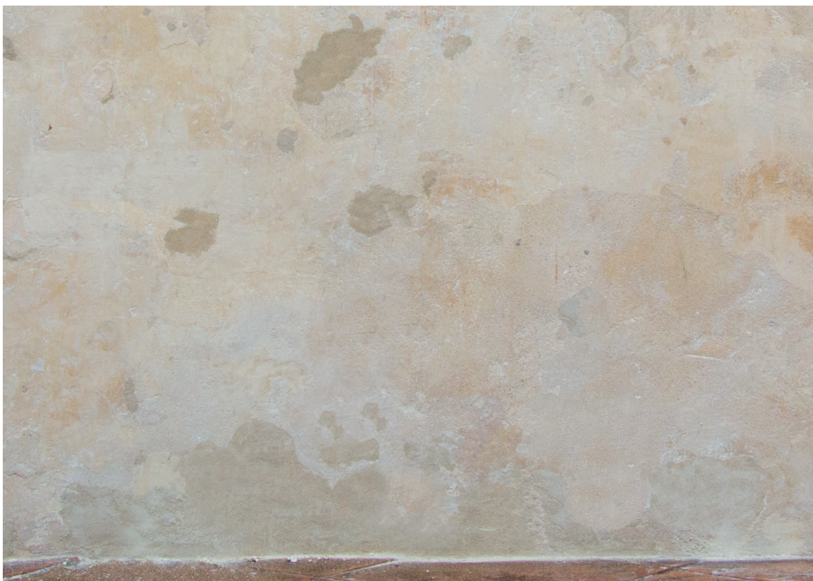
Obr. 82: Detail na spodnú časť soklu po tmelení, v dennom rozptýlenom svetle.
