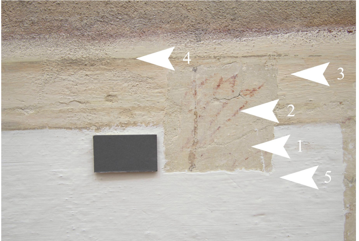
Obr. 8: Sonda 8SZ 15 – výjav č. 3, sonda v spodnej časti výjavu na rozhraní soklu a malby : 1) Historický štuk (barokový); 2) Rudková kresba; 3) Okrový náter; 4) Fragmenty linkovania; 5) Biely hlinkový náter (z roku 1995)
