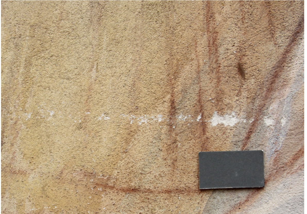
Obr. 53: Detail výjavu č. 1. Stav pred reštaurovaním v dennom rozptýlenom svetle. Detail poškodenie odrením vrchného štku v ľavej hornej časti výjavu.
