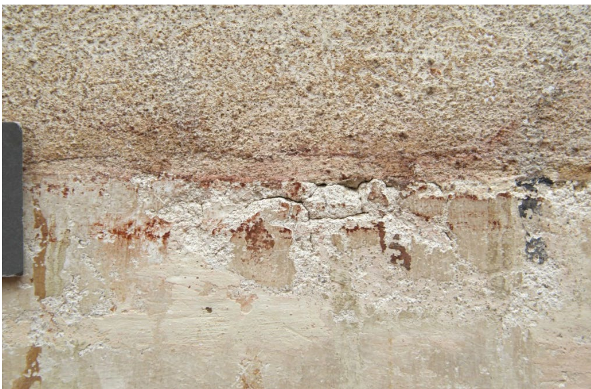
Obr. 72: Detail na hranicu soklu a výmalby výjavu č. 1. Stav pred reštaurovaním v dennom rozptýlenom svetle. Na fotografii je vidieť rozhranie a odlišný charakter omietok maľby a soklu. Tiež je možné vidieť aj malé fragmenty červenej linky na tejto hranici.
