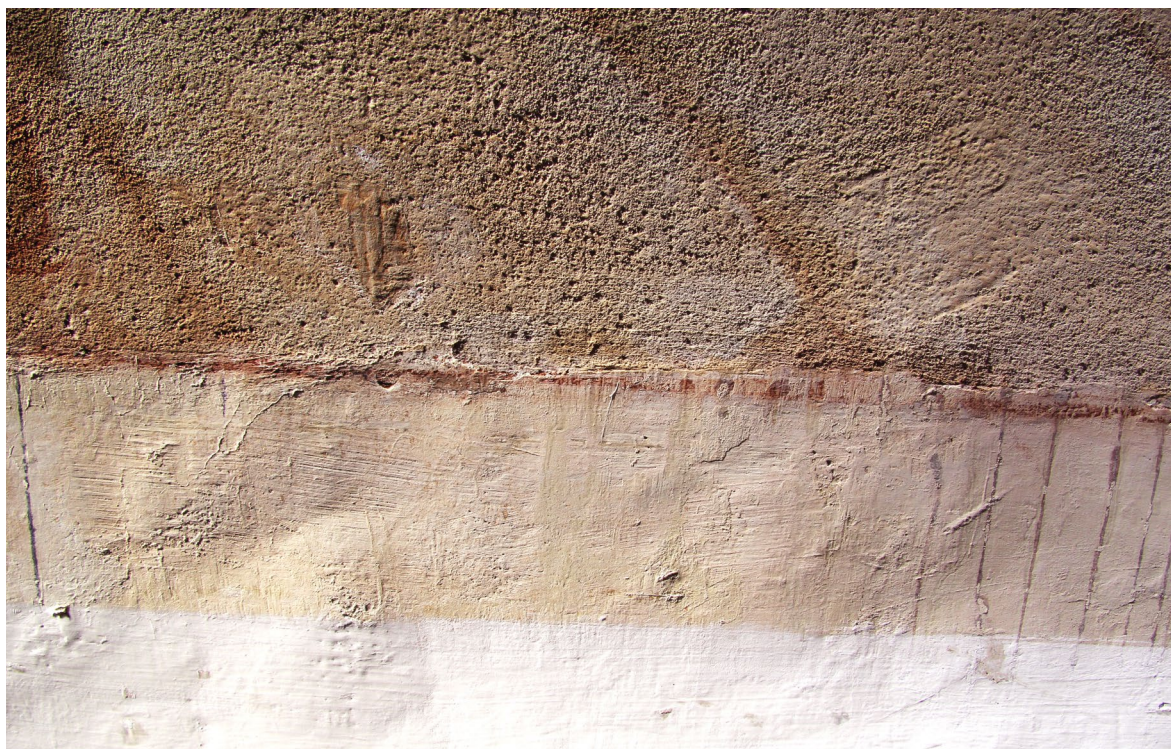
Obr. 60: Stav pred reštaurovaním v razantnom bočnom osvetlení. Detail na autorké tmely. V svetle sa zvýraznila hrubá štruktúra omietky v kontraste s hladkou omietkou soklu.
