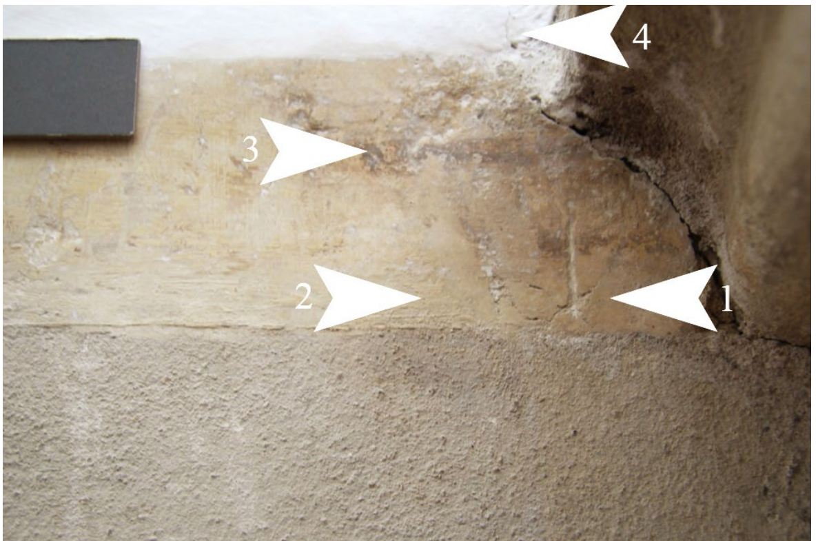
Obr. 9: Sonda 5JV 15 – výjav č. 1: 1) Historický štuk (barokový); 2) Okrový náter; 3) Fragmenty linkovania; 4) Biely hlinkový náter (z roku 1995)
