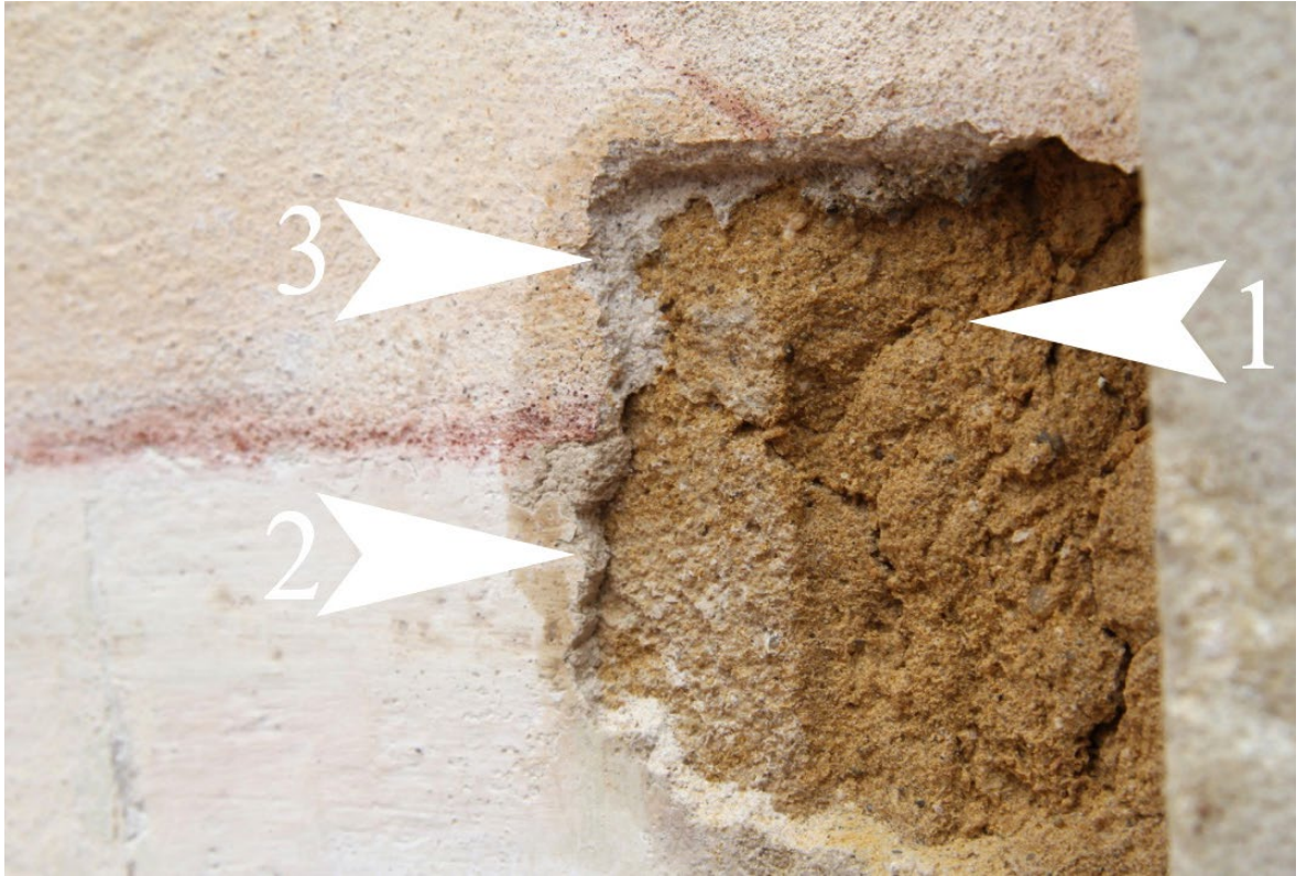
Obr. 2: Sonda 9JV 84 – výjav č. 1: 1) Historické jadro (barokové); 2) Historický štuk (barokový); 3) Štuk z roku 1937
