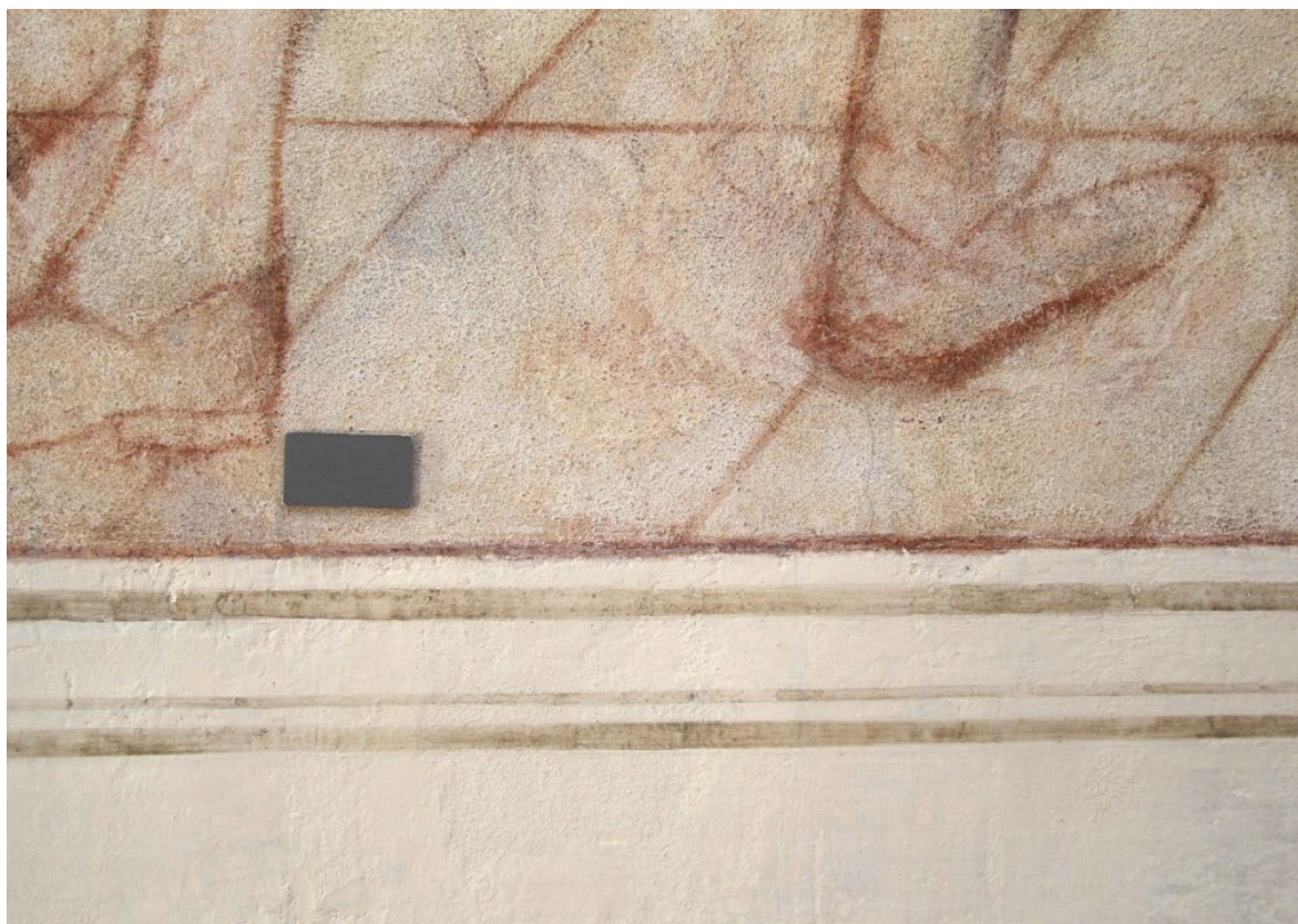
Obr. 99: Detail na rekonštrukciu okrového náteru a linkovania v hornej časti soklu. Stav po reštaurovaní v dennom rozptýlenom svetle.
