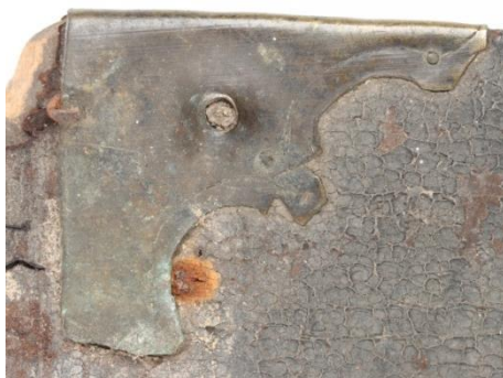
Obr. 1 Dobová oprava – nárožnica
