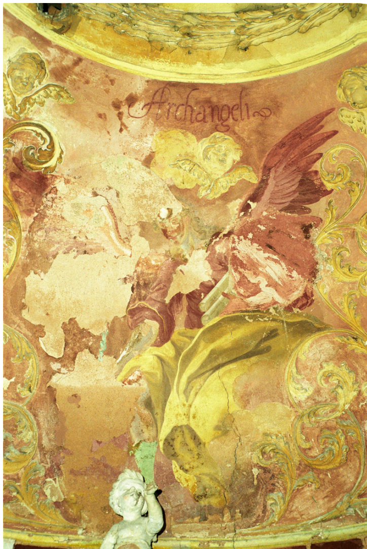
Obr. 47 Stav výjevu „Archangeli“ v roce 2003, kdy již chybělo intonaco i v levé spodní části a starší defekty byly zvětšeny. Autor: J. Švadlenka
