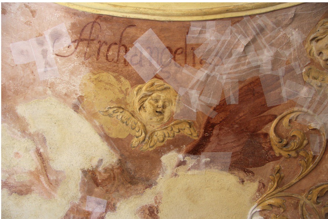
Obr. 65 Horní část výjevu, na němž byly velké puchýře intonaca zajištěny přelepy z japonského papíru pojenými Tylosou. Stav v průběhu restaurování.
