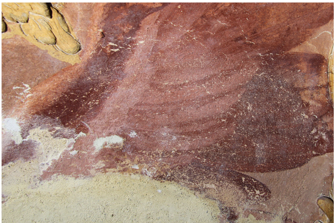
Obr. 52 (dole) Detail poškození barevné vrstvy, která byla v letech 2005–2006 zpevněna povrchově prostředkem, který následně způsoboval její pnutí a tvorbu šupin.
