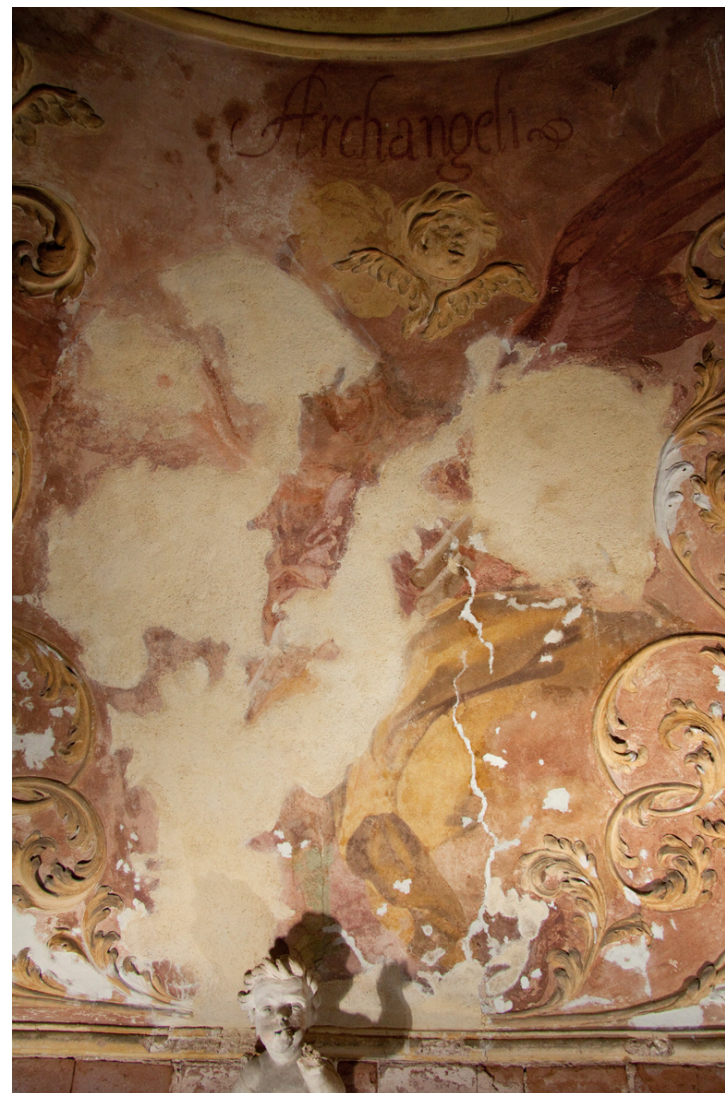
Obr. 48 Stav malby v roce 1996, kdy byly zaznamenány ztráty intonaca levé horní části postavy Archanděla. Autor: Neumeistrová
