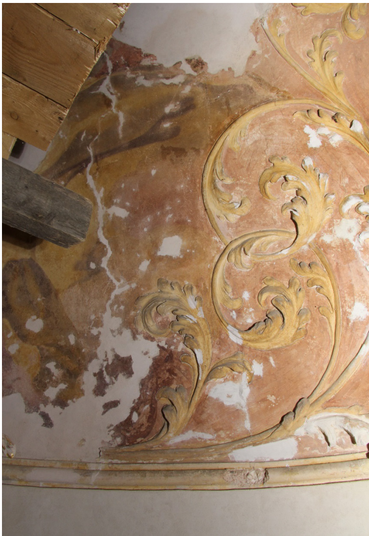
Obr. 74 Část postavy Archanděla s nově vytmelenými defekty v levém dolním rohu výjevu. K tmelení defektů vrstvy intonaca byla použita jemná zatónovaná vápenná malta v poměru 1:2. Stav po vytmelení
