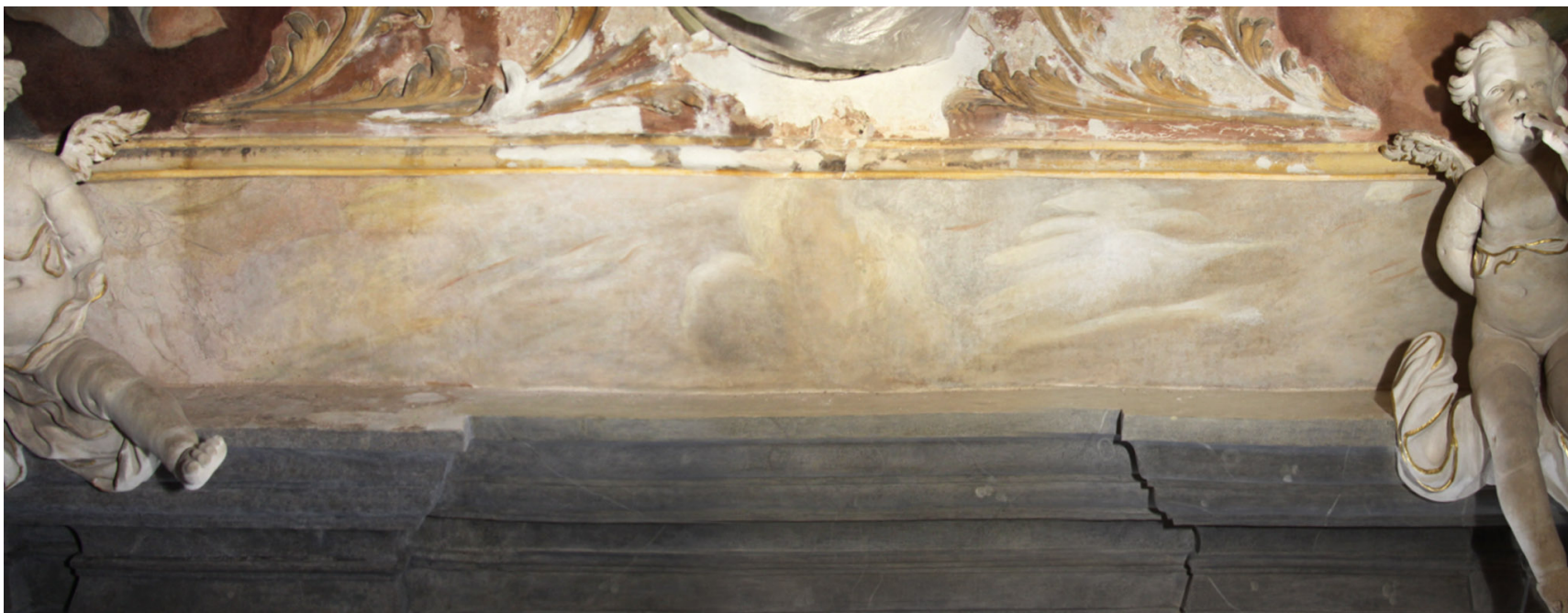
Obr. 79 Rekonstrukce pásu s oblaky na západní straně kaple. Tvar mraků se řídil podle fotografické předlohy (Obr. 78), technika a barevnost vycházely z dochovaných fragmentů barevné vrstvy a okolních maleb v kapli. Malba minerálními pigmenty pojenými arabskou gumou.
