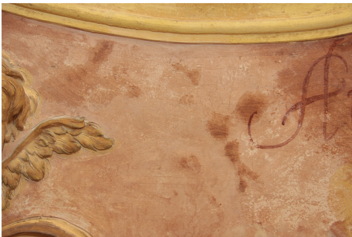
Obr. 56 Tmavé skvrny jsou pozůstatkem zatékání a tyto plochy se střídají s plochami, kde naopak došlo k zesvětlení barevnosti malby
