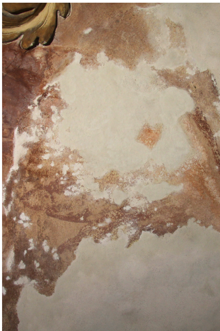
Obr. 73 Část postavy Archanděla s nově vytmelenými defekty v oblasti jeho pravého křídla. K tmelení defektů vrstvy intonaca byla použita jemná zatónovaná vápenná malta v poměru 1:2.
