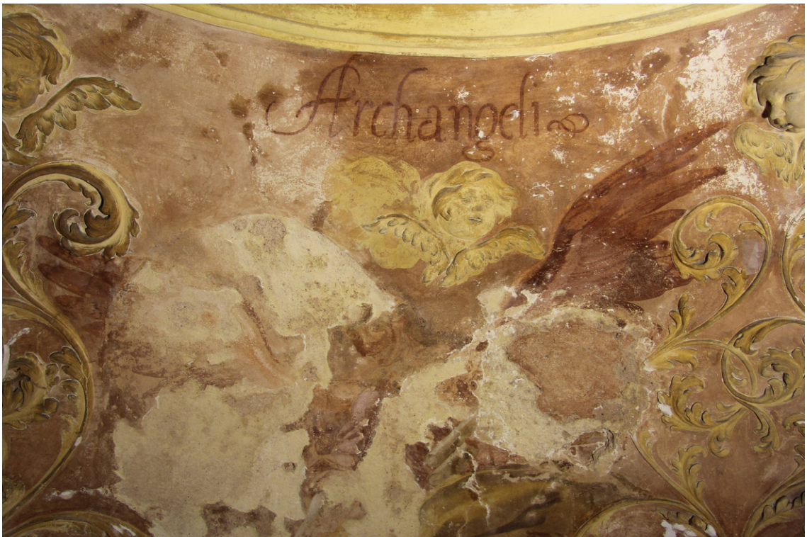
Obr. 68 (dole) Horní část výjevu, stav po odstranění mladších tmelů a v průběhu strukturální a hloubkové konsolidace vápenných omítek.
