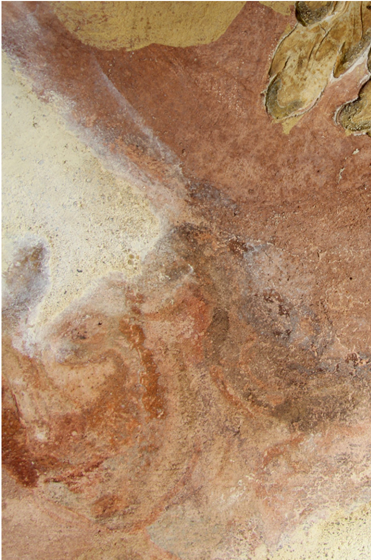
Obr. 53 Detail části většího tmelu z let 2005-2006, který zasahoval do obličejové partie Archanděla. Při okrajích byl tmel roztírán a vznikl tak rezistentní bílý zákal. Barevná vrstva byla celoplošně degradovaná působením vodorozpustných solí.
