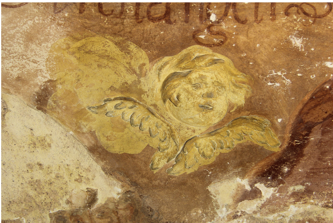
Obr. 70 Hlava andílka po zpevnění a odstranění nežádoucích tmelů v okolí. Barevná vrstva byla předzpevněna kombinacemi vápenné suspenze CaLoSiL E-25 a organokřemičitanu KSE 300 HV .
