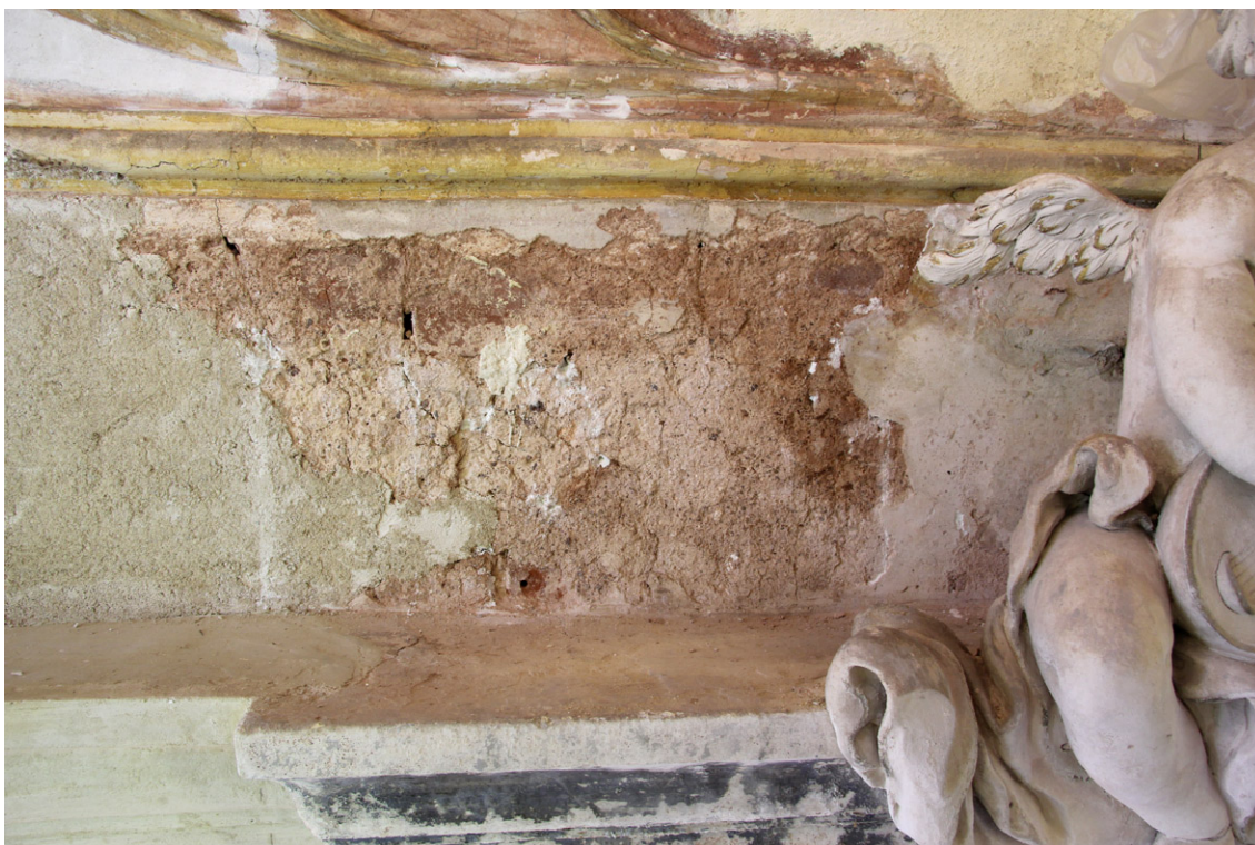
Obr. 60 Fragment intonaca a odhaleného barokního arriccia s typickou narůžovělou barevností v severní části pásu s oblaky.
