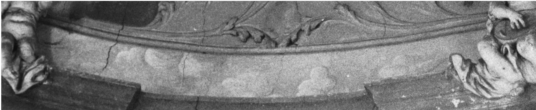
Obr. 80 Výřez fotografie z roku 1977 (autor M. Kolegar), která původně zabírala větší část plochy klenby. V této době byly ještě omítkové vrstvy v oblasti pásu s oblaky zachovány, a proto se část mraků rekonstruovala podle této předlohy.
