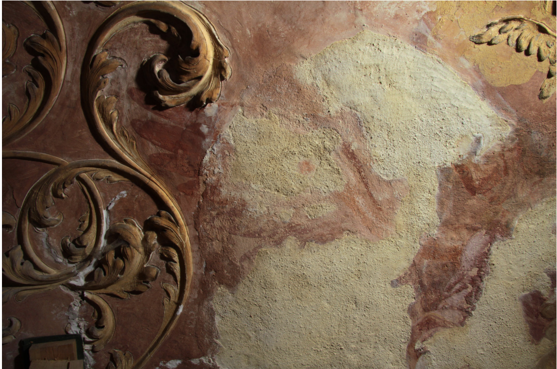
Obr. 63 Horní část výjevu, na němž byly velké defekty vytmeleny hrubým tmelem při zajišťovacím zásahu v letech 2005-2006
