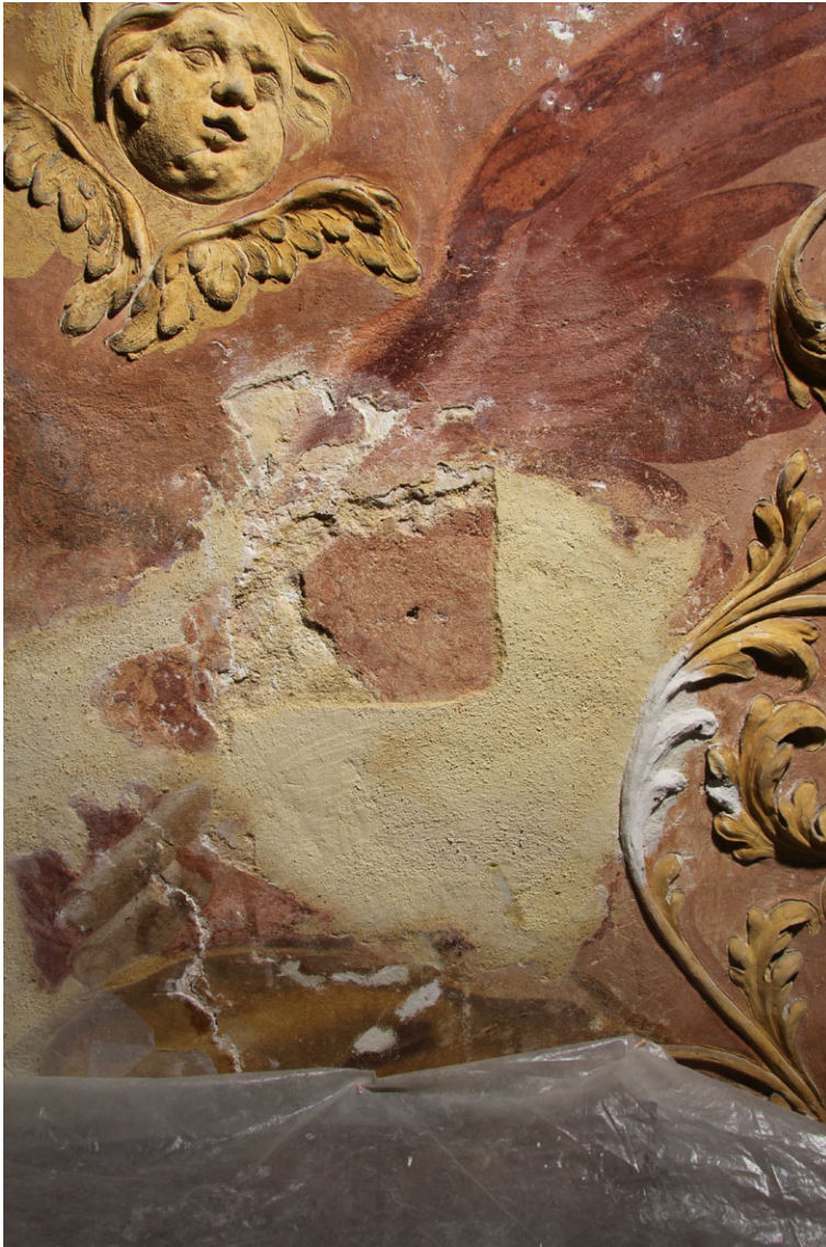
Obr. 67 Tmel v oblasti levé paže anděla. Stav v průběhu zpevňování a odstraňování tmelů z předchozího restaurátorského zásahu. Pod tmelem byl objeven fragment staršího tmelu z 18. nebo 19. století.
