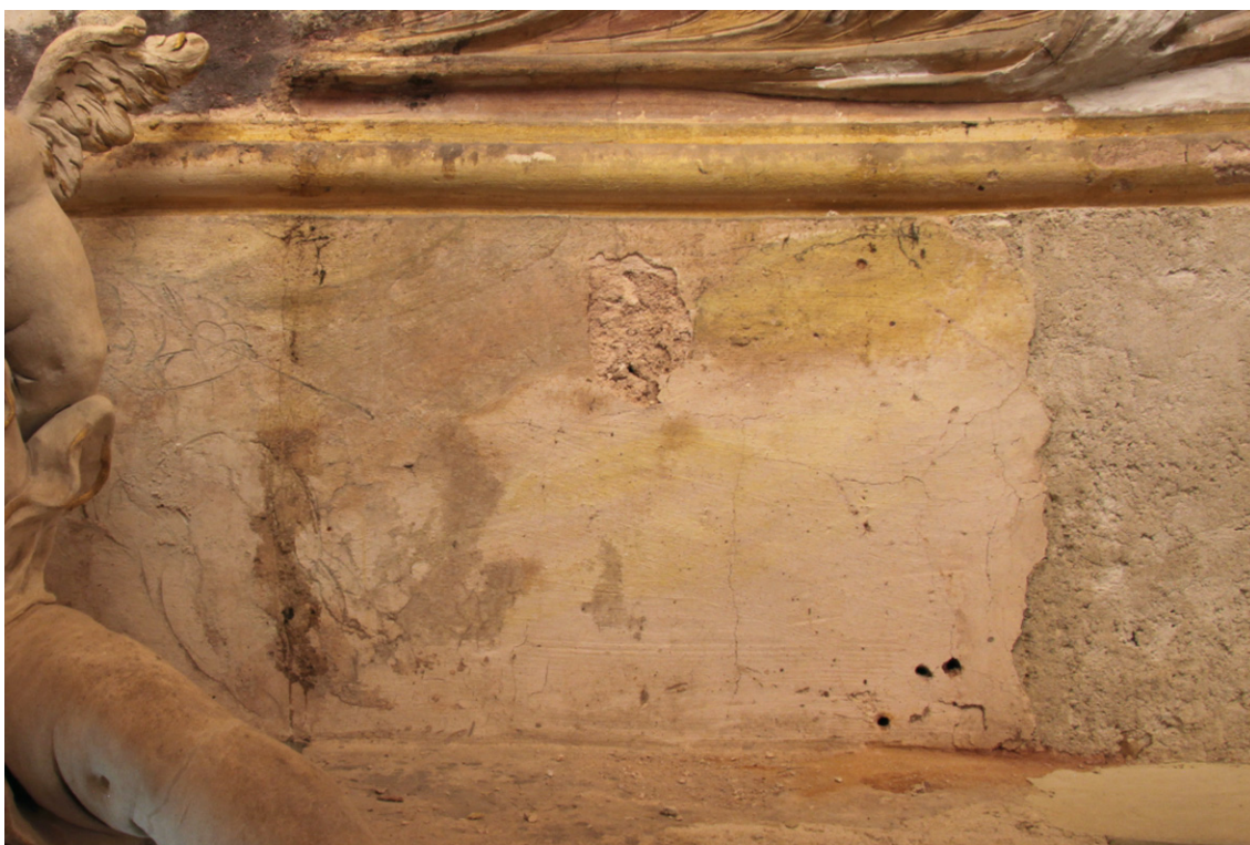
Obr. 59 Fragment intonaca v západní oblasti pásu s oblaky (nad korunní římsou) Zde došlo k plošným ztrátám omítek až na odhalené zdivo. Na snímku nahoře je vidět silný a lesklý stékanec rezistentního konsolidačního prostředku z let 2005-2006 s ulpěnými nečistotami. Napravo již začíná nová jádrová omítka .
