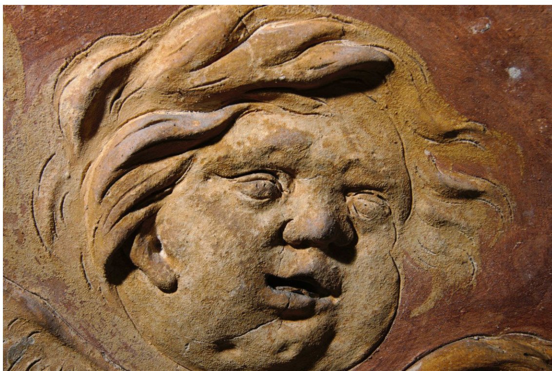
Obr. 58 Štuková hlava andílka je pokryta zašedlou tmavou krustou vodorozpustných solí.
