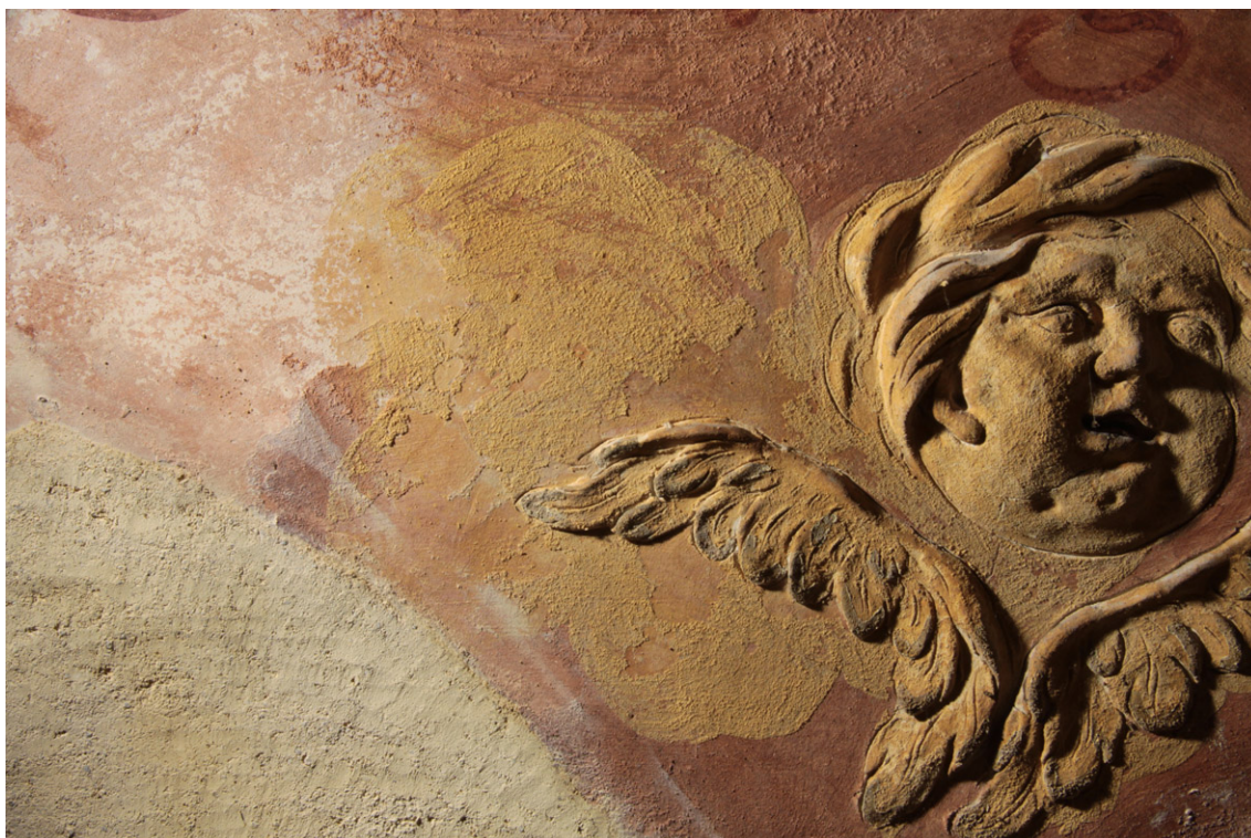
Obr. 55 Štuková hlava andílka v bočním nasvícení. Žlutá barevná vrstva byla zpráškovatělá a nabobtnaná pravděpodobně v důsledku krystalizace solí. V růžovém pozadí jsou dobře patrná tmavlá pole (větší část snímku vpravo). V místě, kde je barevná vrstva naopak zesvětlená je barevná vrstva sprášená. V pravé horní části se barevná vrstva zvedala od podkladu v křehkých a poměrně pevných puchýřcích.
