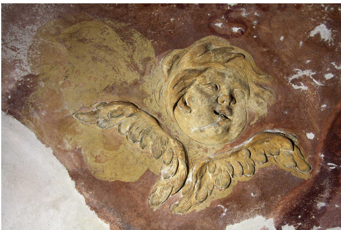
Obr. 71 Hlava andílka po dočištění rezistentní šedavé krusty na štuku a odstranění hlubších reziduí vápenné krusty při okrajích tmelů pomocí regulovatelného mikrotrýskání jemného abraziva mikropískovačkou. Stav po vytmelení defektů.
