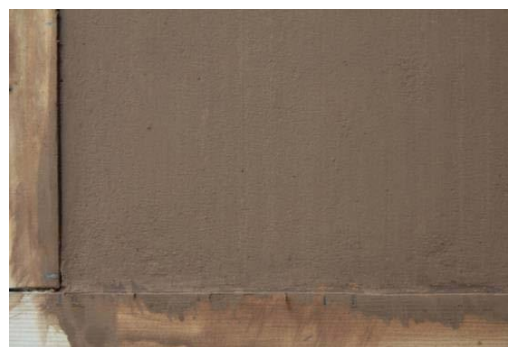
zkušebních panelů, nanesení barevné vrstvy
