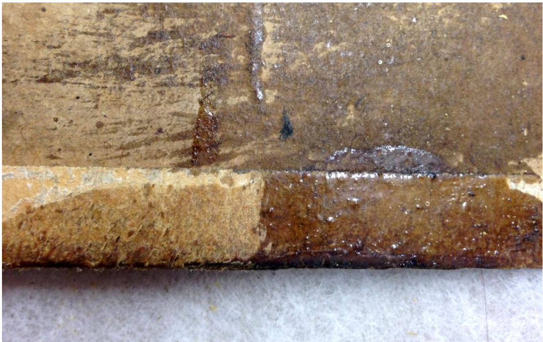
Obr. 122: Zkoušky odstraňování lakových vrstev – ultrazvuková jehla
