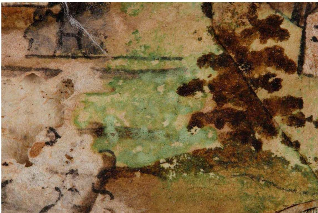
Obr. č. 322 Detail poškození hmyzem, špatná adheze barevné vrstvy.
