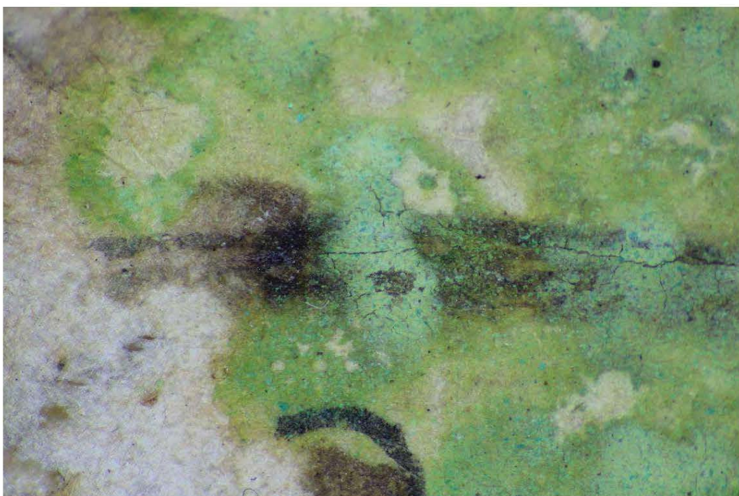
Obr. č. 323 Detail poškození hmyzem, špatná adheze barevné vrstvy.
