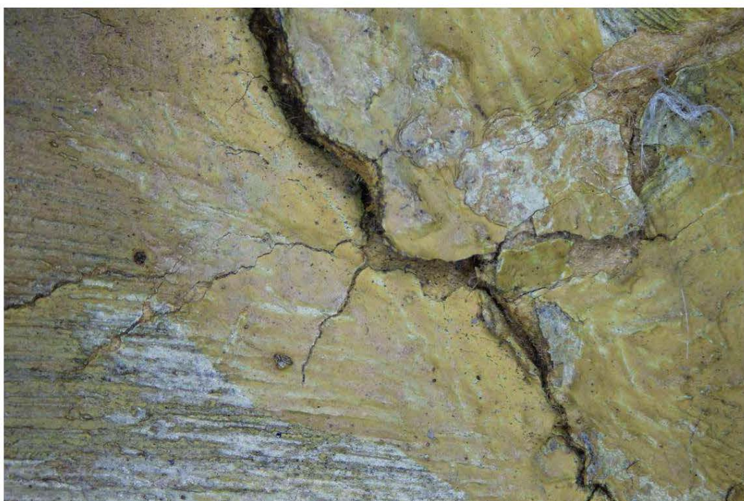
Obr. č. 581 Zde malba tvoří vlasové trhliny v místech, kde došlo k popraskání malby vlivem poškození podložky.
