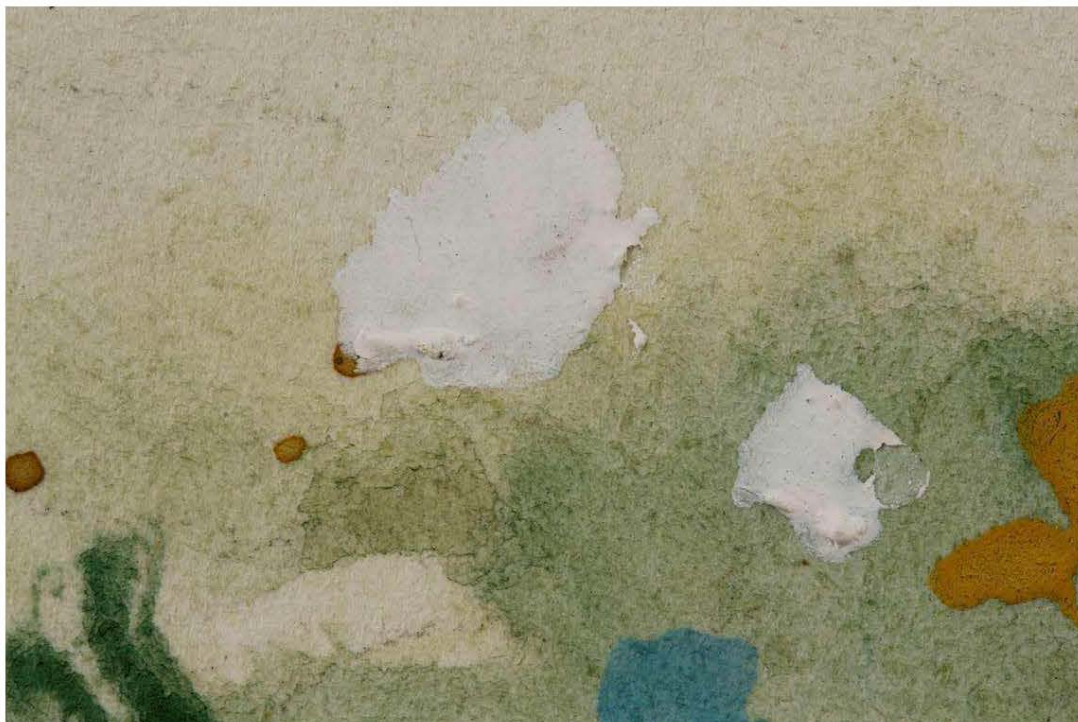
Obr. č. 299 Detail poškození, lokálně špatná adheze barevné vrstvy.
