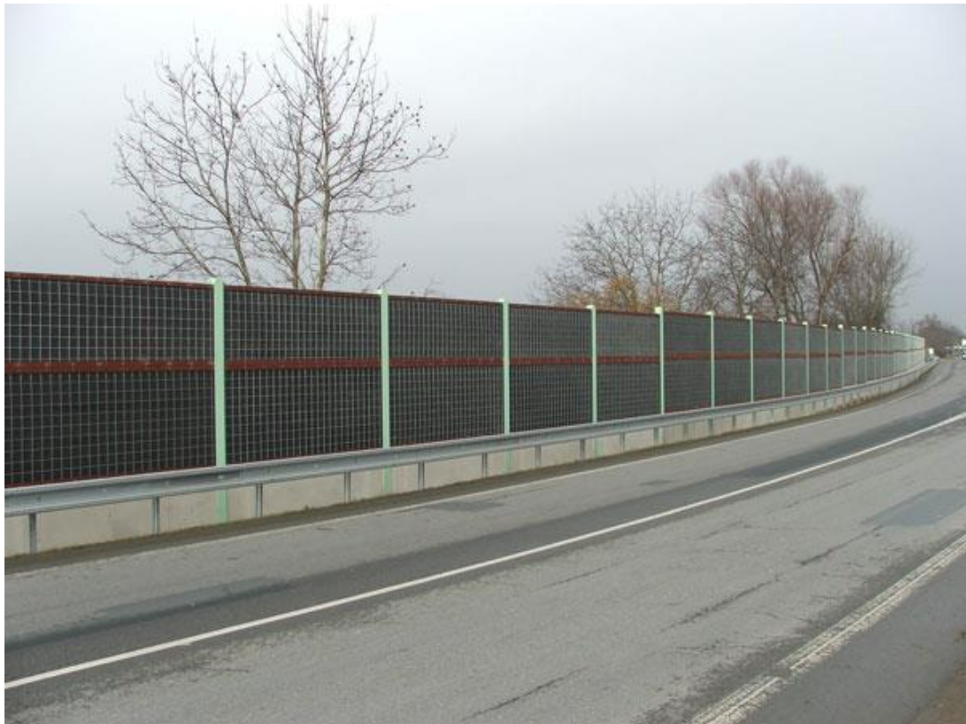
Obr. 11 - Protihluková stěna z panelů ze sklovláknového betonu [30]
