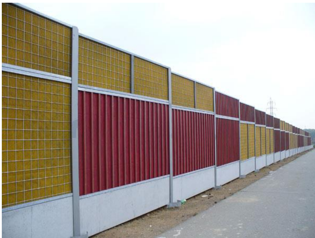
Obr. 12 - Protihluková stěna z panelů z recyklovaných plastů [30]
