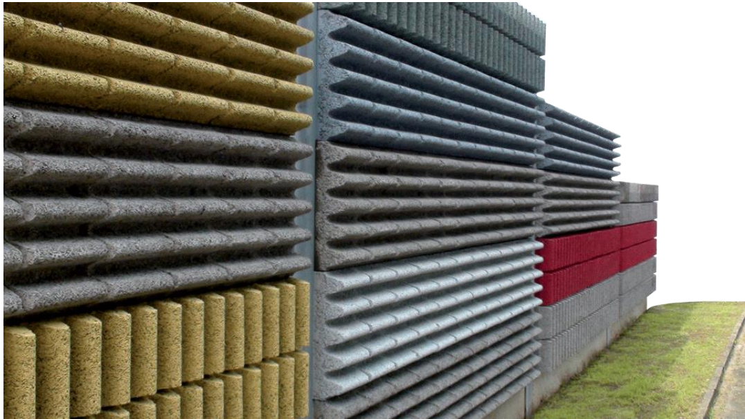
Obr. 10 - Protihluková stěna z dřevocementových tvarovek [30]
