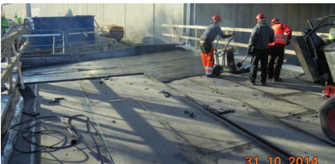
Obrázek 22 - Provedení hydroizolace mostovky
