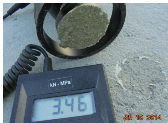
Obrázek 21 - Výsledek odtrhové zkoušky na povrchu betonu
