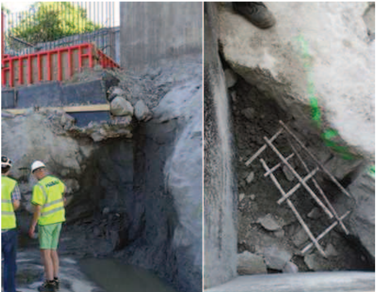
Obrázek 4 - Vyztužení přestřelené skály a následné posuzování stability horniny
