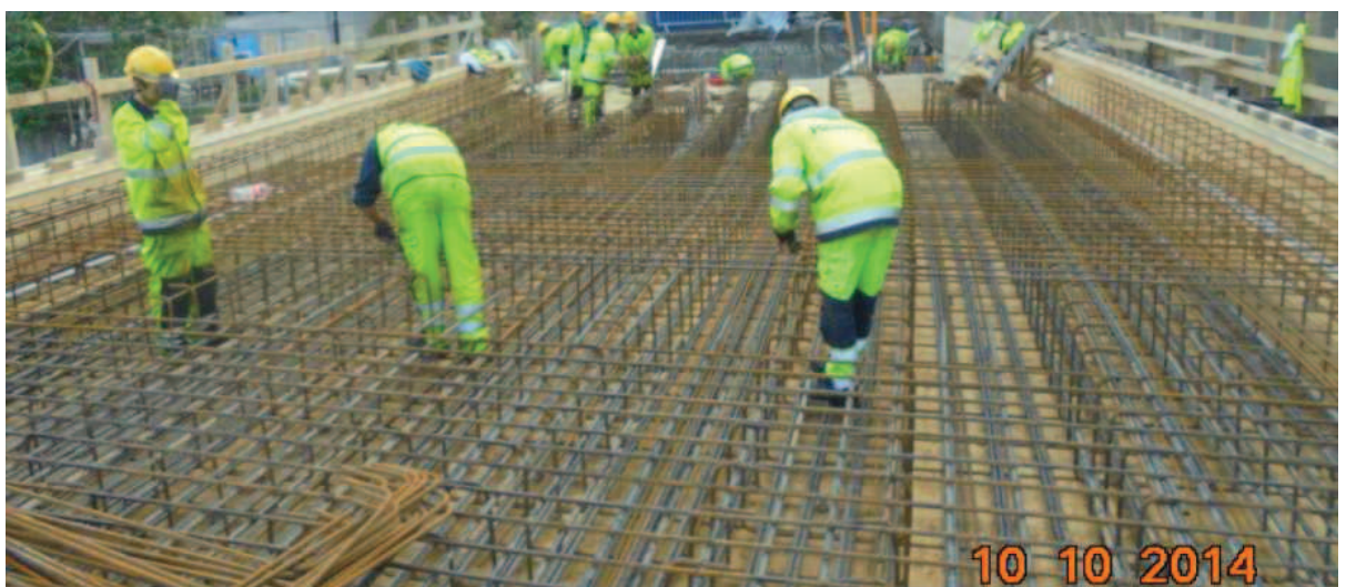
Obrázek 14 - Montáž výztuže
