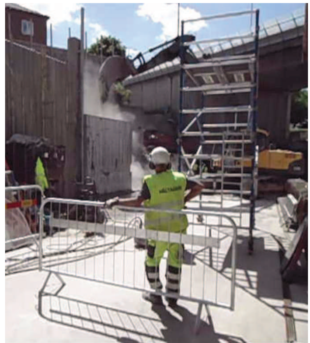
Obrázek 10 - Poloha umístění chladicího vedení - demolice stěny kotoučovou pilou (Projektová dokumentace stavby, M. Pekár, 2014)
