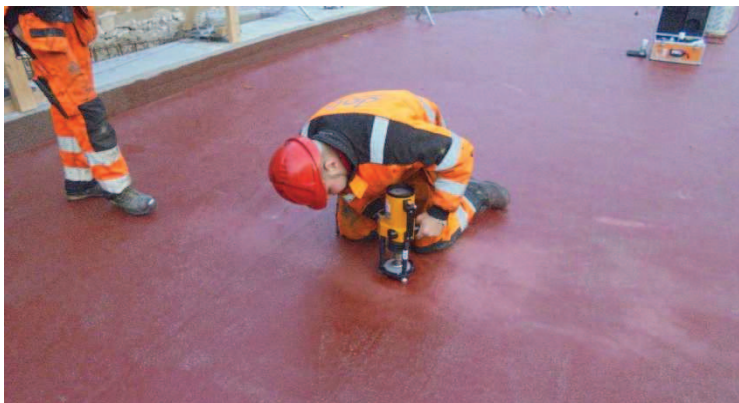
Obrázek 20 - Odtrhová zkouška povrchu pečetící vrstvy
