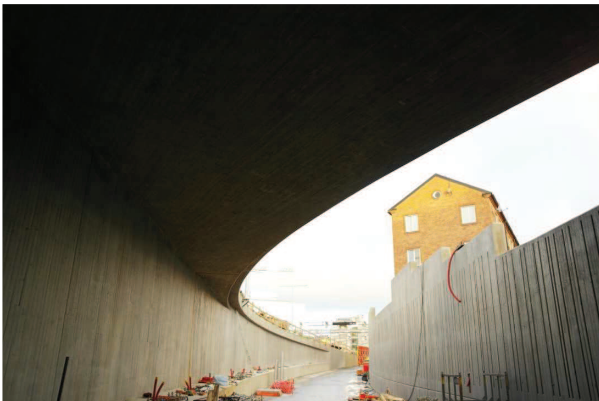
Obrázek 26 - Pohled ze spod dokončeného mostu
