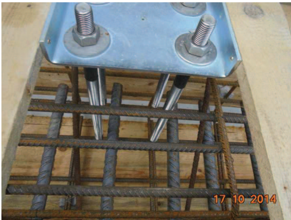
Obrázek 16 - Závité tyče pro sloupky zábradlí
