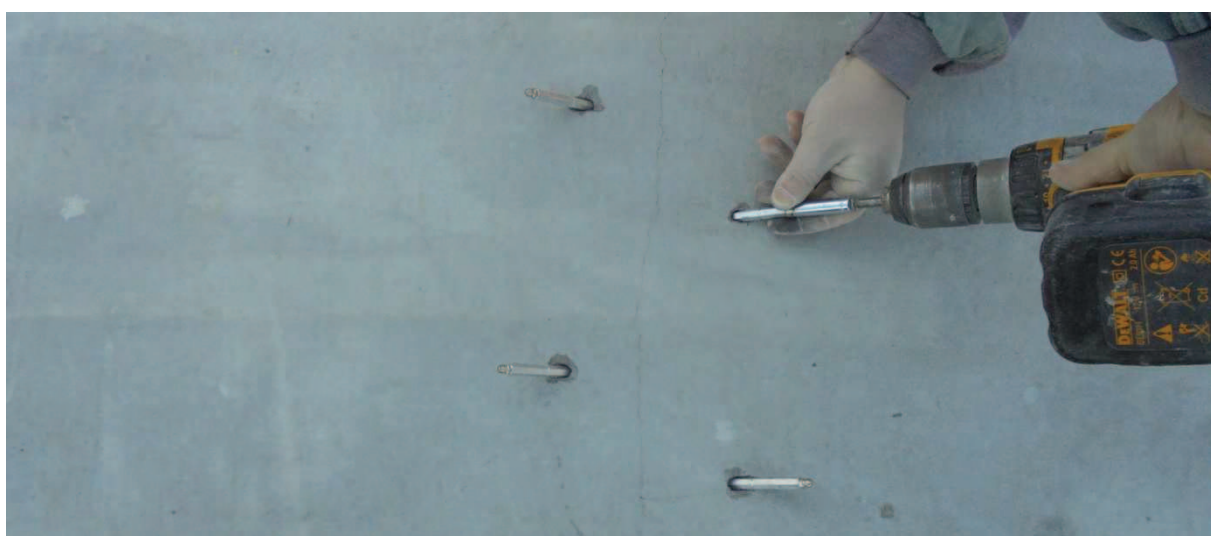
Obrázek 8 - Vysokotlaká injektáž trhlin
