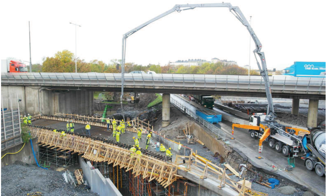
Obrázek 18 - Betonáž mostovky
