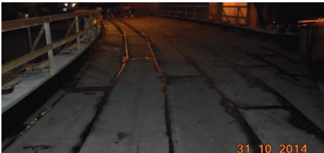
Obrázek 22 - Provedení hydroizolace mostovky
