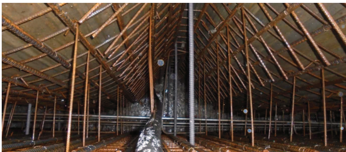
Obrázek 7 - Rozmístění chladících trubek v opěře 1
