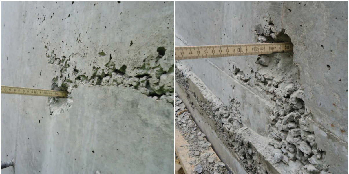
Obrázek 9 - Kaverny ve stěně monolit M6 2-2043-17
