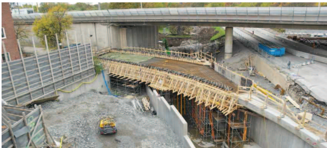
Obrázek 15 - Dokončená montáž výztuže desky mostu
