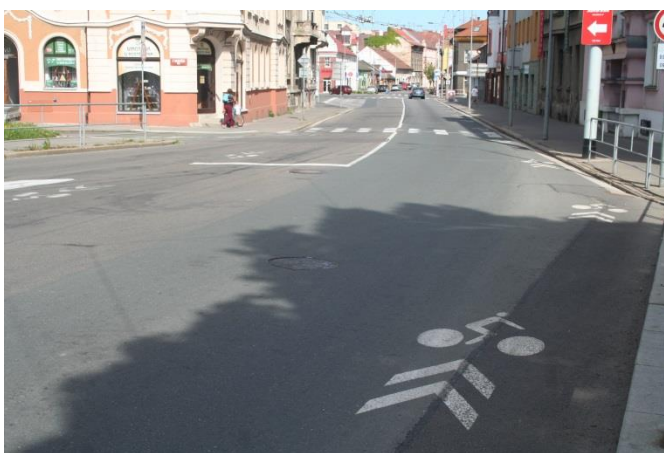
Obrázek 14: Vodorovná dopravní značka V20
