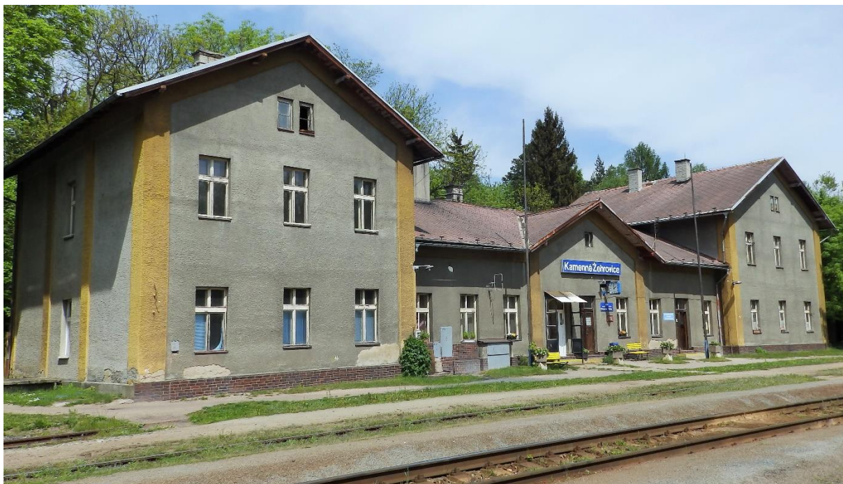
Obr. 1 Železniční stanice Kamenné Žehrovice
