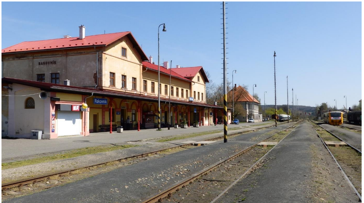
Obr. 1 Železniční stanice Rakovník
