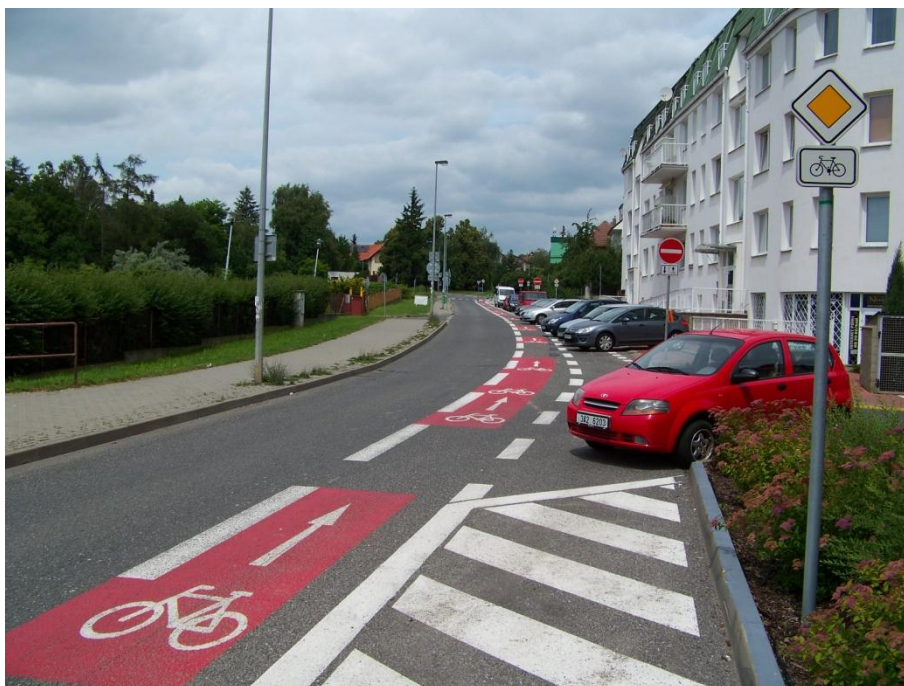
Obr. 32 Cykloobousměrka v ulici Za Černým Mostem
