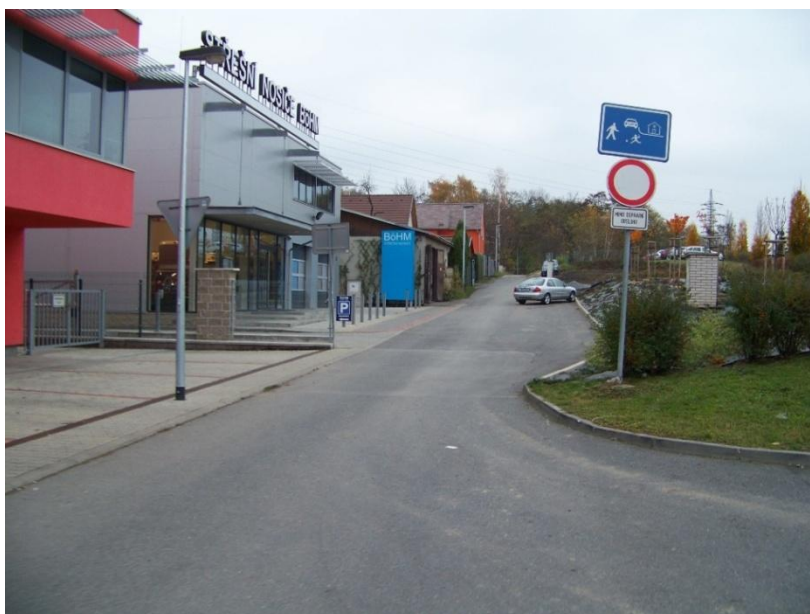
Obr. 38 Výměna dopravní značky K Hutím 10
