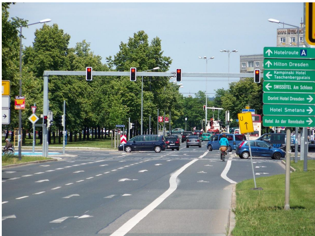
Obr. 12 Cyklopruh podél obrubníku, Drážďany, St. Petersburger Straße
