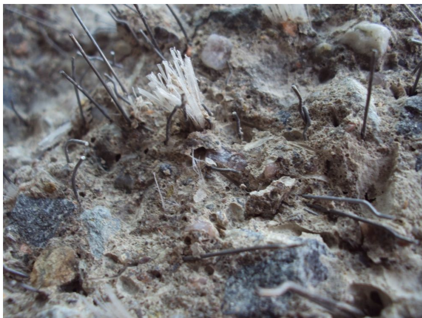
Obr. 4: Selhání drátků typu 3D vytažením při zatěžování v tahu ohybem (hranol Z4II 3)
