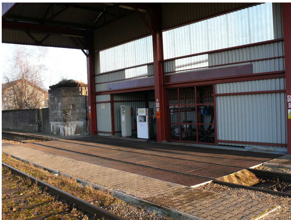
7 čerpací stanice PHM na koleji 101; zdroj: autor
