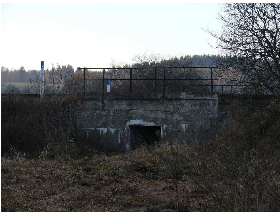
13 Propustek v km 56,339; zdroj: autor
