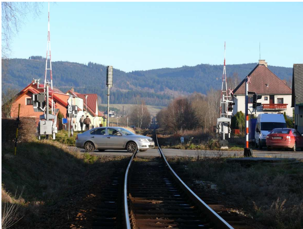
4 Přejezd na zbytinském záhlaví; zdroj: autor
