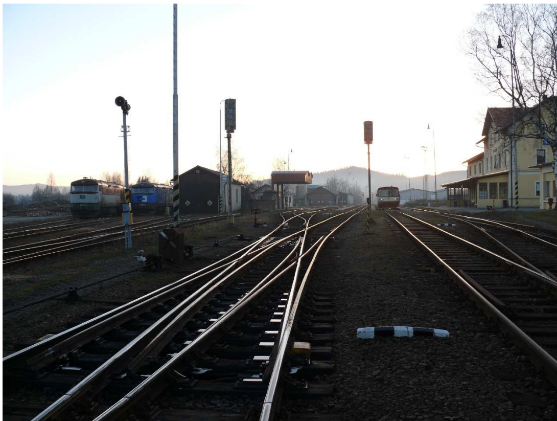
20 Pohled na stanici ze zbytinského zhlaví; zdroj: autor
