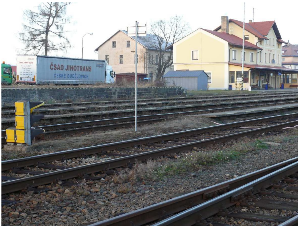
16 Pohled na nákladní rampu a výpravní budovu od DKV; zdroj: autor
