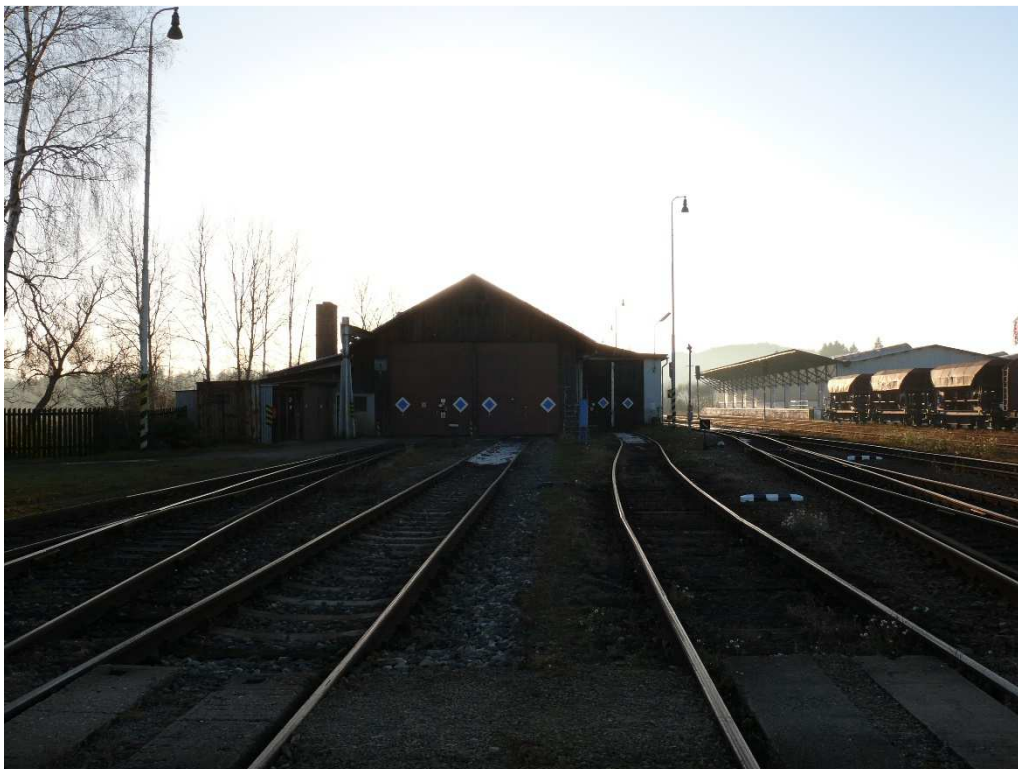
8 Pohled na kolejiště a budovu DKV; zdroj: autor
