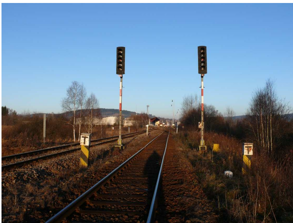
11 Pohled na vjezdová návěstidla VS a V; zdroj: autor
