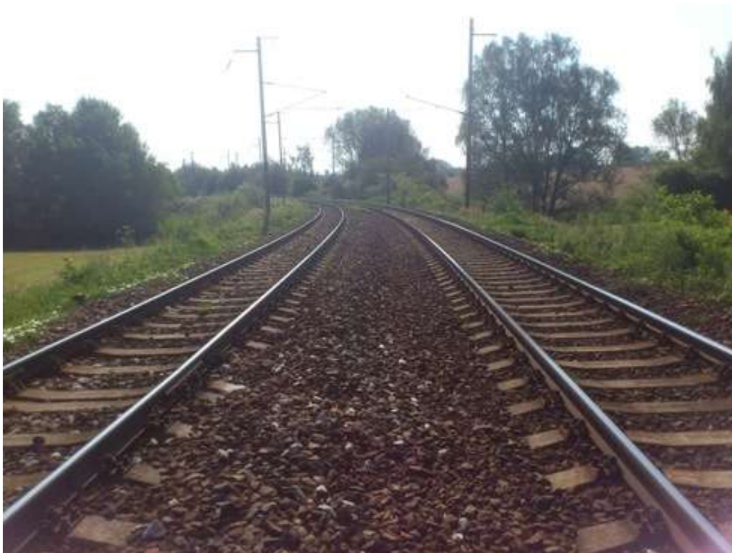
Úsek Vlkaneč – Golčův Jeníkov – směrové oblouky R1 = 285 m, R2 = 292 m
