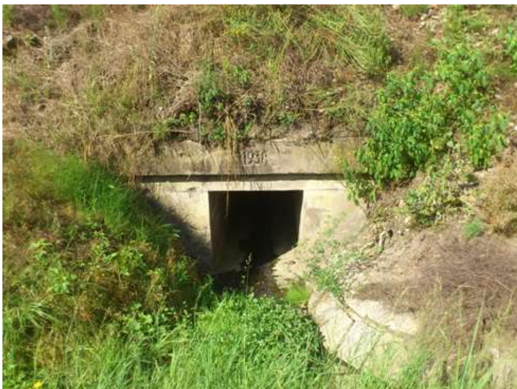
Úsek Nová Ves u Leštiny – Vlkanec – propustek 254,752
