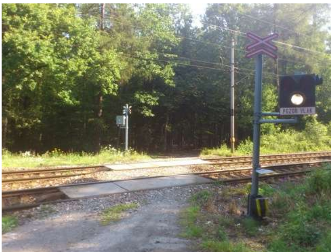
Úsek Vlkaneč – Golčův Jeníkov – železniční přejezd km 262,715
