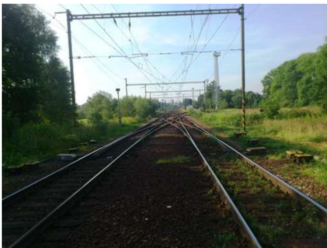
Železniční stanice Leština u Světlé – vlkanečské zhlaví
