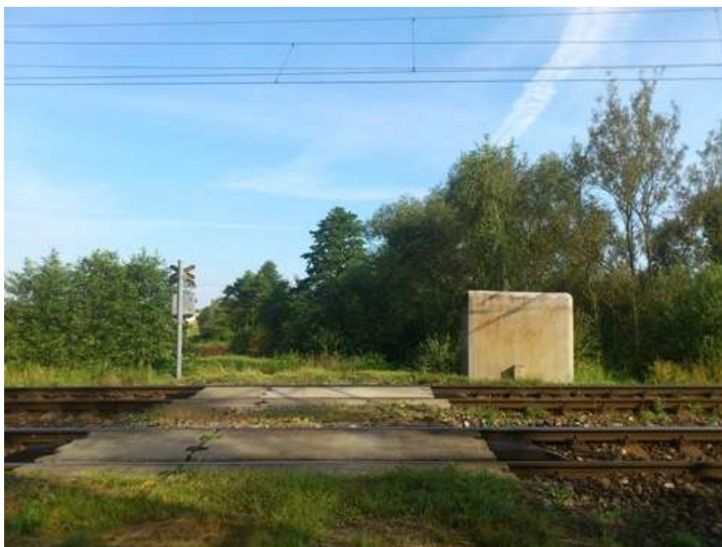
Úsek Sázavka – Leština u Světlé – železniční přejezd v km 250,837
