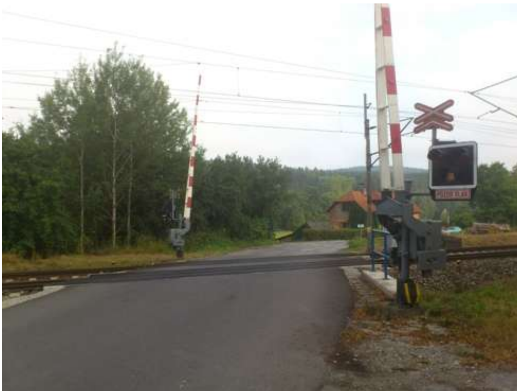
Úsek Světlá nad Sázavou – Josefodol – železniční přejezd v km 241,537
