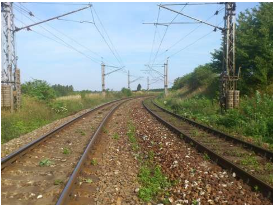
Úsek Nová Ves u Leštiny – Vlkaněč – složené směrové oblouky s mezilehlými přechodnicemi
