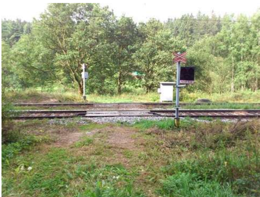
Úsek Josefodol – Sázavka – železniční přejezd v km 244,332
