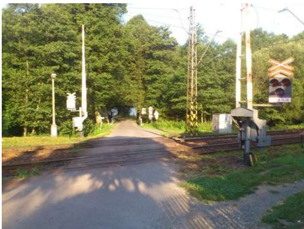
Úsek Sázavka – Leština u Světlé – železniční přejezd v km 247,933
