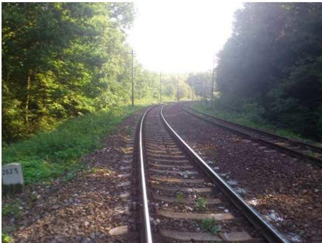
Úsek Vlkaneč – Golčův Jeníkov – směrové oblouky R1 = 300 m, R2 = 295 m
