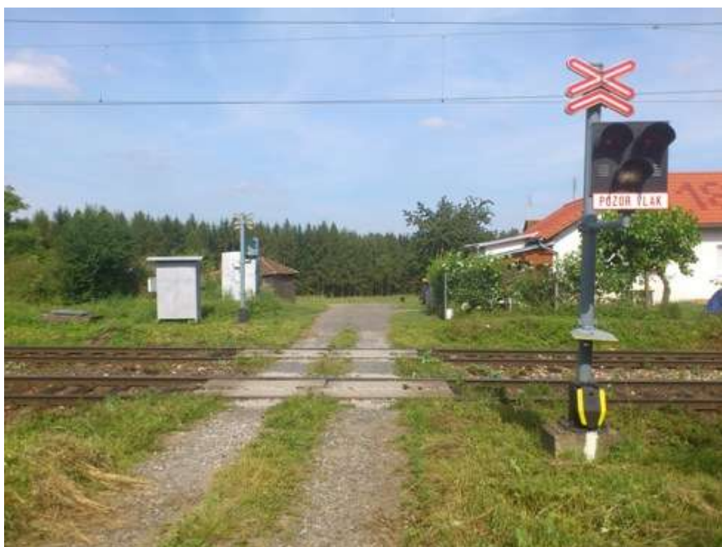
Úsek Nová Ves u Leštiny – Vlkaněč – železniční přejezd km 255,743
