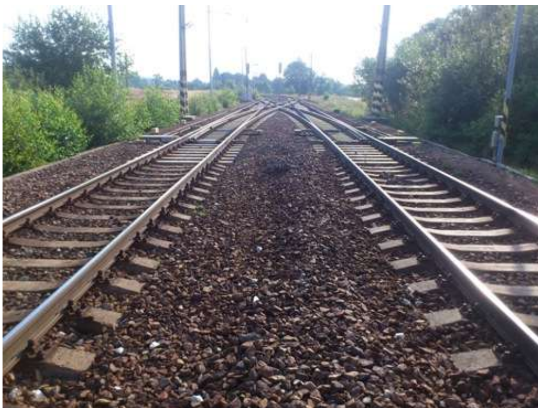
Železniční stanice Leština u Světlé – dvojitá kolejová spojka
