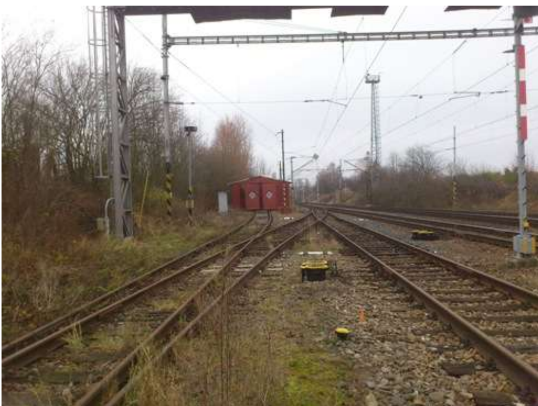
Železniční stanice Vlkaneč – manipulační koleje s garáží pro speciální motorový vůz
