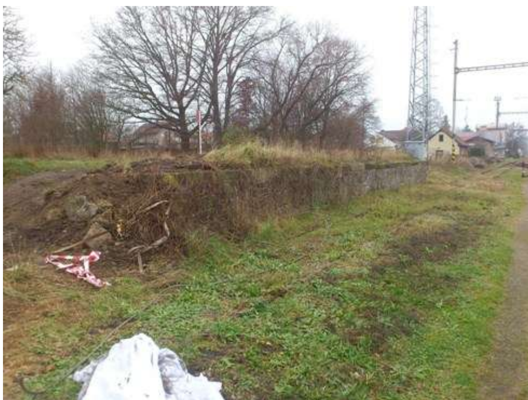
Železniční stanice Leština u Světlé – rampa u kusé koleje č. 5a
