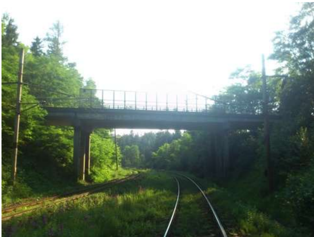
Úsek Vlkaneč – Golčův Jeníkov – mimoúrovňové křížení se silnicí III/33834 km 259,750
