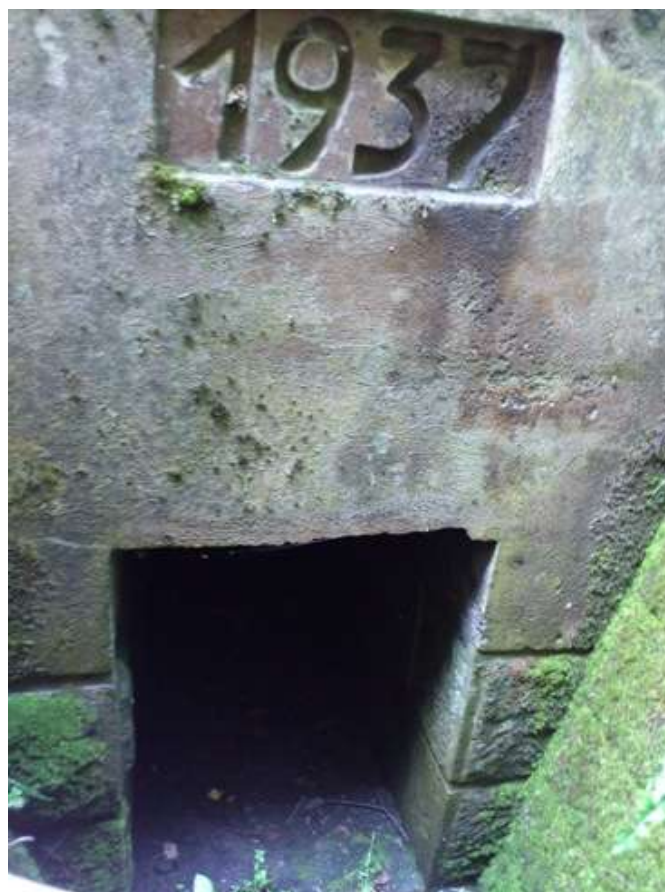
Úsek Josefodol – Sázavka – propustek v km 246,518
