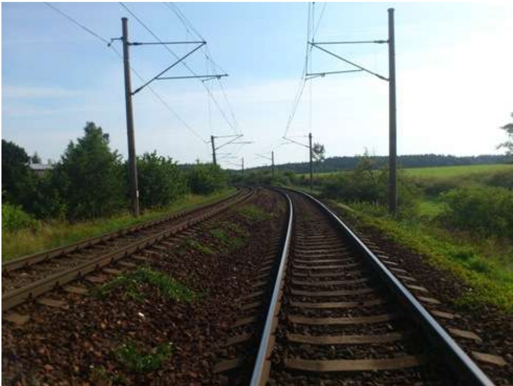
Úsek Leština u Světlé – Nová Ves u Leštiny – směrové oblouky R1 = 272 m, R2 = 276 m
