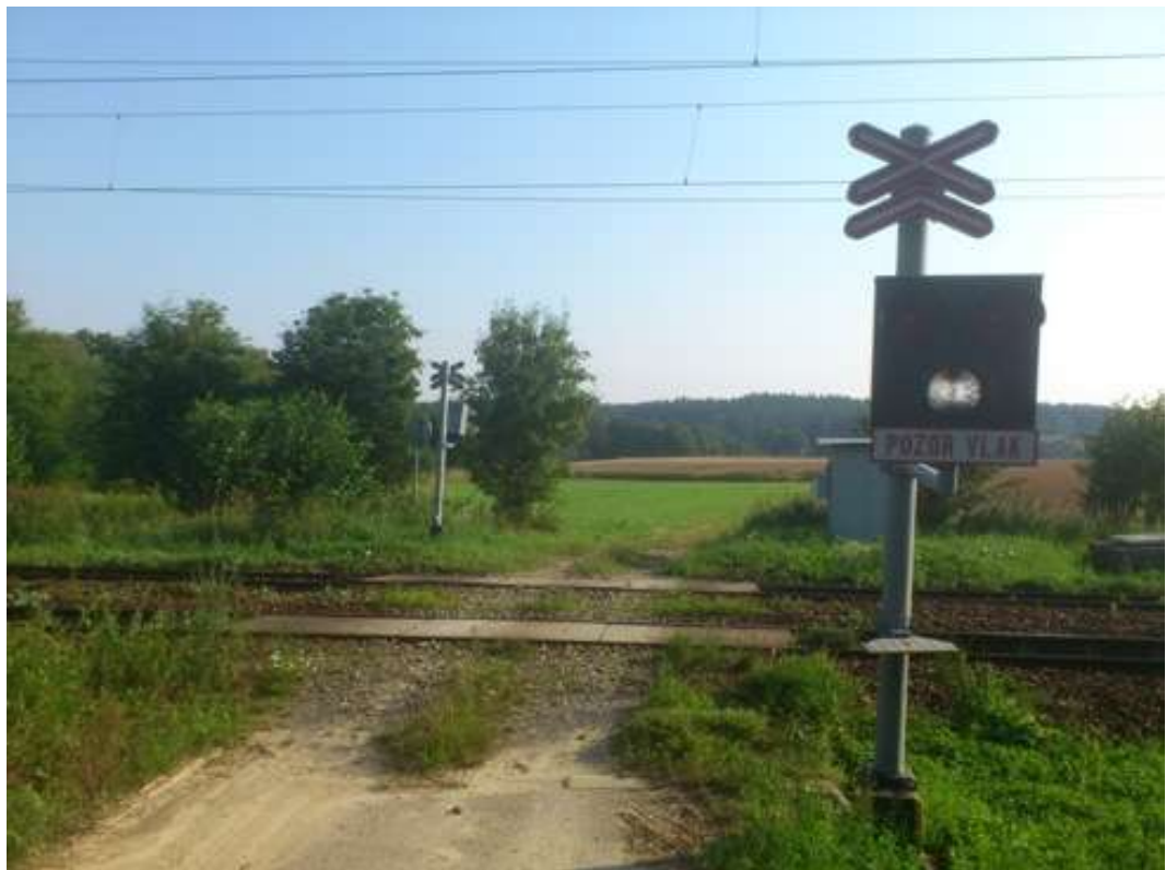
Úsek Vlkaneč – Golčův Jeníkov – železniční přejezd km 258,732
