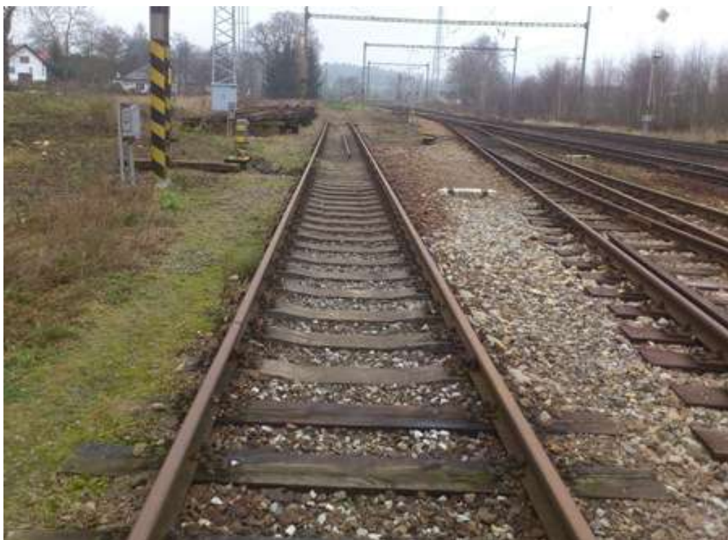
Železniční stanice Leština u Světlé – kusá kolej č. 5b
