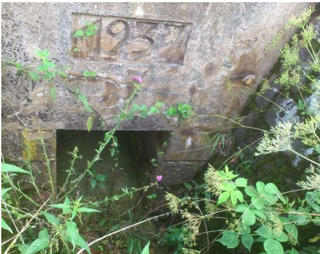
Úsek Světlá nad Sázavou – propustek v km 241,123
