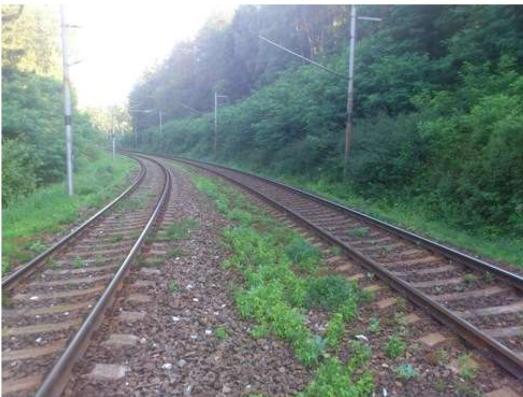
Úsek Vlkaneč – Golčův Jeníkov – směrové oblouky R1 = 284 \text{ m} , R2 = 286 \text{ m}
