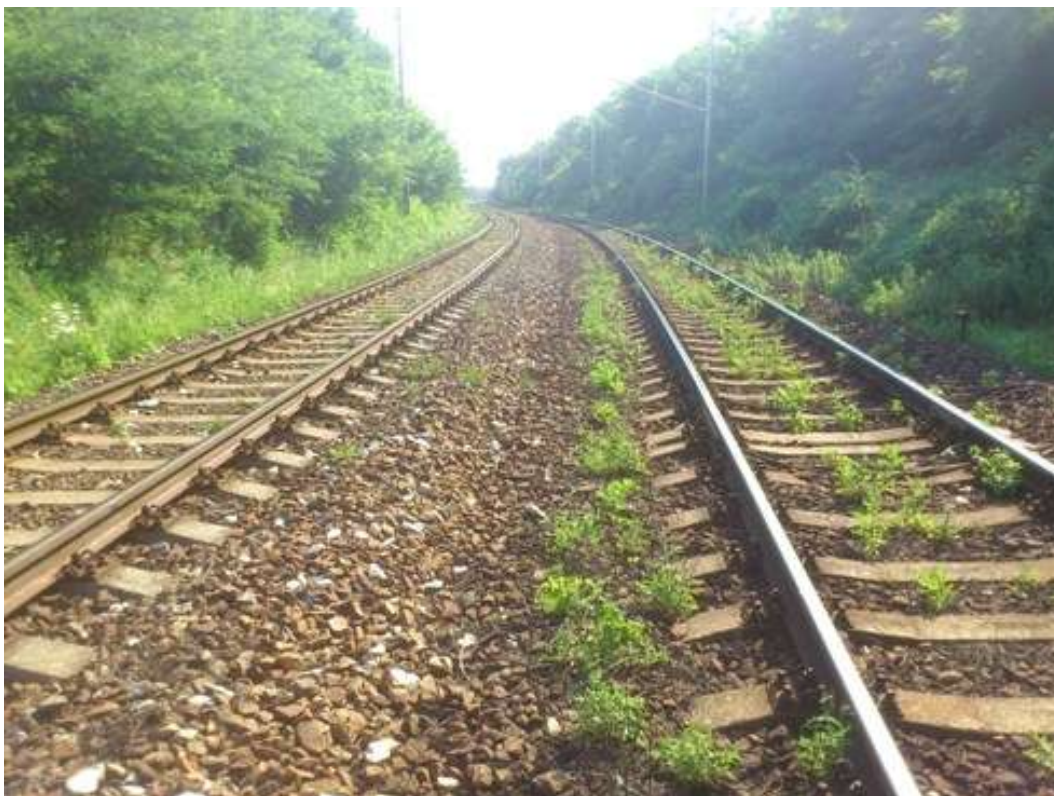
Úsek Vlkaneč – Golčův Jeníkov – směrové oblouky R1 = 500 m, R2 = 505 m
