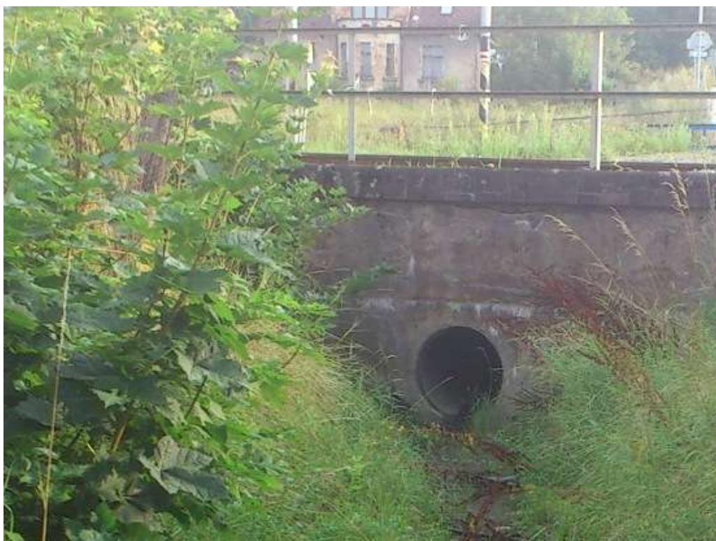
Propustek u železničního přejezdu v km 240,284
