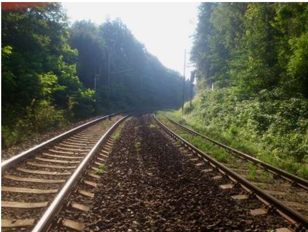
Úsek Vlkaneč – Golčův Jeníkov – směrové oblouky R1 = 306 \text{ m} , R2 = 291 \text{ m}
