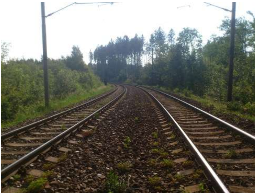
Úsek Vlkaneč – Golčův Jeníkov – směrové oblouky R1 = 400 m, R2 = 404 m
