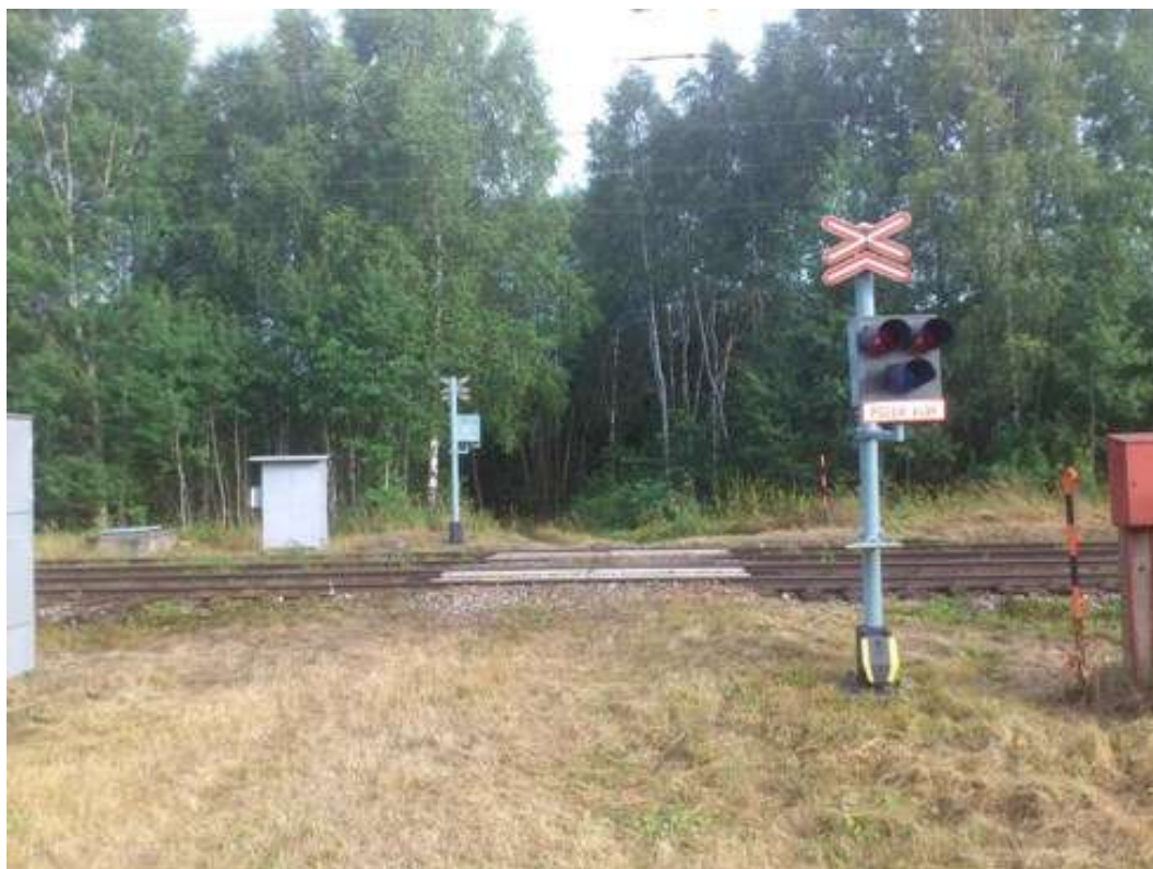
Úsek Světlá nad Sázavou – Josefodol – železniční přejezd v km 241,065
