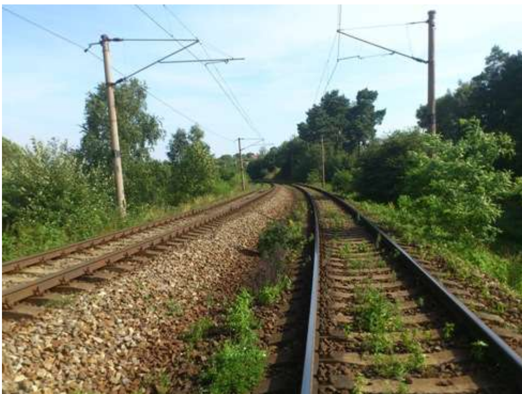
Úsek Leština u Světlé – Nová Ves u Leštiny – směrové oblouky R1 = 498 m, R2 = 502 m
