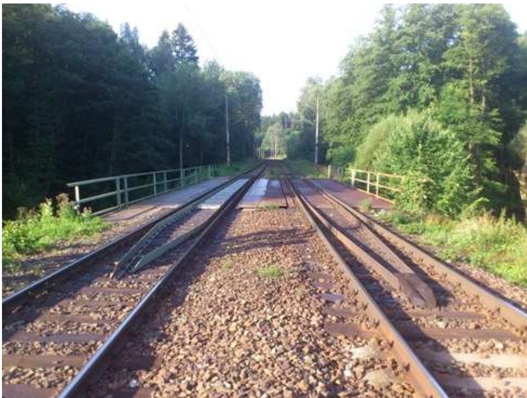
Úsek Sázavka – Leština u Světlé – ocelový most bez průběžného kolejového lože v km 249,330
