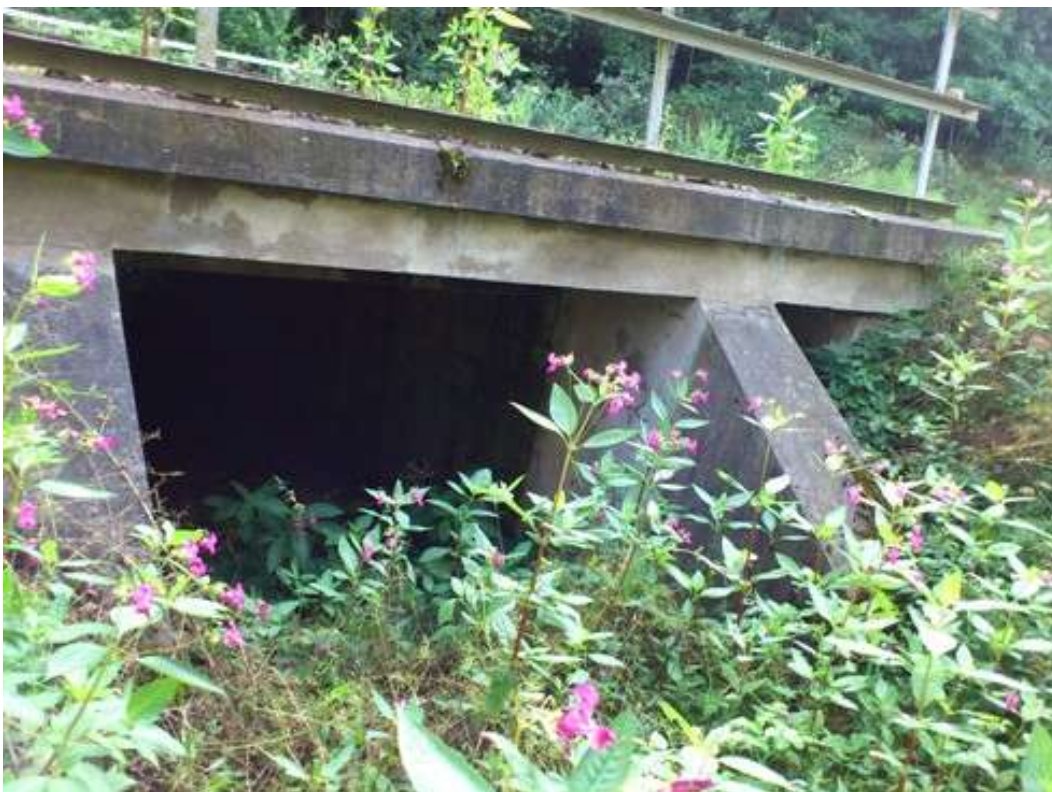
Úsek Josefodol – Sázavka – propustek v km 245,223
