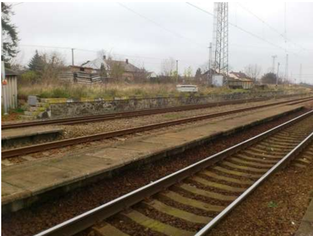
Železniční stanice Vlkanec – rampa
