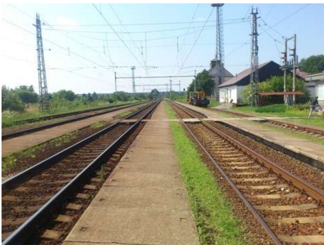
Železniční stanice Vlkaneč – úrovňová nástupiště
