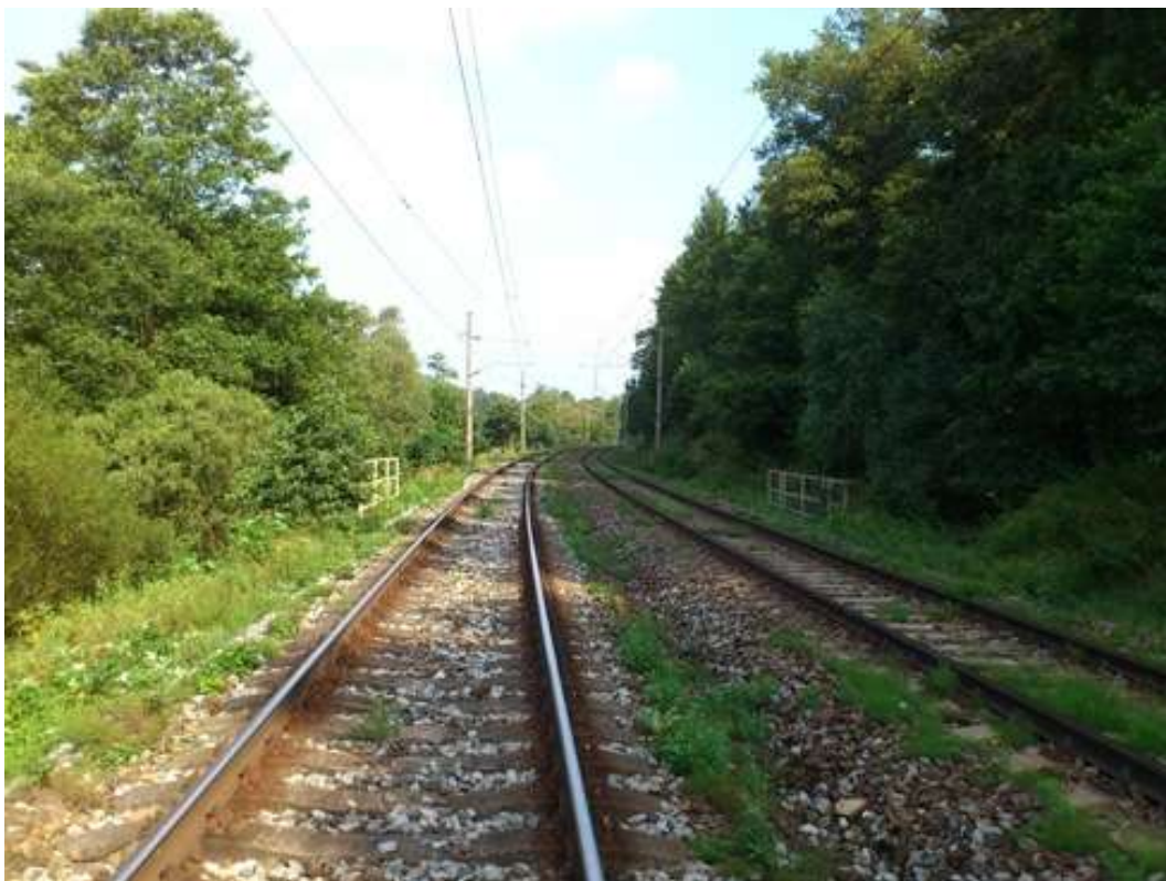
Úsek Josefodol – Sázavka – složené směrové oblouky bez mezilehlých přečhodnic
