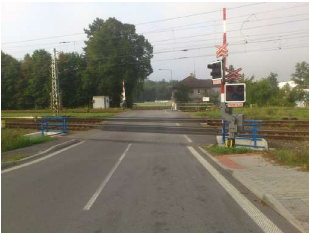
Začátek rekonstruovaného úseku, konec žst. Světlá nad Sázavou
