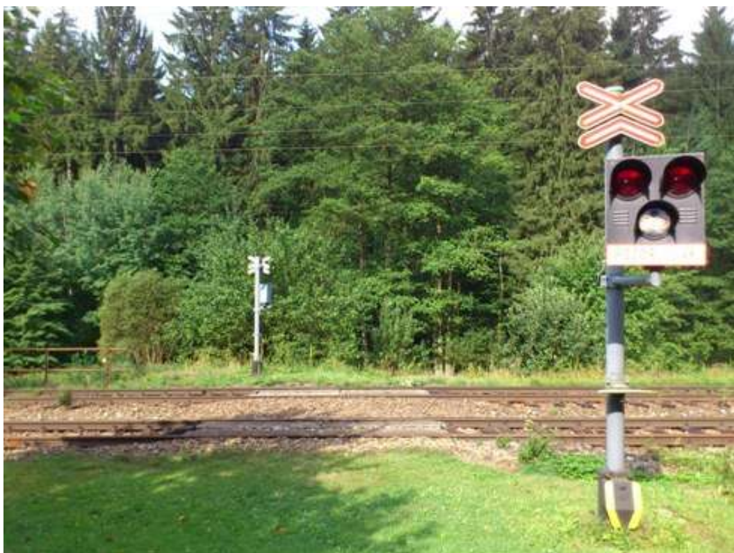
Úsek Josefodol – Sázavka – železniční přejezd v km 244,813
