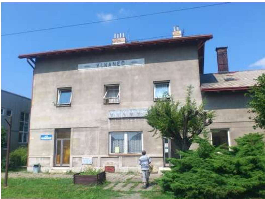
Železniční stanice Vlkanec – výpravní budova
