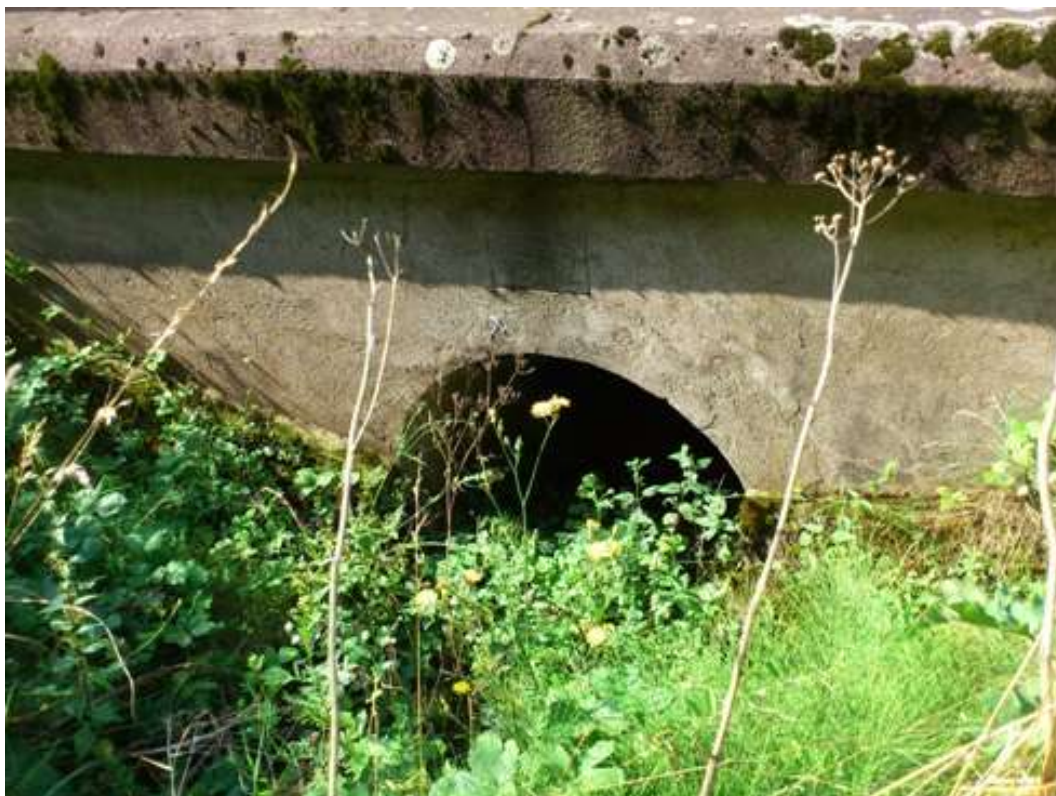
Úsek Josefodol – Sázavka – propustek v km 247,037
