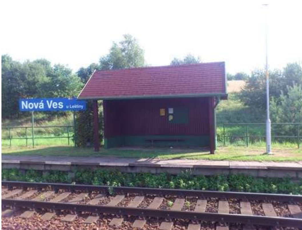
Železniční zastávka Nová Ves u Leštiny
