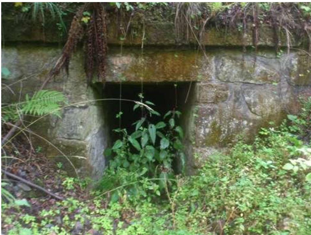
Úsek Josefodol – Sázavka – propustek v km 243,932
