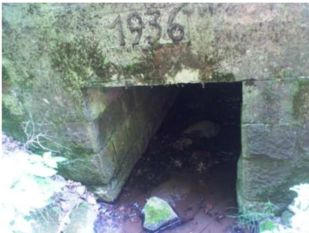
Úsek Sázavka – Leština u Světlé – propustek v km 250,071
