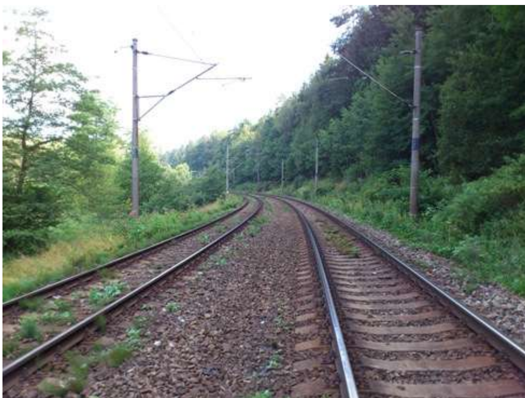
Úsek Josefodol – Sázavka – složené směrové oblouky s mezilehlou přechodnicí
