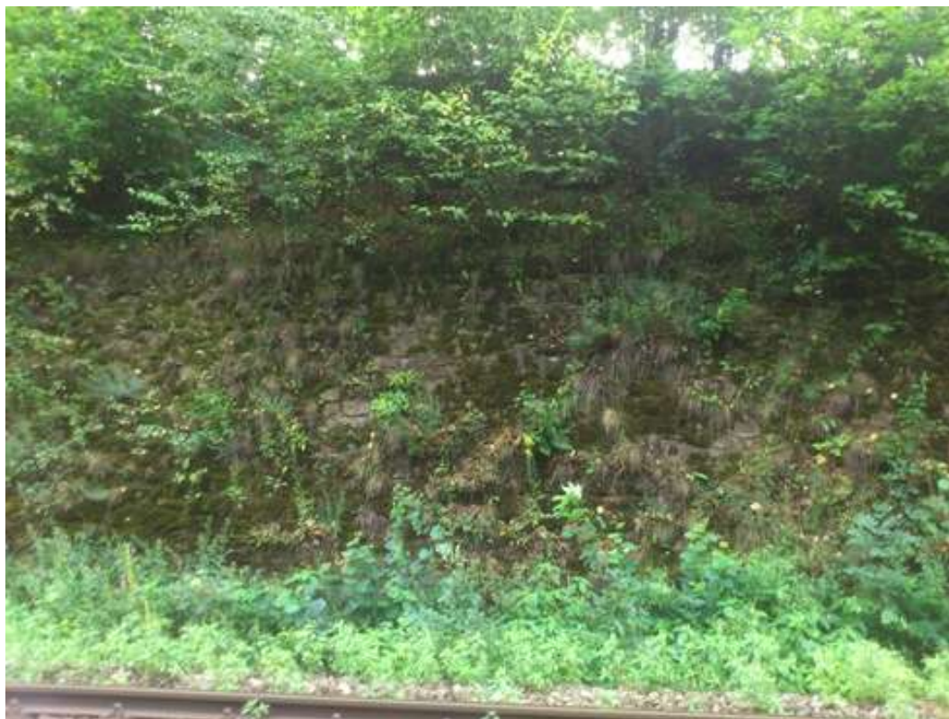
Úsek Josefodol – Sázavka – opěrná zeď v km 243,300
