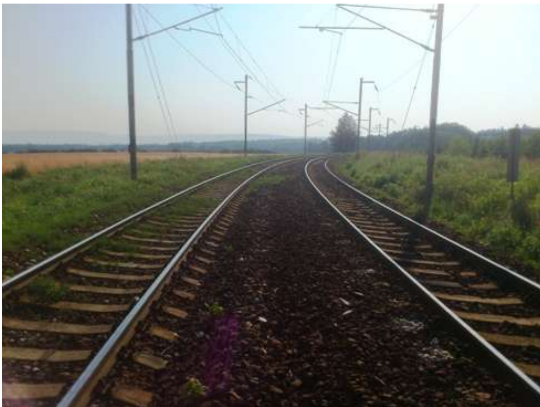
Úsek Vlkaneč – Golčův Jeníkov – směrové oblouky R1 = 300 m, R2 = 296 m
