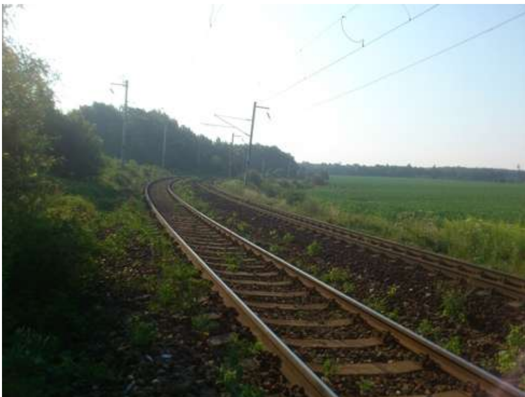
Úsek Vlkaneč – Golčův Jeníkov – směrové oblouky R1 = 285 \text{ m} , R2 = 281 \text{ m}
