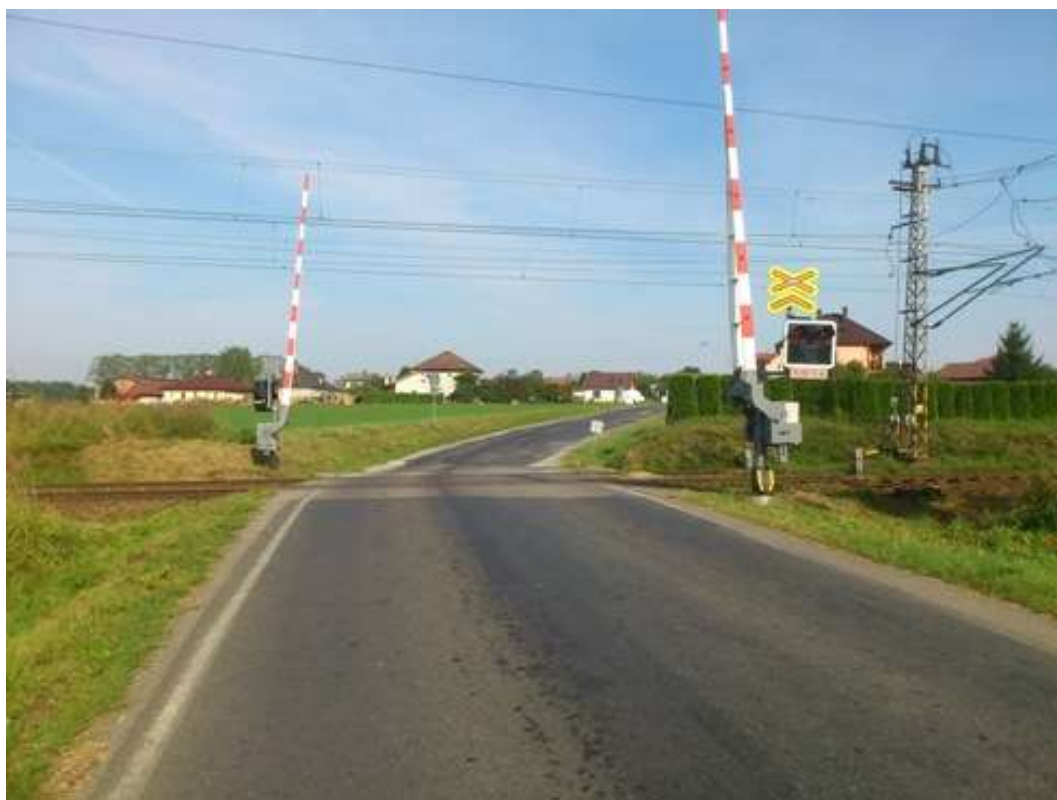
Železniční stanice Leština u Světlé – železniční přejezd km 251,345
