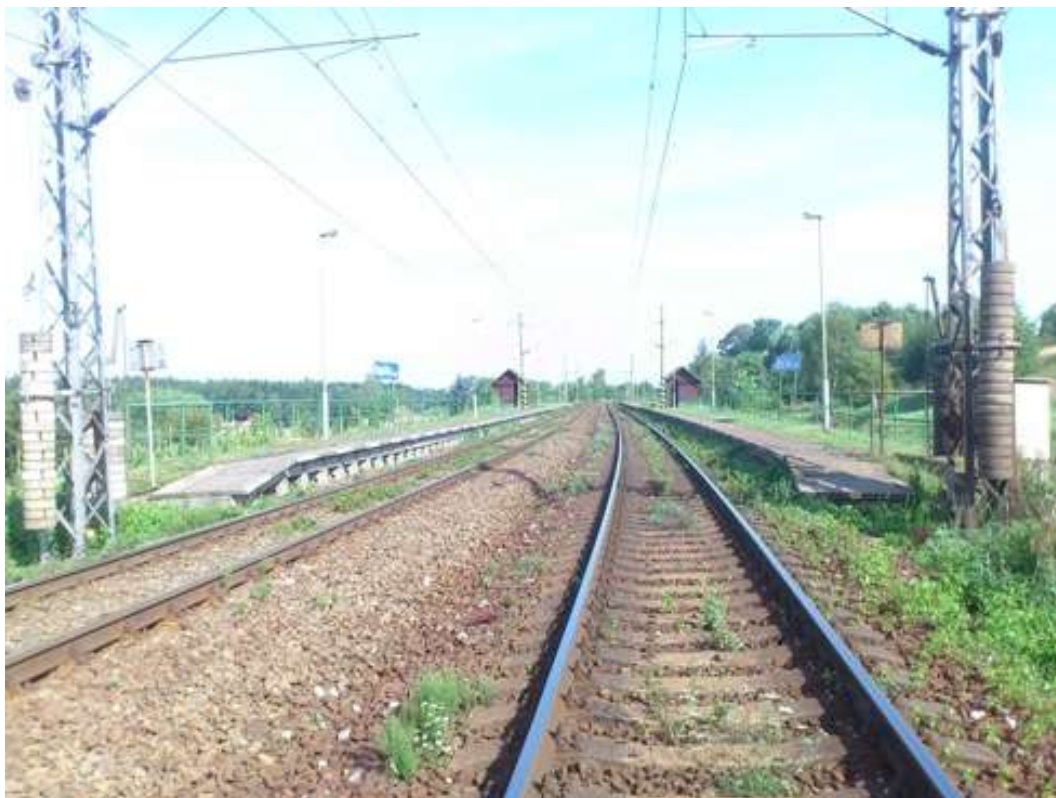
Železniční zastávka Nová Ves u Leštiny
