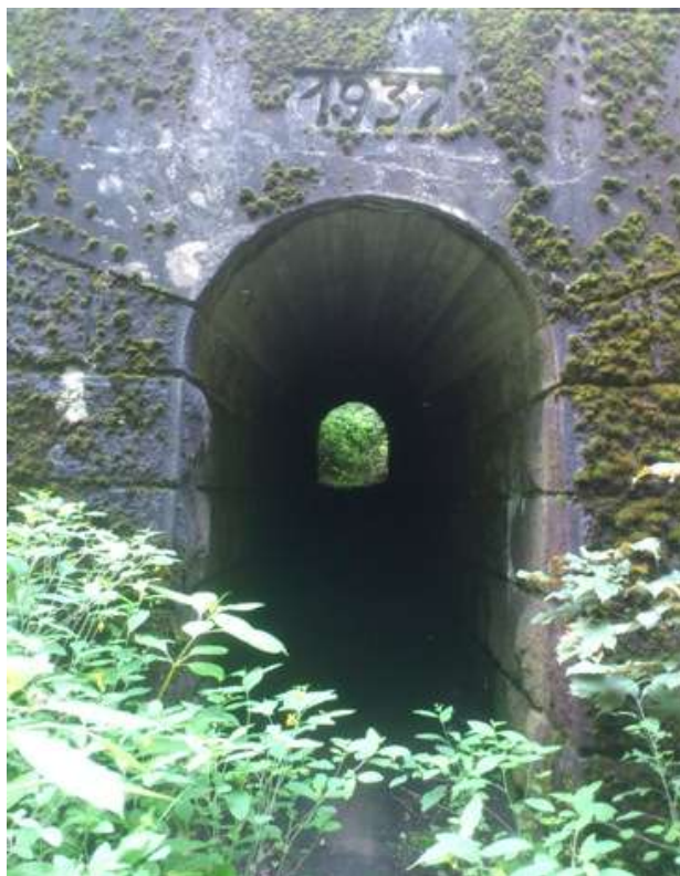
Úsek Světlá nad Sázavou – Josefodol – propustek v km 242,436
