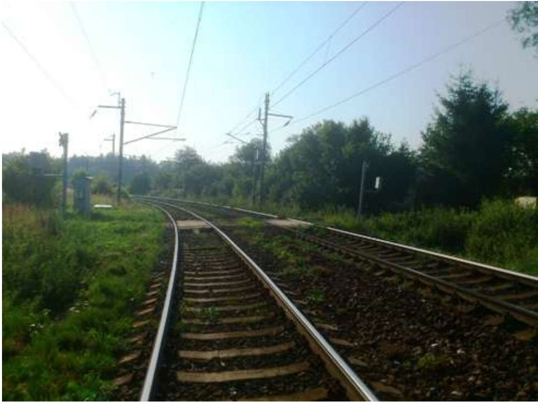
Úsek Vlkaneč – Golčův Jeníkov – směrové oblouky R1 = 300 m, R2 = 303 m
