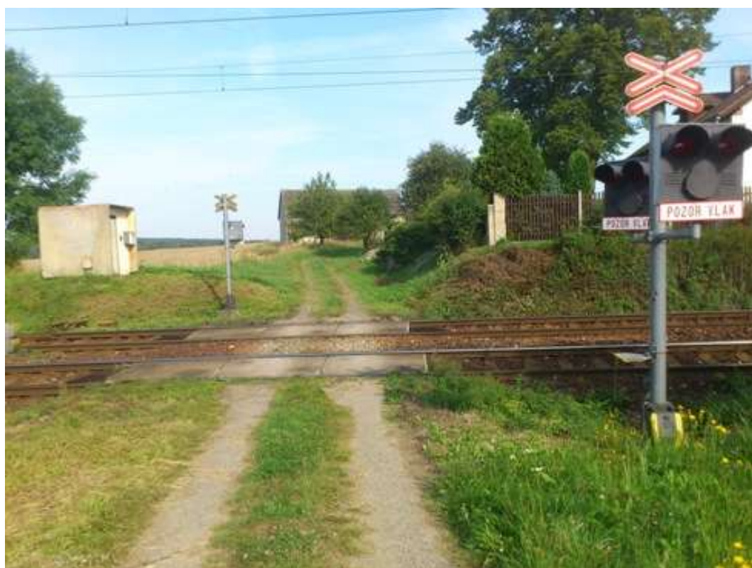
Úsek Leština u Světlé – Nová Ves u Leštiny – železniční přejezd km 252,528
