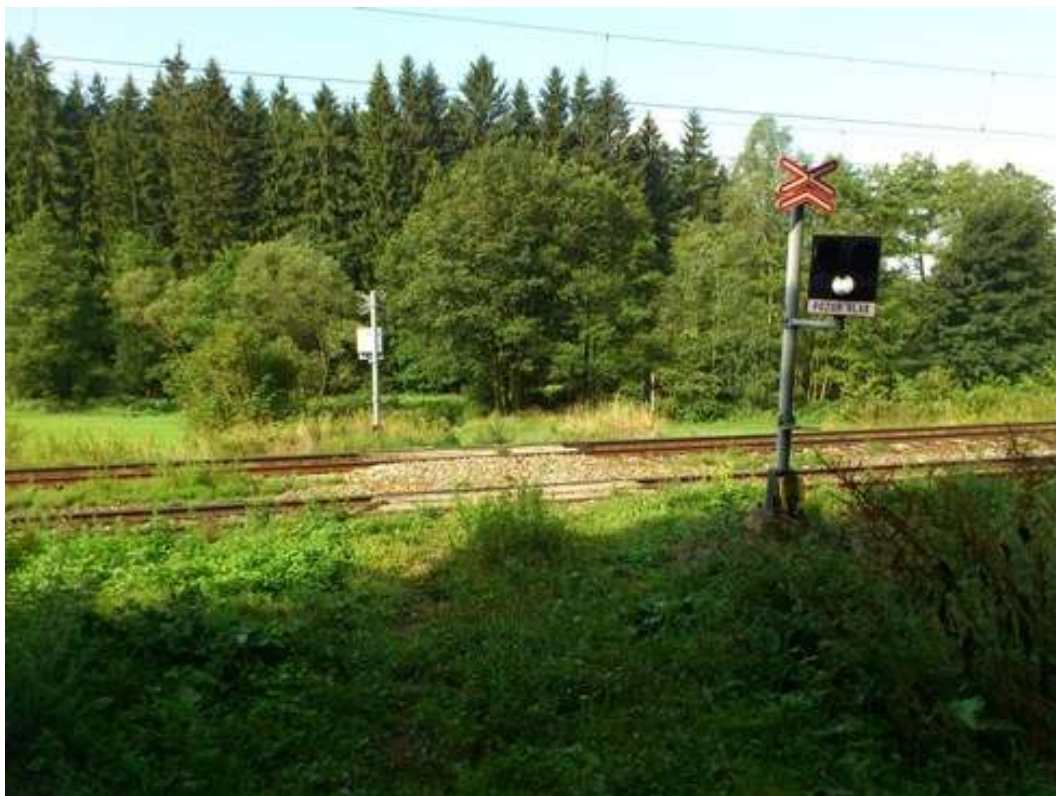
Úsek Josefodol – Sázavka – železniční přejezd v km 245,476
