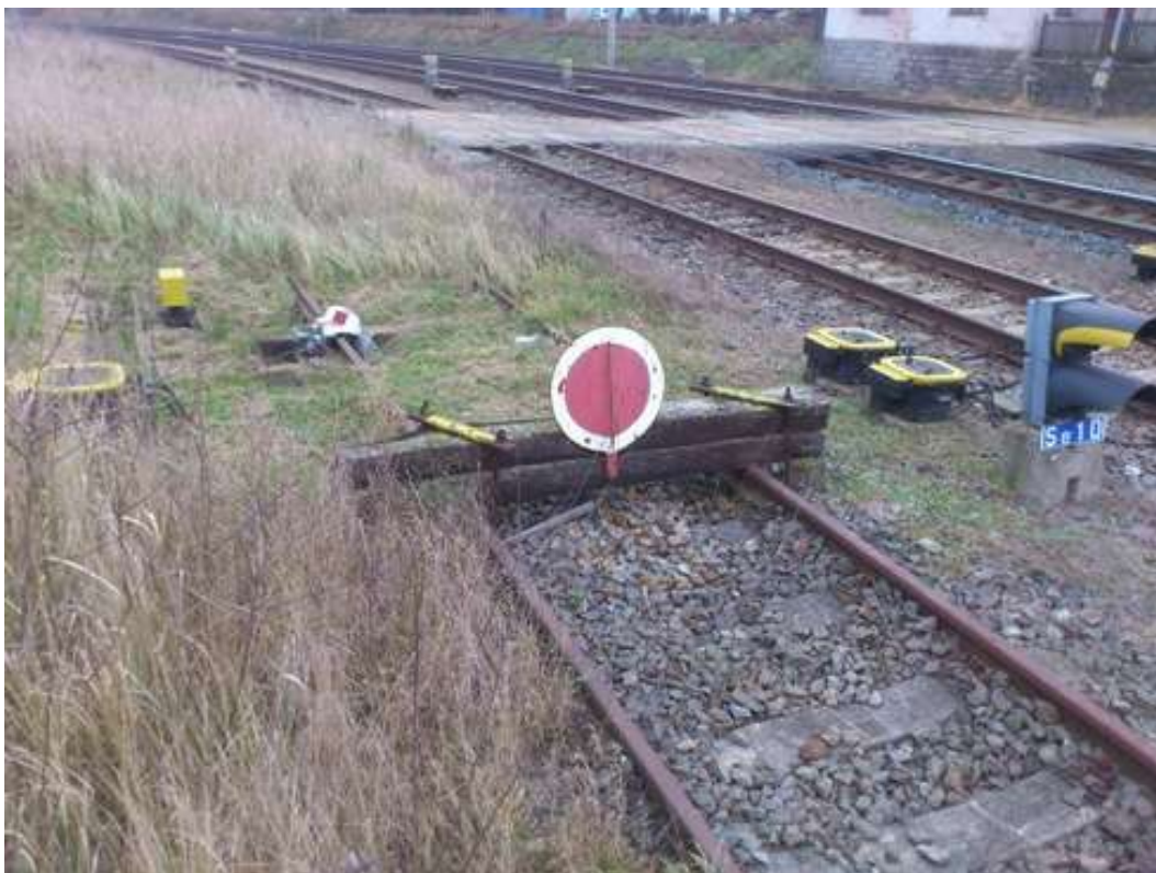
Železniční stanice Vlkaneč – Výkolejka vk. 2 před železničním přejezdem
