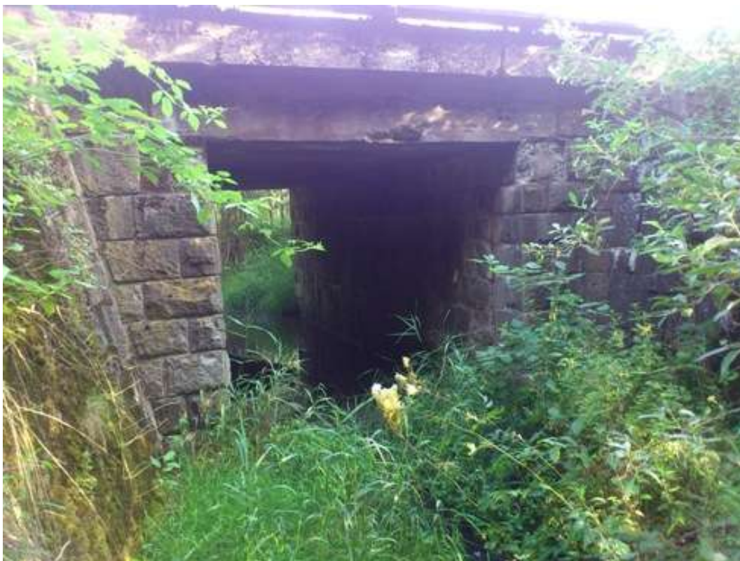
Úsek Sázavka – Leština u Světlé – most s průběžným kolejovým ložem v km 250,871
