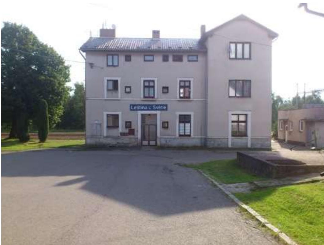
Železniční stanice Leština u Světlé – výpravní budova
