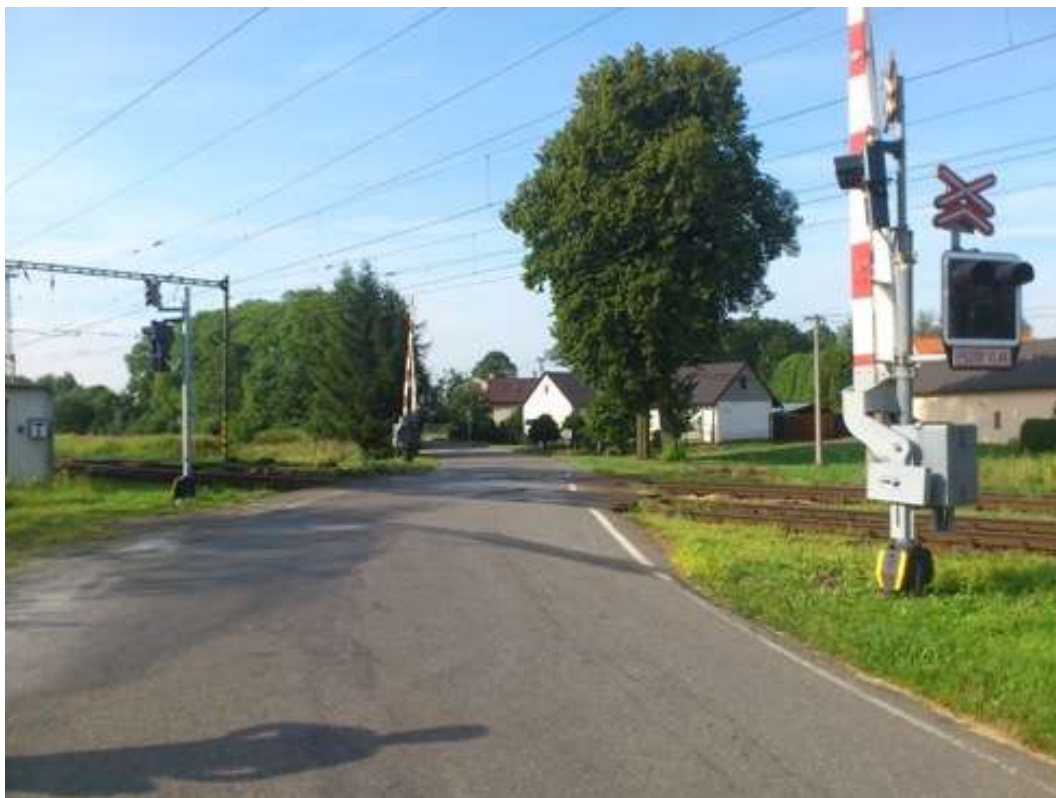
Úsek Leština u Světlé – Nová Ves u Leštiny – železniční přejezd km 252,221
