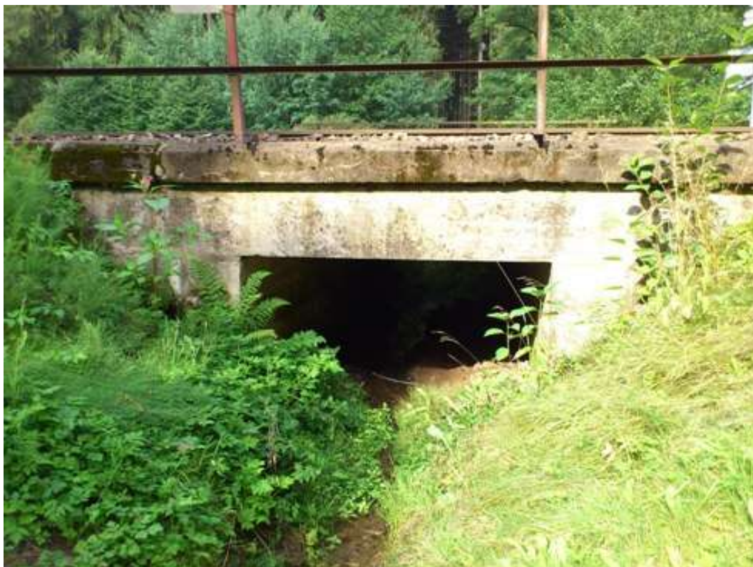
Úsek Josefodol – Sázavka – propustek v km 244,803
