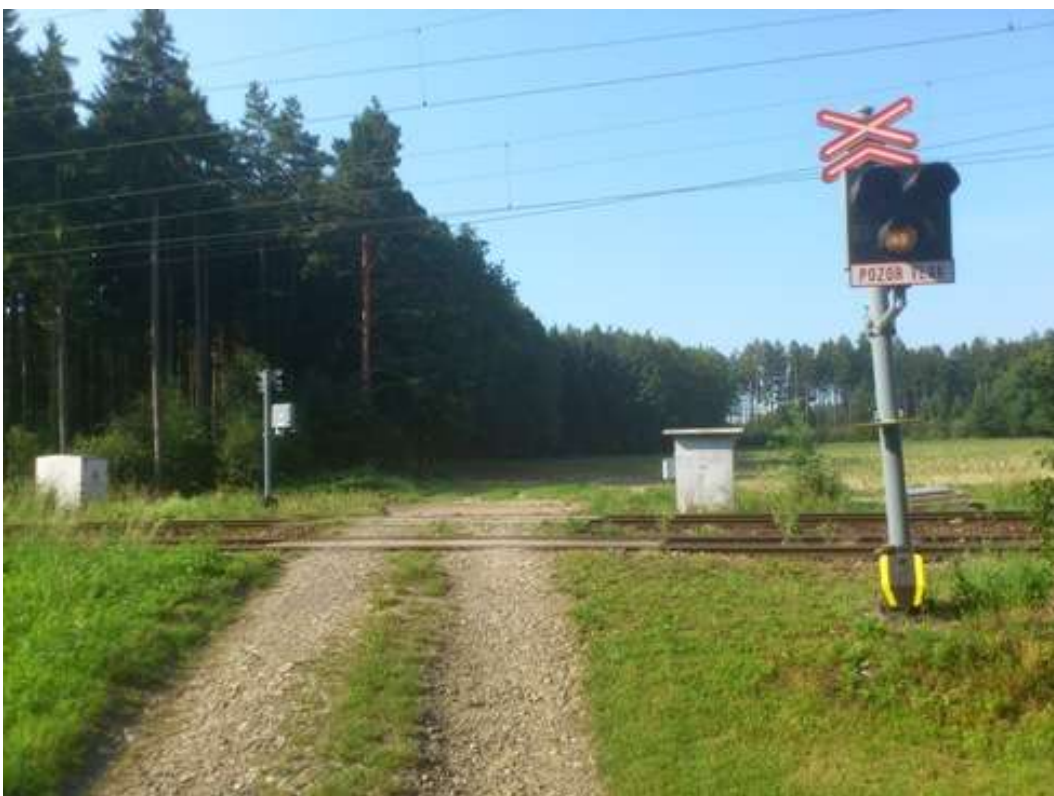
Úsek Vlkaneč – Golčův Jeníkov – železniční přejezd km 261,436
