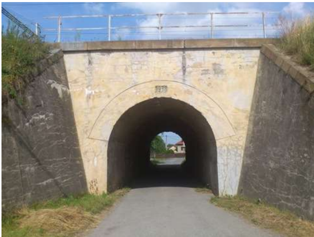
Železniční stanice Vlkaneč – most km 256,913
