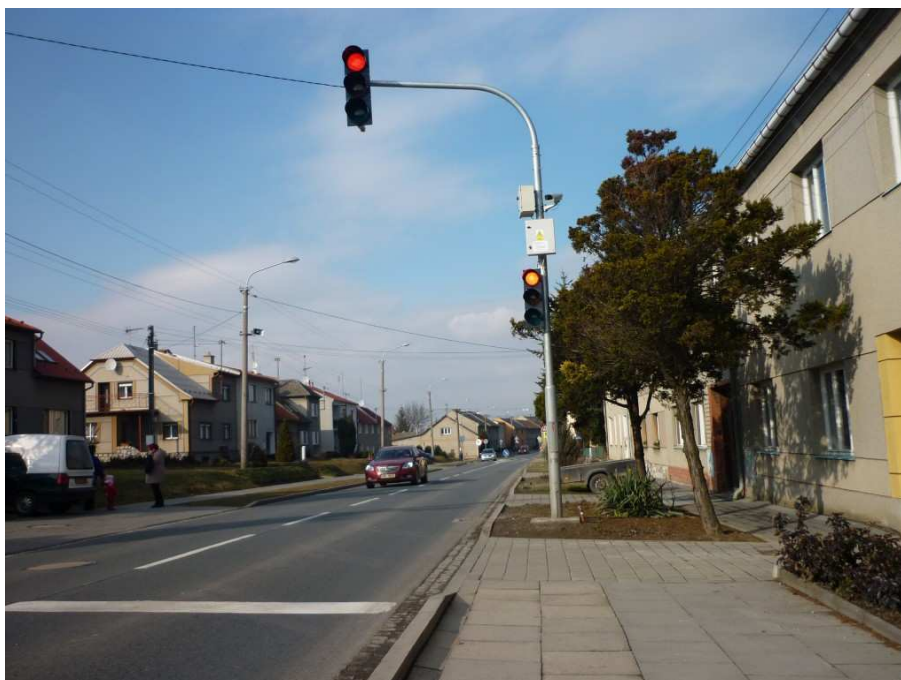
Obr. 4 Pohled na funkční IDZS v obci Kožušany Zdroj: (GEMOS CZ s.r.o.)
