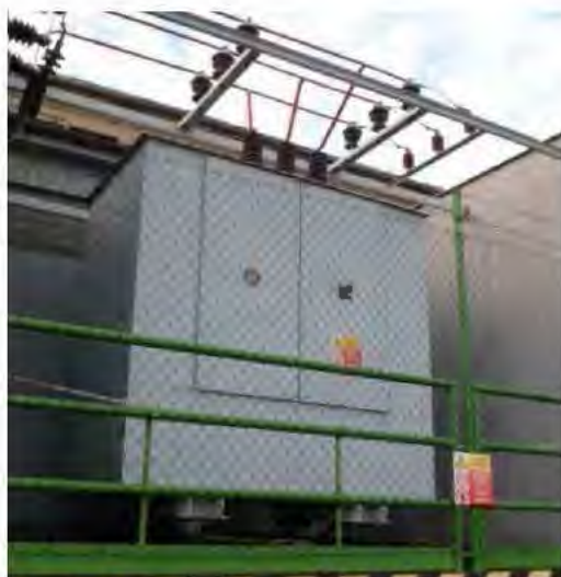
Obr. 36 Venkovní skříňové provedení suchého trakčního transformátoru ČKD [8]
