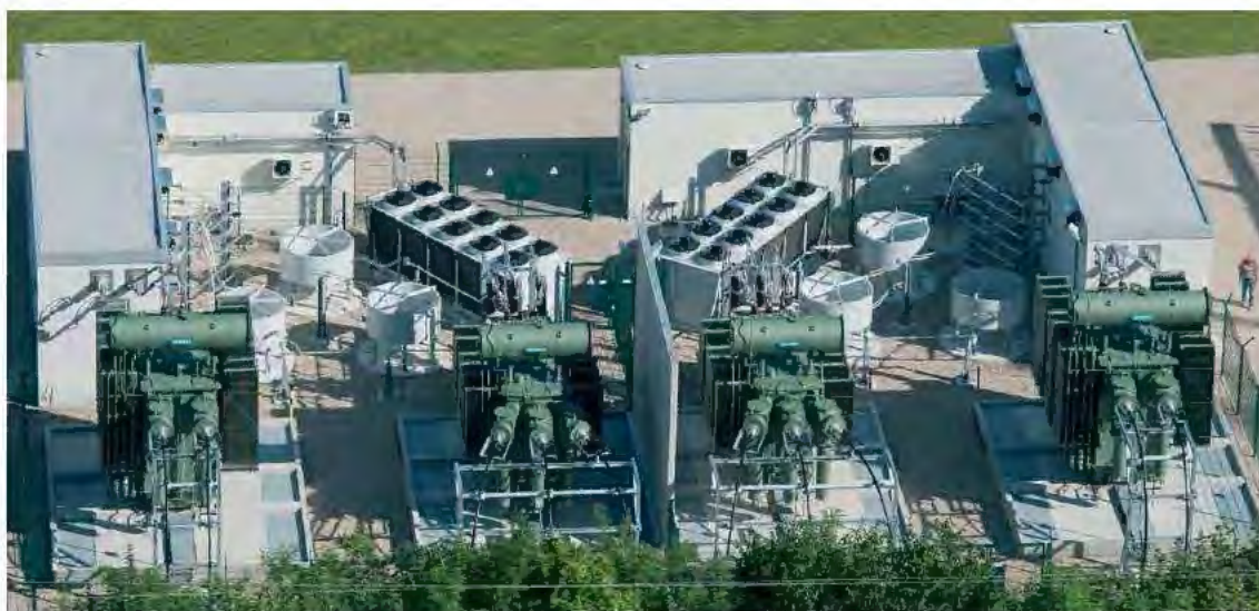
Obr. 49 TM pro napájení trakční sítě 16,7 Hz (Norimberk) [31]
