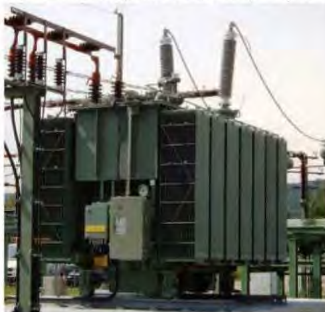
Obr. 44 Trakční transformátor 15 MW, 120/17,25 kV typ hermetik pro Deutsche Bahn [17]
