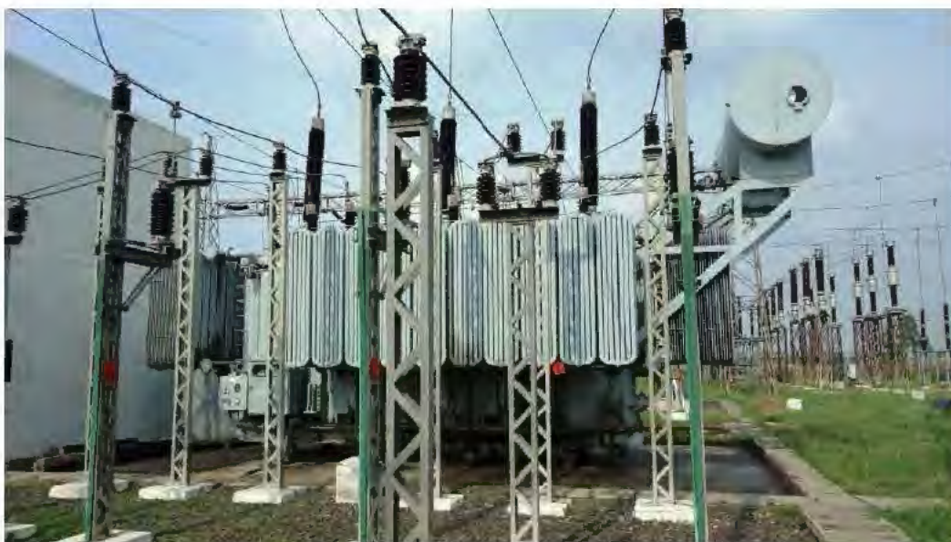
Obr. 67 Trakční transformátor pro síť 2 \times 25 kV [25]
