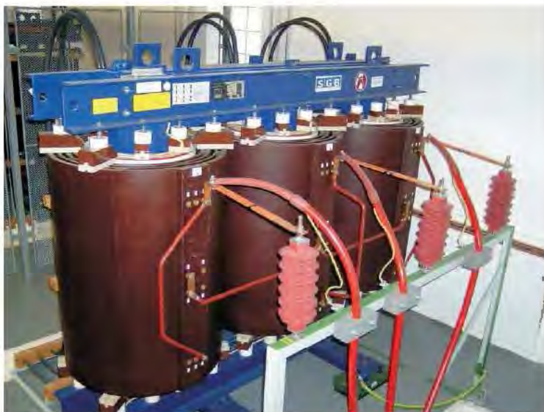
Obr. 7 Trakční transformátor 1000 kVA, 22/0,65 kV [10]
