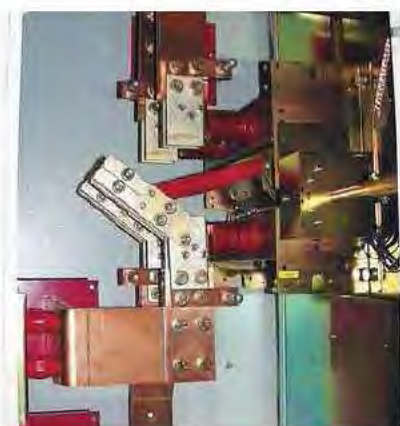
Obr. 10 Odpojovače (klasický v měničném, úsekový pod krytem – metro) [12]
