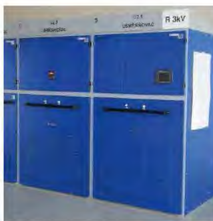
Obr. 38 Skříňový usměrňovač EZB [11]
