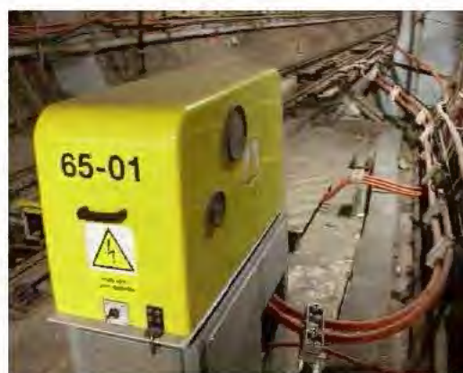
Obr. 10 Odpojovače (klasický v měničném, úsekový pod krytem – metro) [12]
