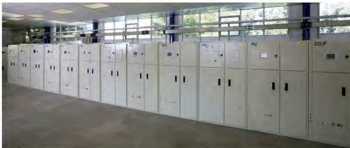
Obr. 56 Skříňový rozváděč TT 27 kV [26]
