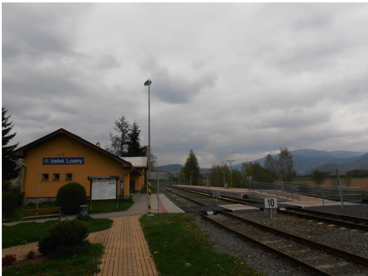
Obrázek 6 Rekonstruované nástupiště v ŽST Velké Losiny
