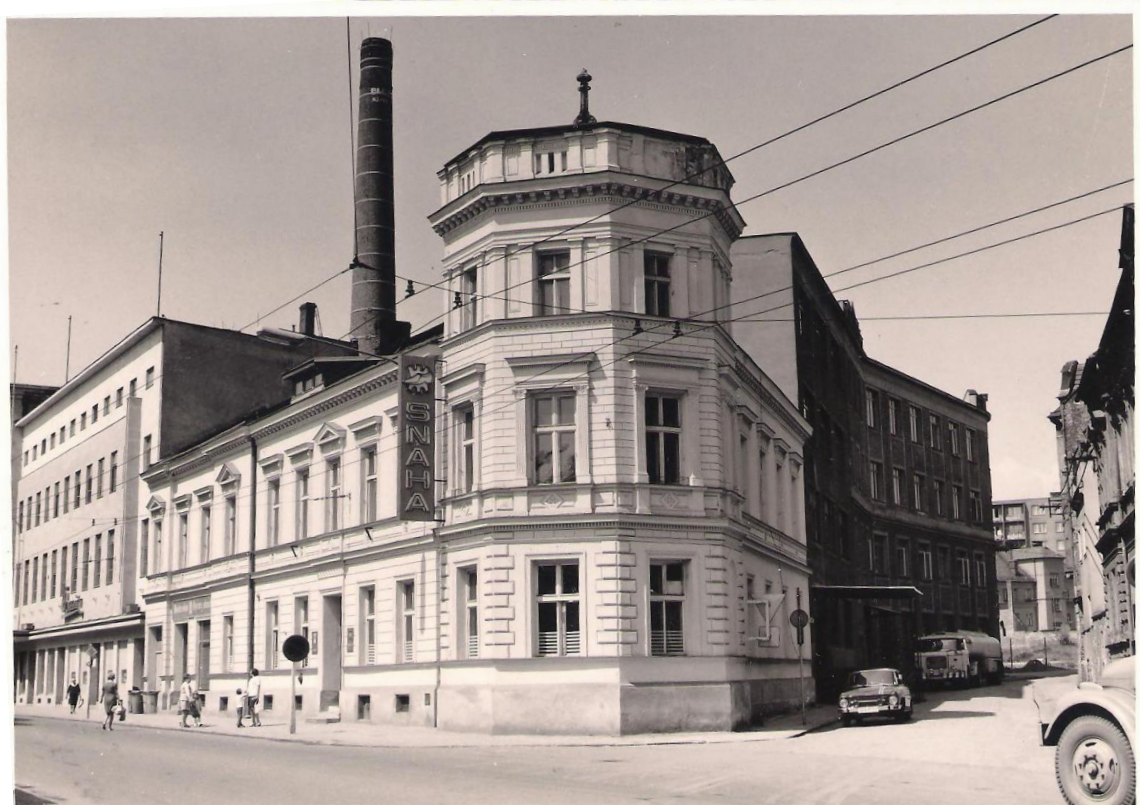
4. Opavia v roce 1977, nalevo původní objekt na Olomoucké, napravo dostavba na ulici Provaznická
