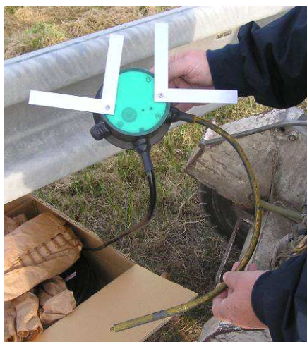
Obrázek č. 31 a 32 – Instalace vozovkového čidlo LUFT ISR31 s měřením teploty povrchu vozovky a dále v úrovni 5 a 30 cm pod povrchem na meteostanici Zhoř na silnici č. II/358 (foto autor)
