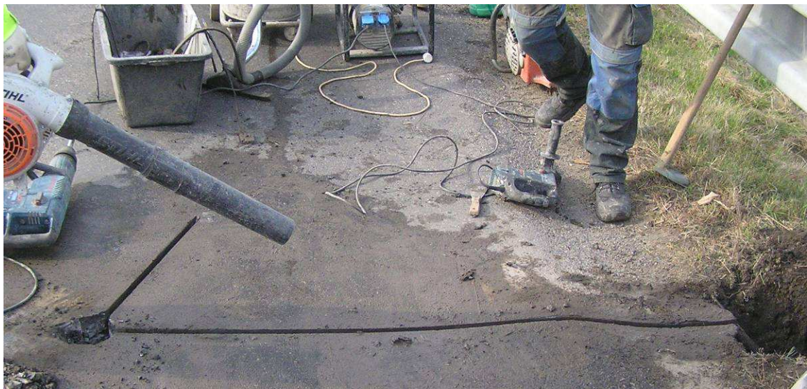
Obrázek č. 31 a 32 – Instalace vozovkového čidlo LUFT ISR31 s měřením teploty povrchu vozovky a dále v úrovni 5 a 30 cm pod povrchem na meteostanici Zhoř na silnici č. II/358 (foto autor)
