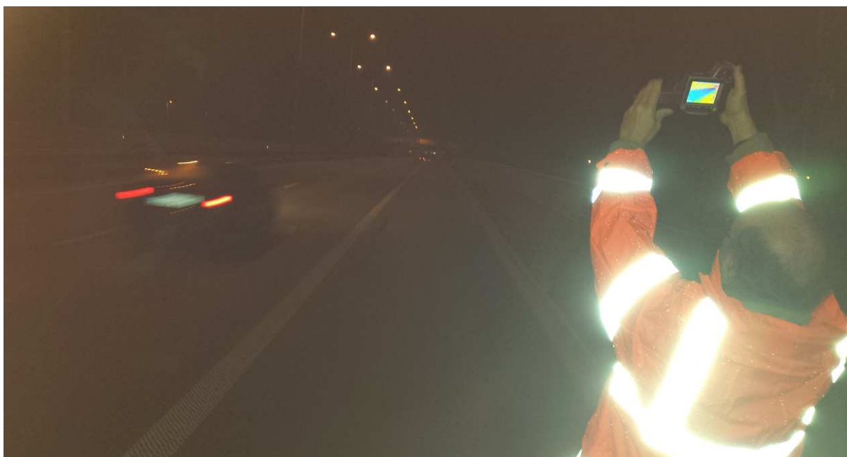
Foto z měření termovizní na silnici č. I/36 dne 12.3.2014 Pardubice, Rosice nad Labem - mosty č. 36-
