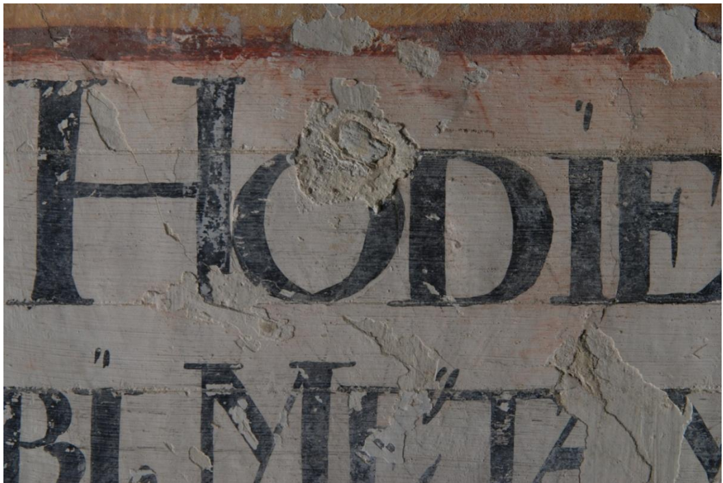
Obr. 12: Písmena v nástavci epitafu. Detail poškození odpadnutím podkladu malby.
