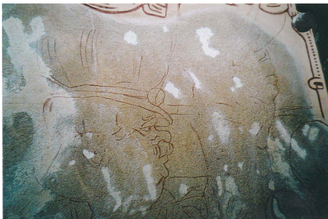
Obr. 44 : Prostějov, dům Vladimíra Součka, malířská výzdoba štítu na jižní fasádě. Detail červeně probarvené ryté kresby na levé straně štítu. Stav během restaurování.
