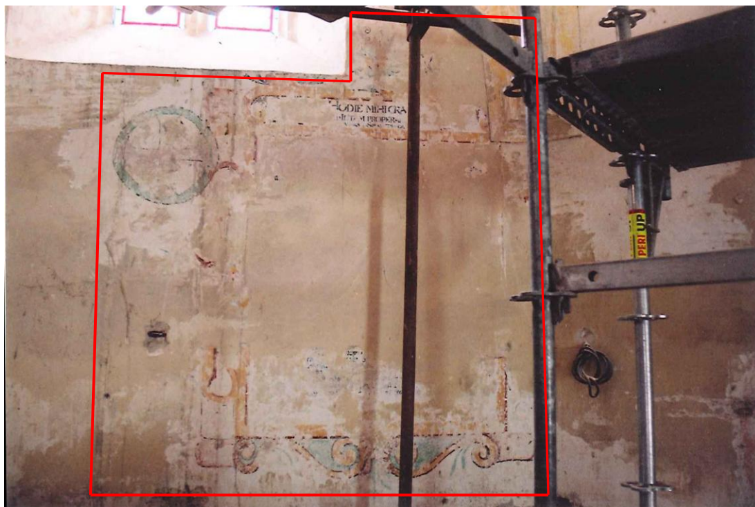
Graf.1: Grafické vyznačení úseku vymezeného k restaurování. Celkový rozměr plochy určené k restaurování je 3,8m 2 .
