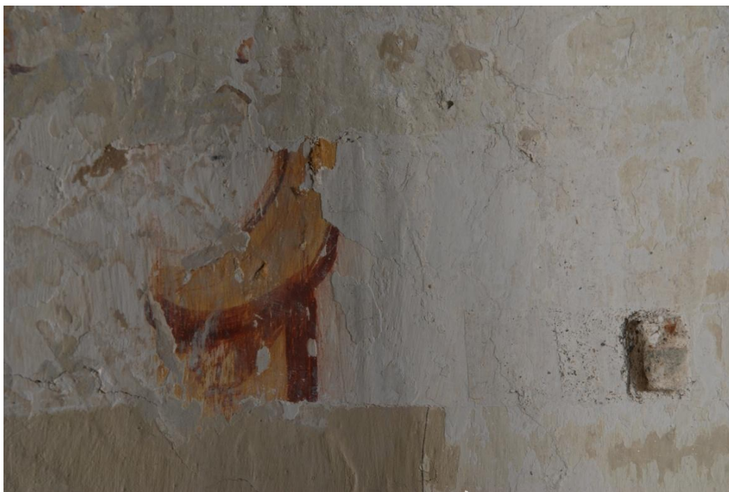
Obr. 9: Detail iluzivního orámování v průběhu odkrývání. Napravo od rámu je stratigrafická sonda. 0-omítka, 1-bílá vápenná vrstva, 2-vrstva s malbou.
