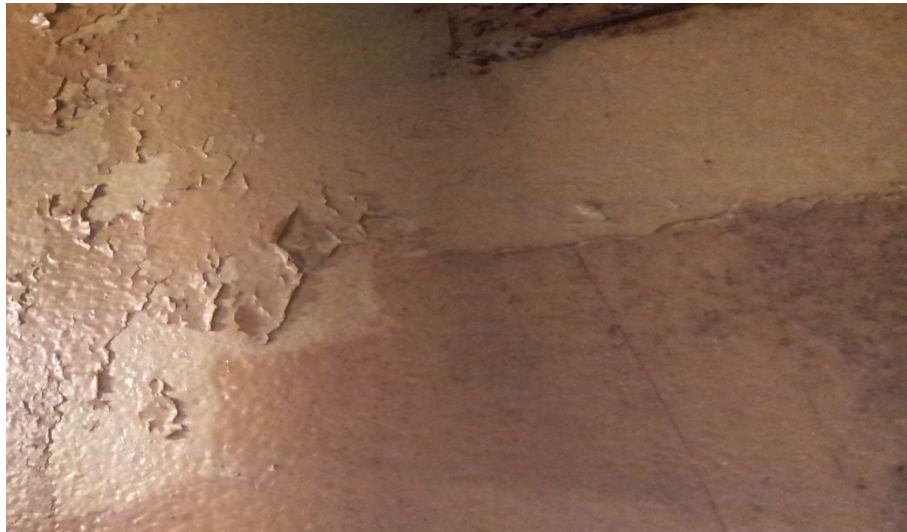
Obrázek 3 Ocelová konstrukce v objektu E11 esterifikace celulózy ( výřez )
