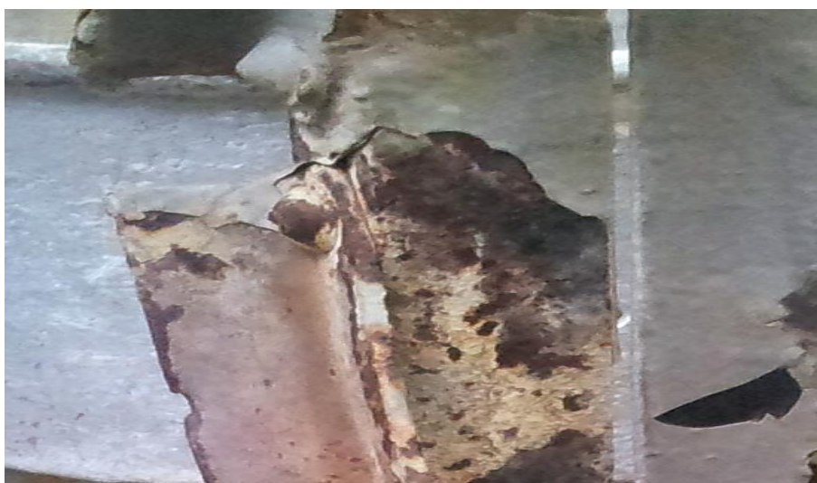
Obrázek 12 Ocelová konstrukce v objektu E4 stabilizace alkalickým varem ( výřez )
