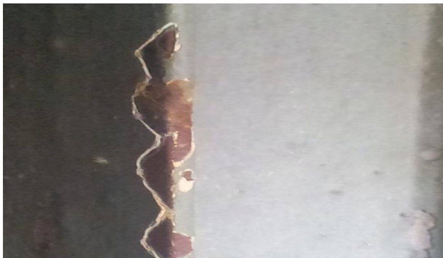
Obrázek 8 Ocelová konstrukce v objektu E9 paření nitrocelulózy ( výřez )
