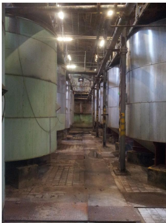
Obrázek 14 Ocelové konstrukce v objektu E4 stabilizace alkalickým varem ( celek )
