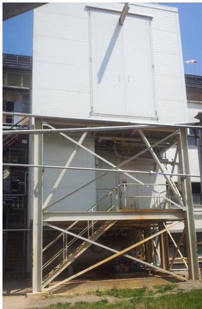
Obrázek 6 Ocelová konstrukce v objektu E11,odstřed'ování nitrocelulózy na odkyselňovacích odstředivkách Bowas II. ( celek )
