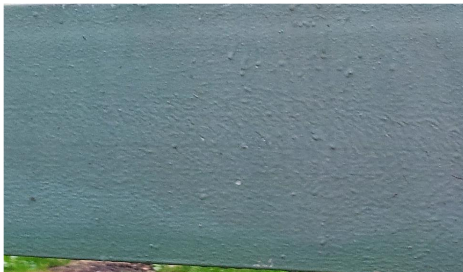
Obrázek 2 Ocelová konstrukce vně objektu E14 ( výřez )
