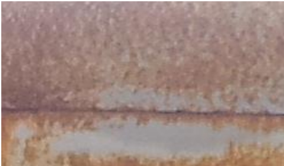
Obrázek 10 Ocelová konstrukce v objektu E9 řezání nitrocelulózy ( výřez )
