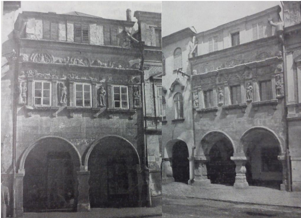
Obr.: 26. Litomyšl. Dům čp.110, U Rytířů před a po rekonstrukci (zdroj: WAGNER, Jaroslav. Dům U Rytířů v Litomyšli a jeho oprava. In Zprávy památkové péče . Roč. 1965/25, č.: 10, str. 289).
