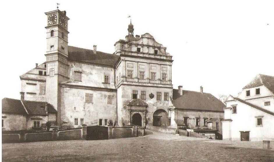
Obr.: 13. Pardubice. Zámek, nádvoří a vstup do zámku, stav před rekonstrukcí (zdroj: RAZSKAZOV, Jiří. RAZSKAZOV, Jiří – KOTYK, Jiří – ŘEHÁČEK, Jan. Pardubice v běhu staletí, 2012, str. 15).
