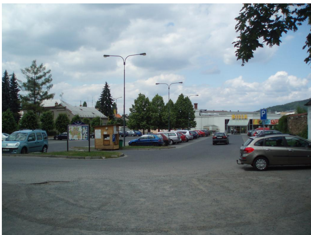
Obr.: 49. Moravská Třebová. Obchodní dům a odstavné parkoviště v Komenského ulici, současný stav (foto autorka).
