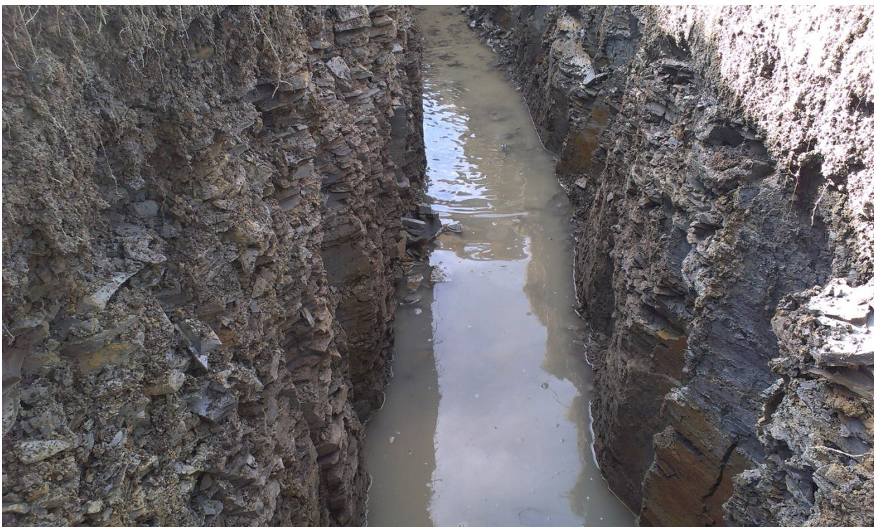
Obrázek C2 2 Průzkumná rýha hloubka 1,5 m
