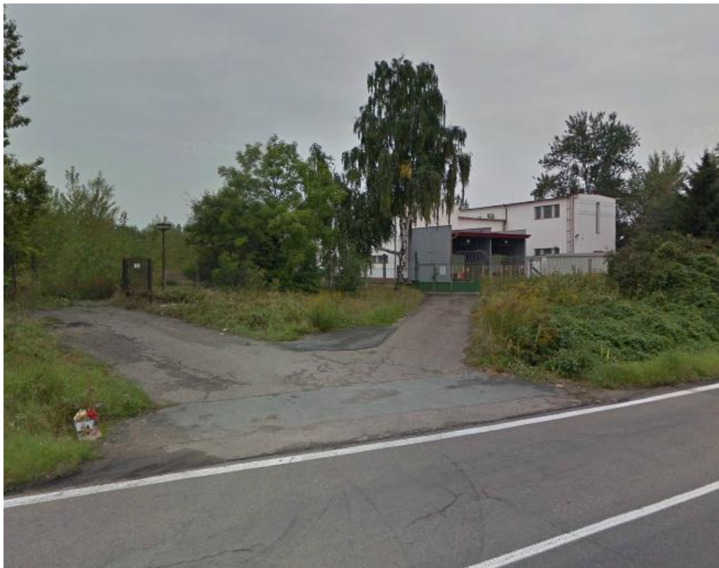
Fotografie č. 4 - stávající sjezd k trafostanici ČEZ
