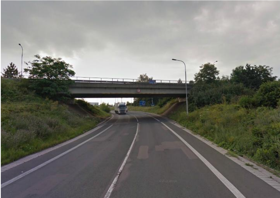
Fotografie č. 3 - pohled na zachovanou mostní konstrukci z r. 1992
