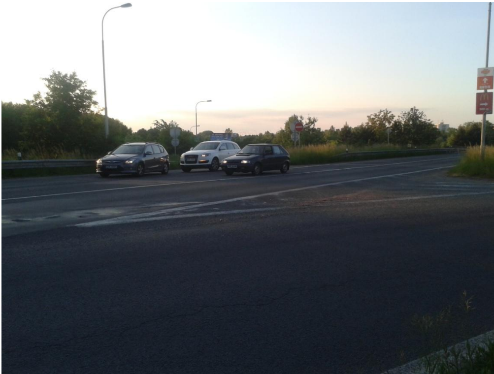
Fotografie č. 1 - kritické napojení větve HK - CHR na silnici I/37 s dopravním značením „STŮJ, DEJ PŘEDNOST V JÍZDĚ“
