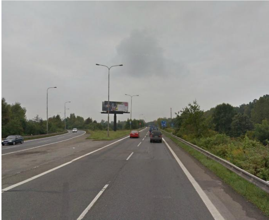
Fotografie č. 5 - rozdělení čtyřpruhové komunikace v severní části křižovatky, od Hradce Králové
