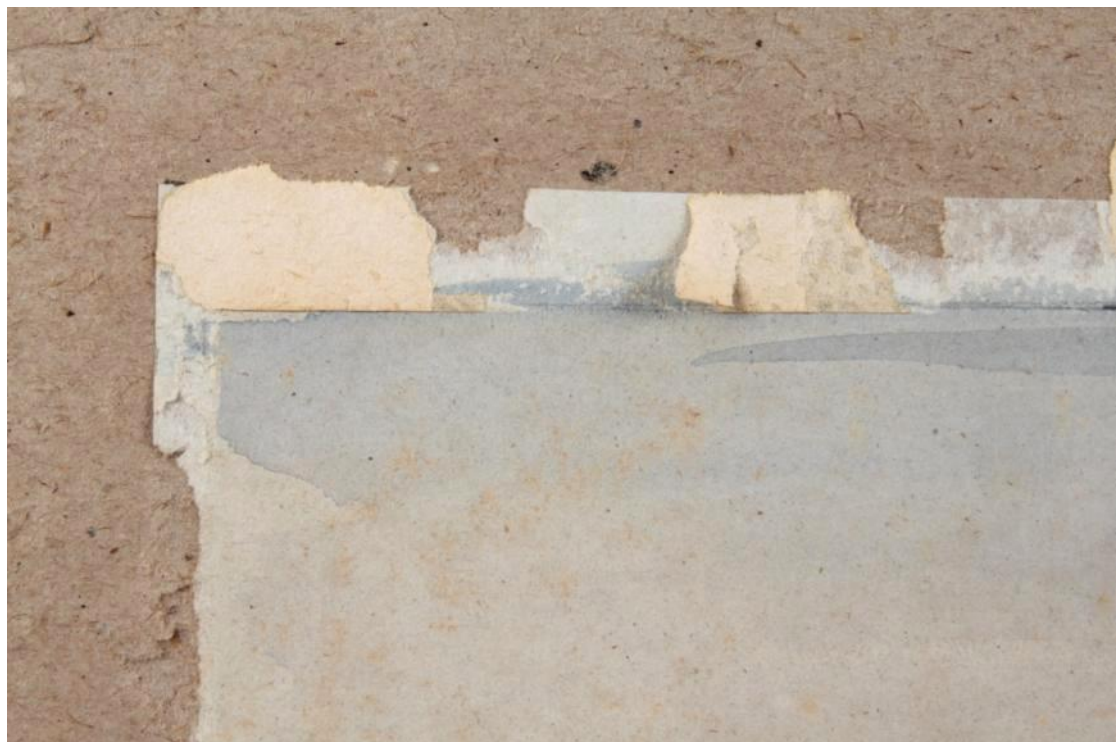
Obr. 40 Nábřeží Admirality , před restaurováním, detail poškození
