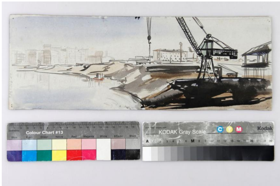
Obr. 87 Výstavba Moskvy , po čištění vodno-etanolovými obklady
