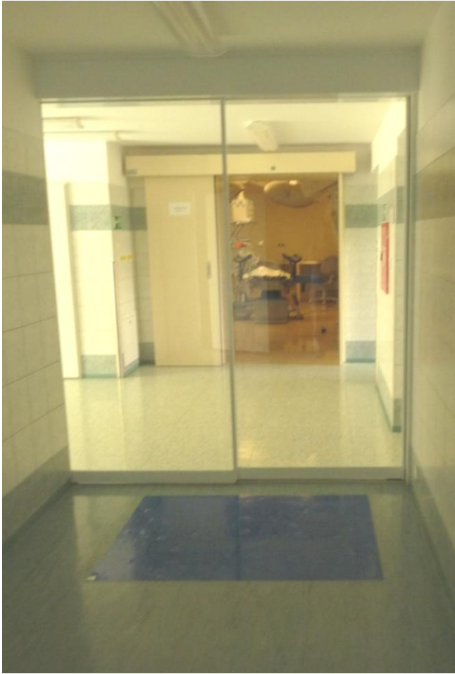
Obrázek 3 Vstup do čisté zóny
