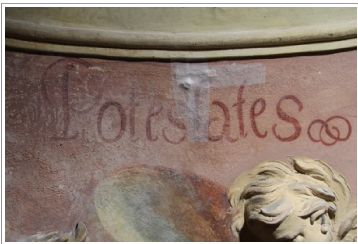
Obr. č. 8 Detail malby anděla, puchýř s odtrženým intonacem, po zajištění přelepem
