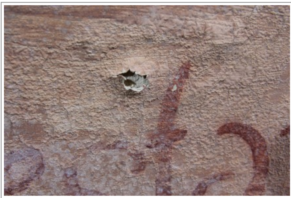
Obr. č. 6 Detail malby anděla, stav před nanesením ochranných přelepů (říjen 2013) Puchýř s odtrženým intonacem
