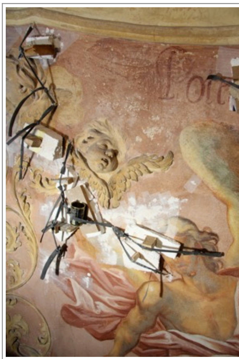
Obr. č. 32 Horní část výjevu, průběh injektáže ohroženého intonaca
