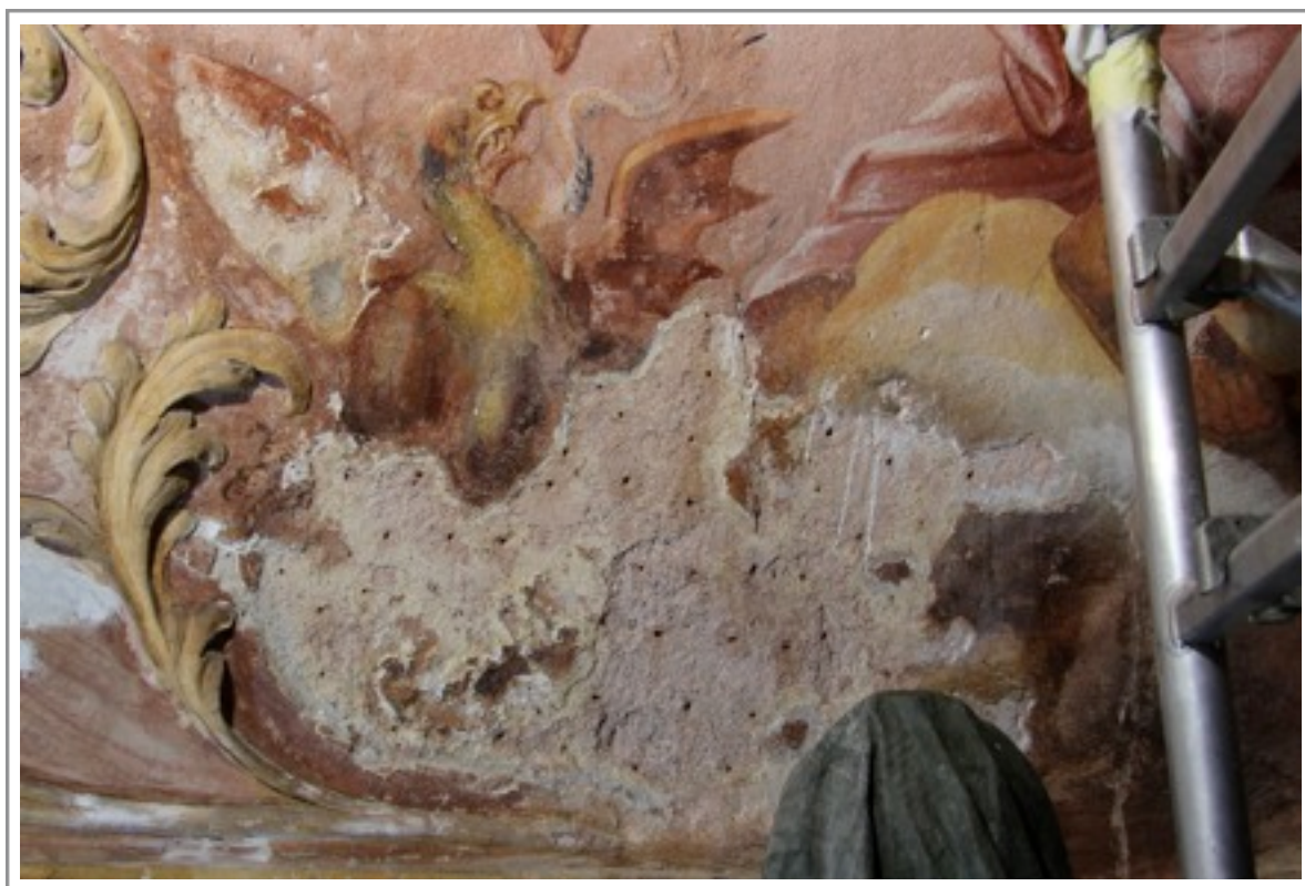
Obr. č. 34 Malba baziliška, stav po odstranění tmelu a následné injektáži
