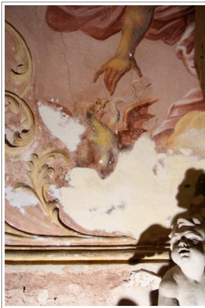
Obr. č. 9 Detail malby baziliška, stav před restaurováním Tmel ze zajišťovacího zásahu (2005 a 2006)
