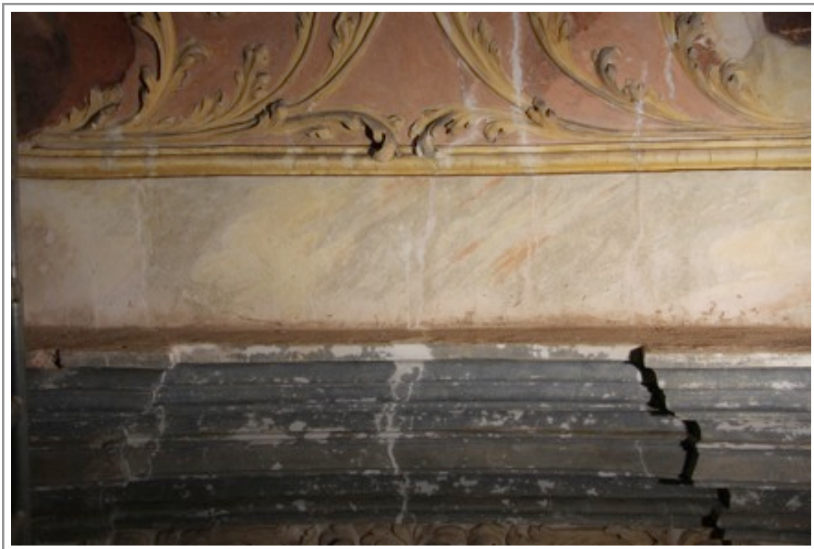
Obr. č. 37 Pás s oblaky, stav po čištění a tmelení
