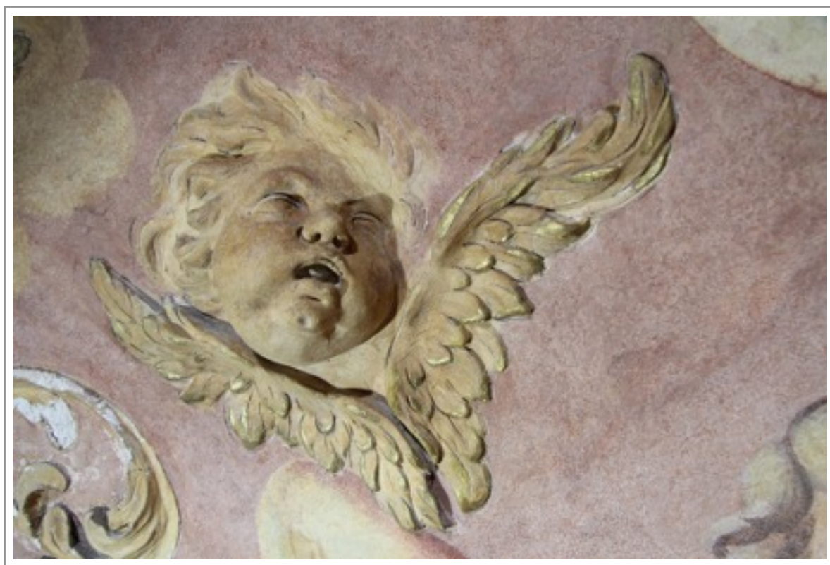
Obr. č. 48 Okřídlená štuková hlava anděla, stav po restaurování
