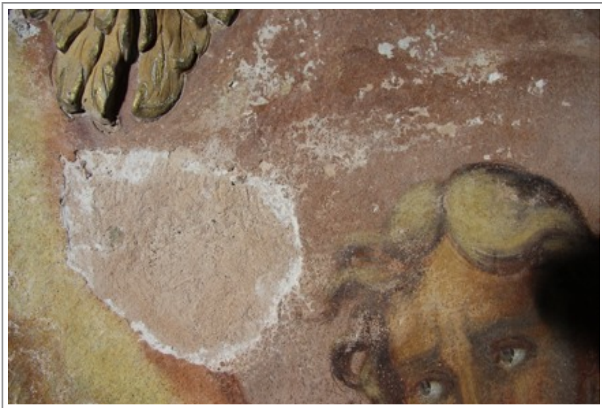
Obr. č. 33 Horní část výjevu, stav po injektáži ohroženého intonaca
