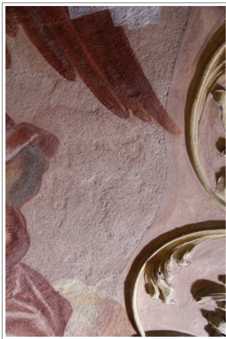
Obr. č. 24 Detail výjevu, snímek v razantní bočním osvětlení: rozdílné struktury omítek
