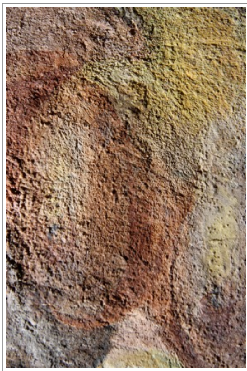
Obr. č. 25 Detail baziliška, snímek v razantní bočním osvětlení: hrubá struktura omítky
