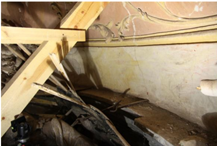
Obr. 138 Část iluzivního pásu mraků mezi výjevy Cherubim a Seraphim, defekt, vzorek M1.
