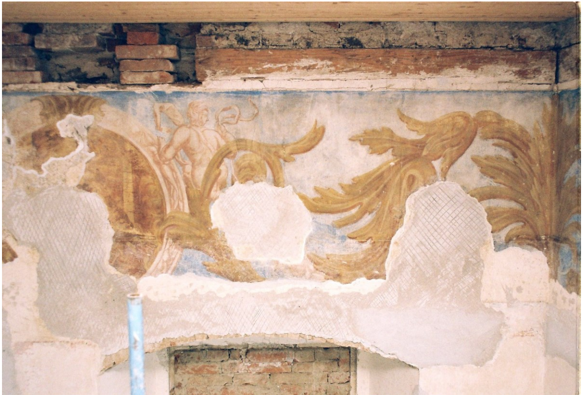
Obr. 18: Malby na východní stěně vpravo v průběhu tmelení defektů.
