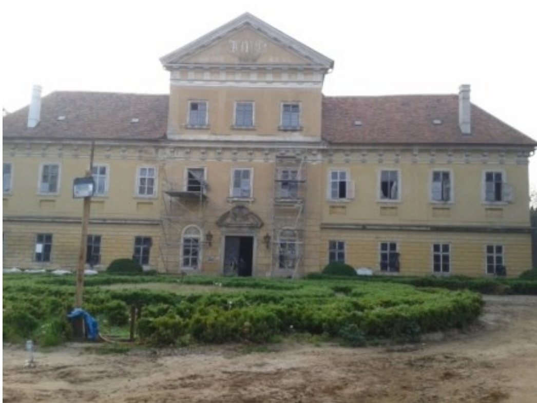
Obr. 17: Průčelí zámku Žehušice začátkem momentálně probíhající rekonstrukce.
