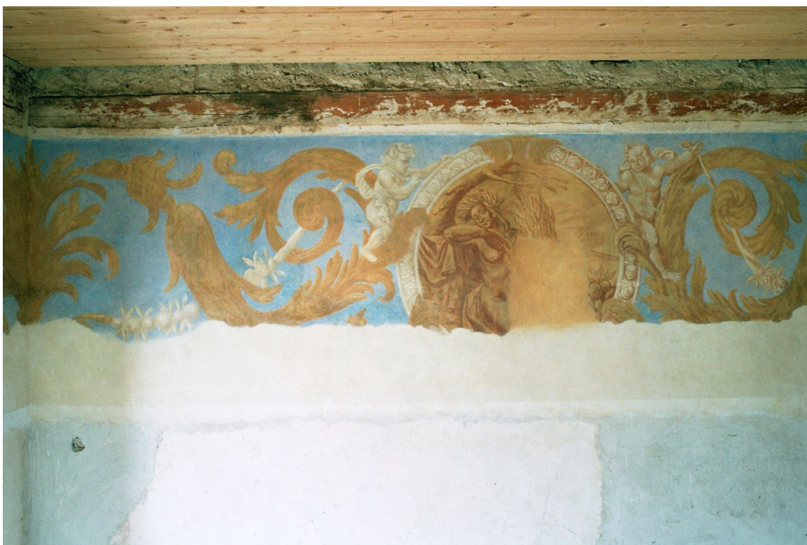
Obr. 31: Zbývající část výzdoby místnosti – zrestaurované malby na západní stěně.
