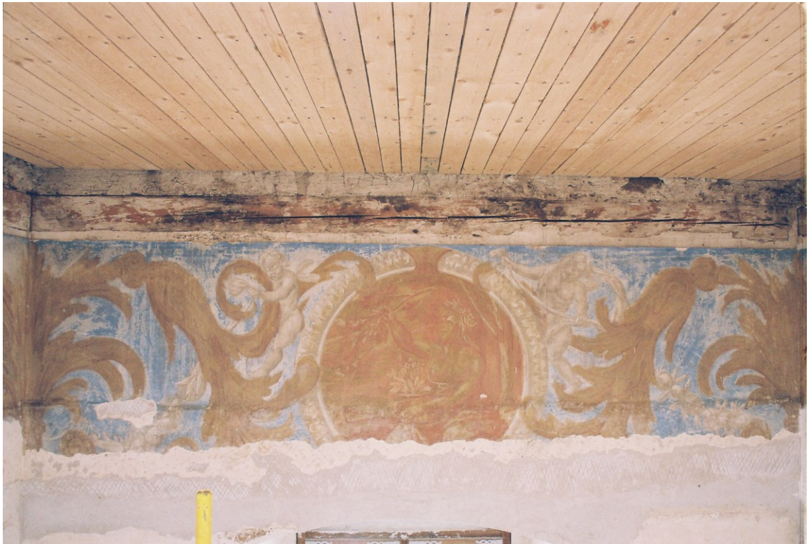
Obr. 20: Malby na jižní stěně v průběhu tmelení defektů.
