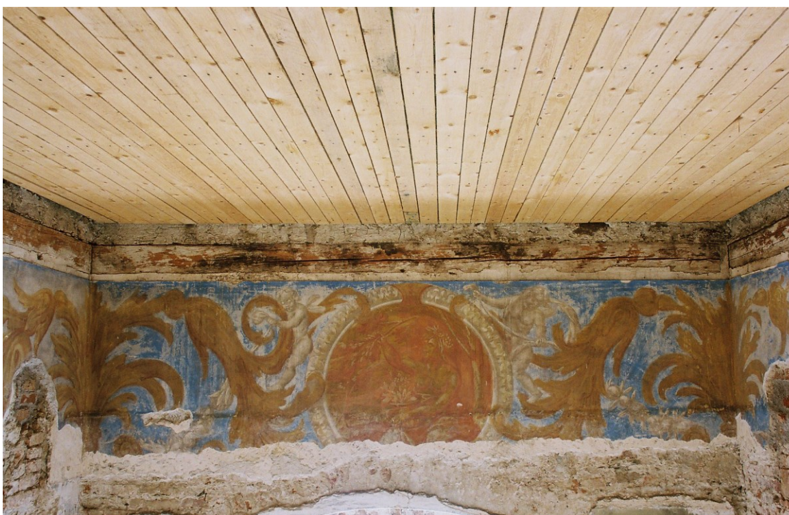
Obr. 15: Jižní stěna – malby po očištění a fixáži barevné vrstvy.
