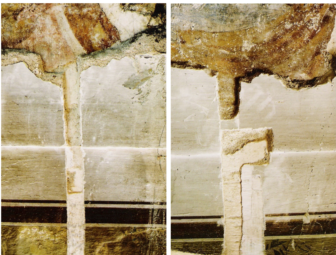
Obr. 6, 7: Sondy S 2 (vlevo) a S 1 (vpravo) na východní stěně neprokázaly stopy po osekané římsě, která by vymezovala spodní okraj pásu s malbami.
