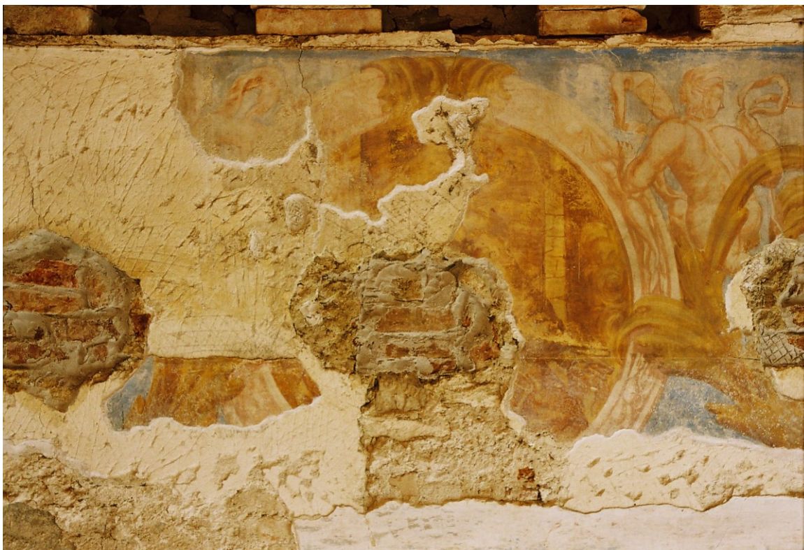
Obr. 14: Povrchově očištěná a zafixovaná malba centrálního medailonu na východní stěně s dozdívkou otvorů po trámech.
