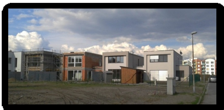
Obrázek 30: Nová výstavba, Dubina
