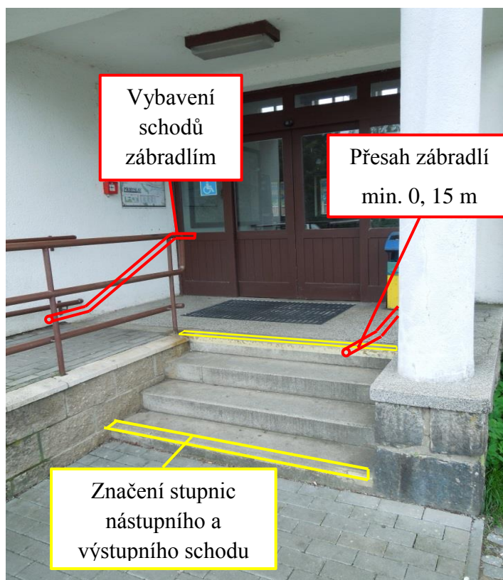
Obr. 16 Schodiště hlavního vchodu odbavovací haly Zdroj: Autor
