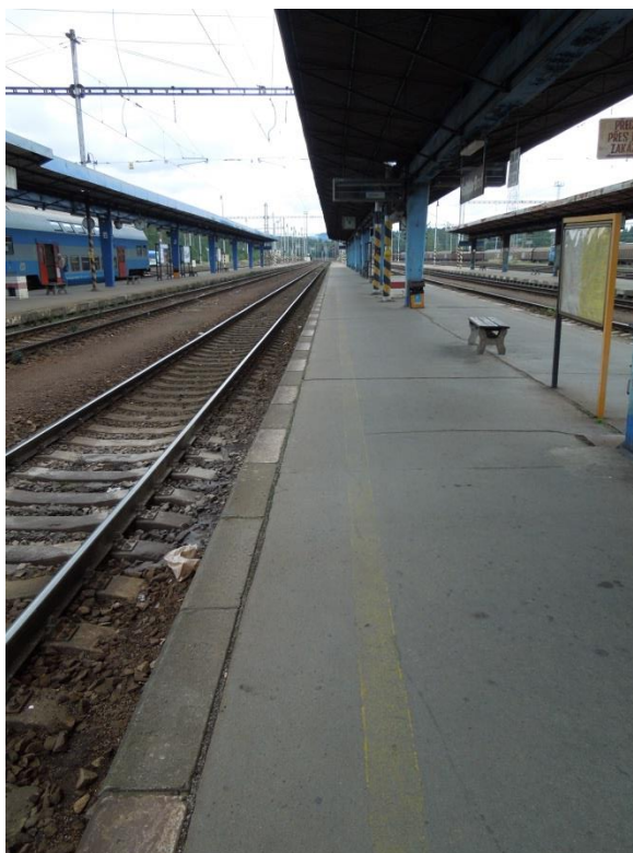
Obr. 6 Absence hmatně kontrastních prvků na nástupištích
