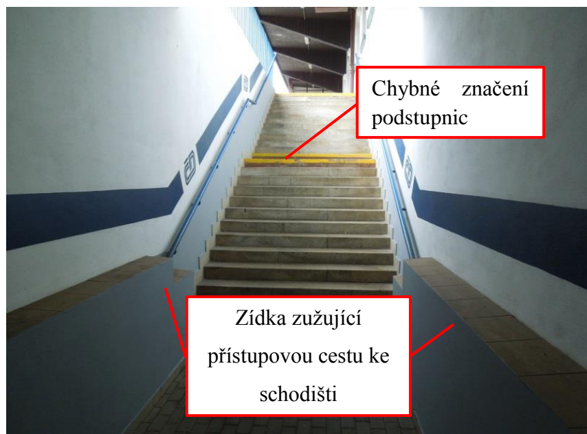
Obr. 17 Zavazující zídka pod schodištěm
