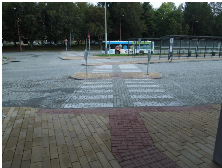
Obr. 19 Varovný a signální pás přechodu pro chodce
