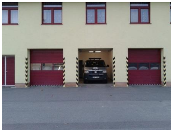
Obr. 7 Garáže pro služební vozidla
