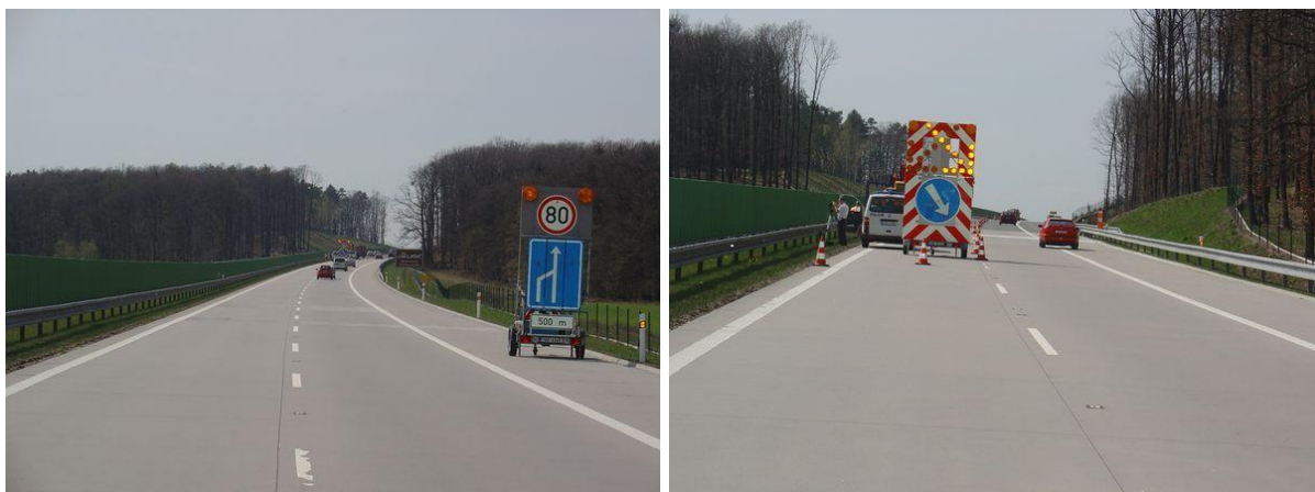
Obr. 27 Zabezpečení místa nehody přenosným dopravním značením
