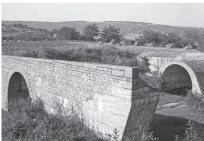
Obrázek č. 4: Nedokončený parabolický most u Ostopovic
