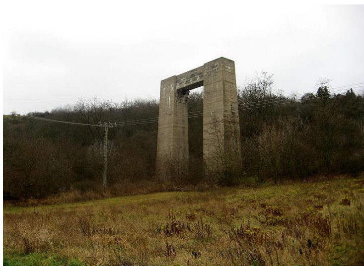
Obrázek č. 3: Betonový pilíř mostu u Brněnské přehrady
